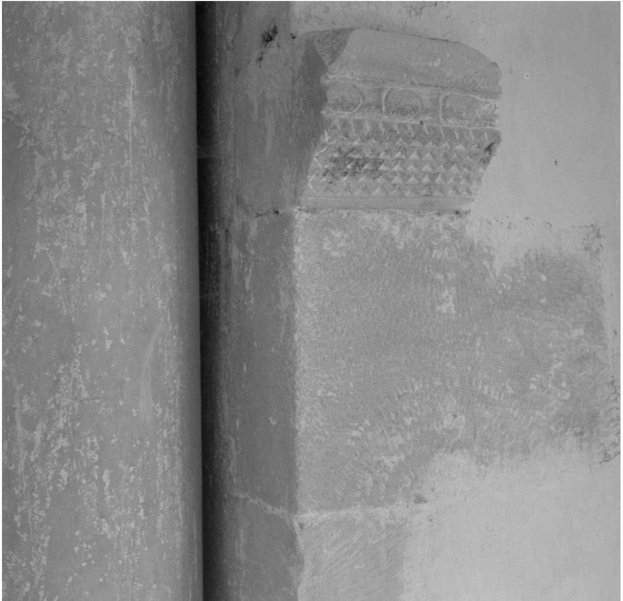
Nef, 2e travée, côté sud : imposte sud-est supportant la retombée de l'arc formeret.
