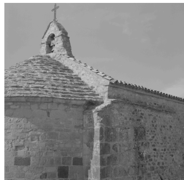
Vue partielle prise du nord-est : détail des parties hautes du mur gouttereau et de l'abside, et clocher-mur. Phot. Alain Franchella IVR82_19992600015X
