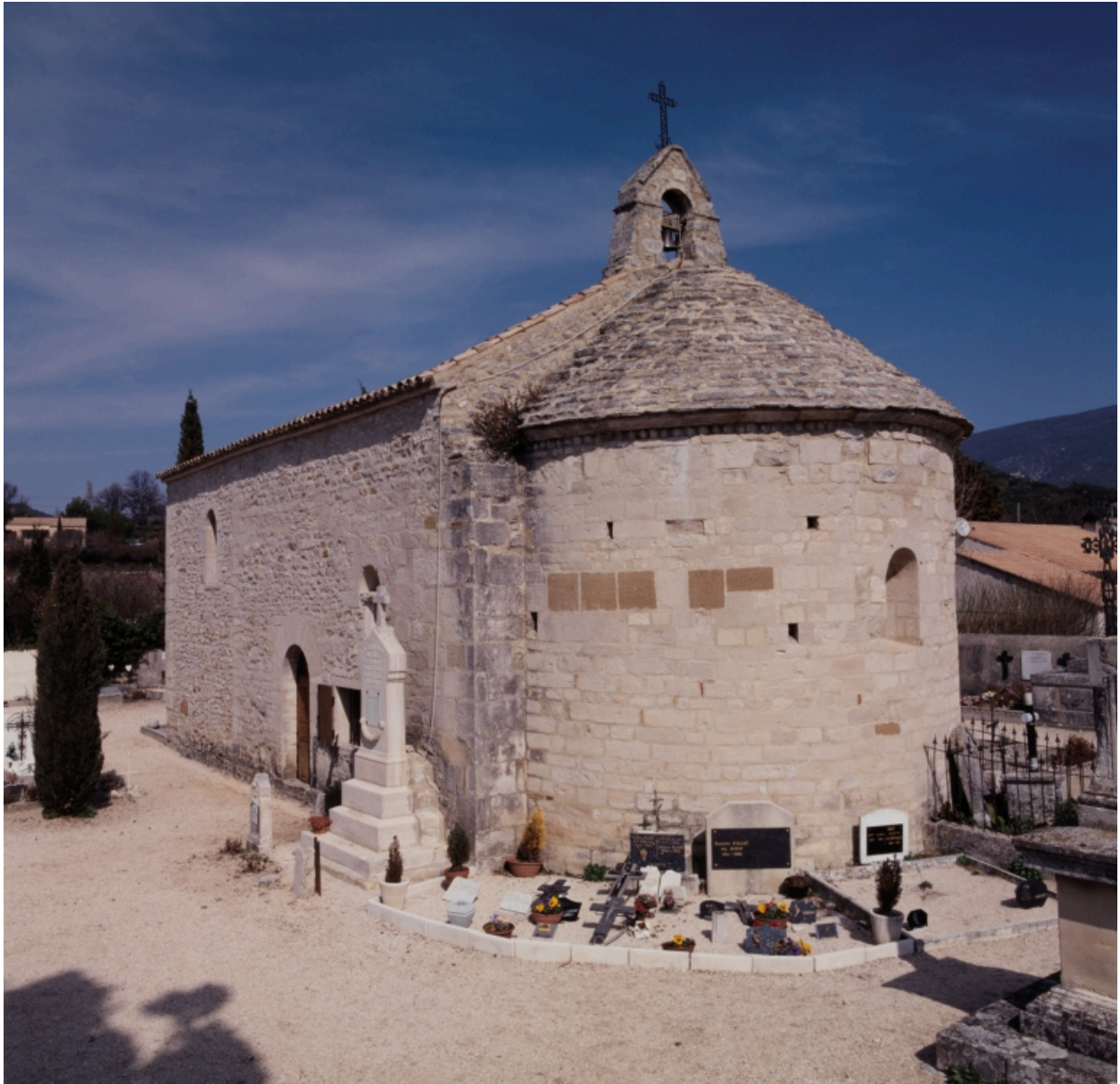
Vue d'ensemble du côté du chevet, prise du sud-est.
