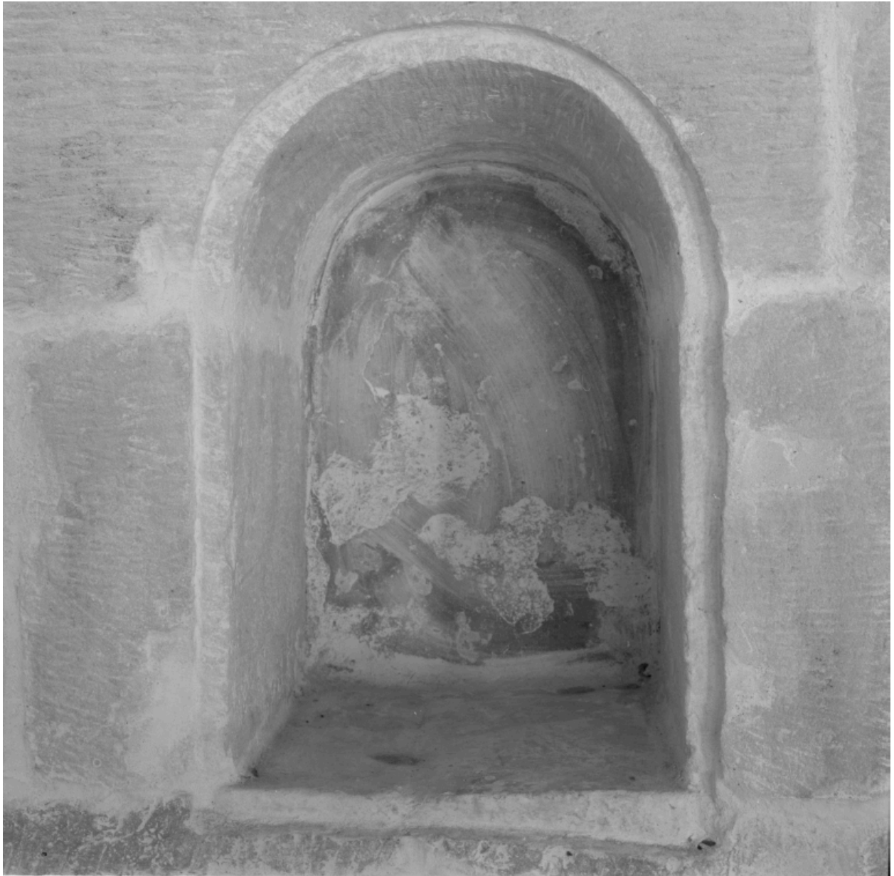
Détail de l'abside, côté gauche : lavabo en niche, en pendant avec l'armoire eucharistique du côté droit.
