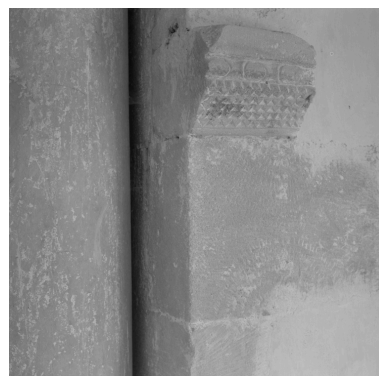
Nef, 2e travée, côté sud : imposte sud-est supportant la retombée de l'arc formeret. Phot. Alain Franchella IVR82_19992600012X
