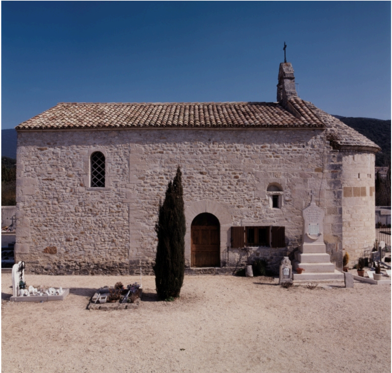
Elévation latérale sud.
