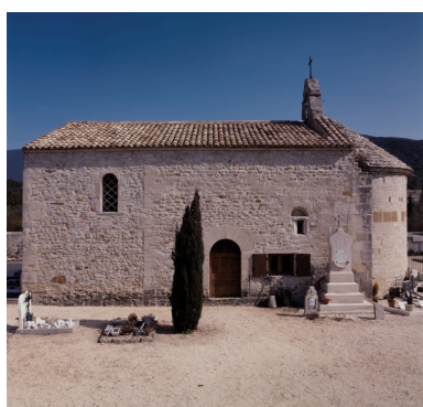
Élévation latérale sud. Phot. Alain Franchella IVR82_19992600022XA
