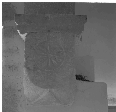
Corbeau gravé d'une rouelle, recevant les retombées des arcs formerets sud. Phot. Alain Franchella IVR82_19992600003X
