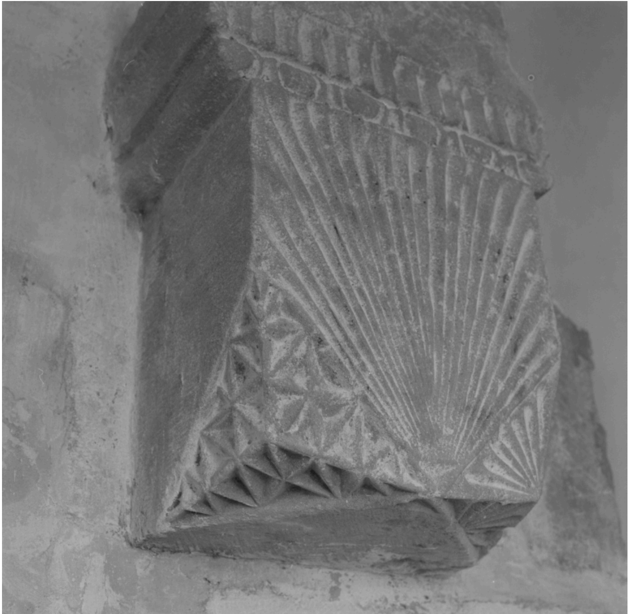
Corbeau à décor géométrique, recevant les retombées des arcs formerets nord, vue du côté gauche.
