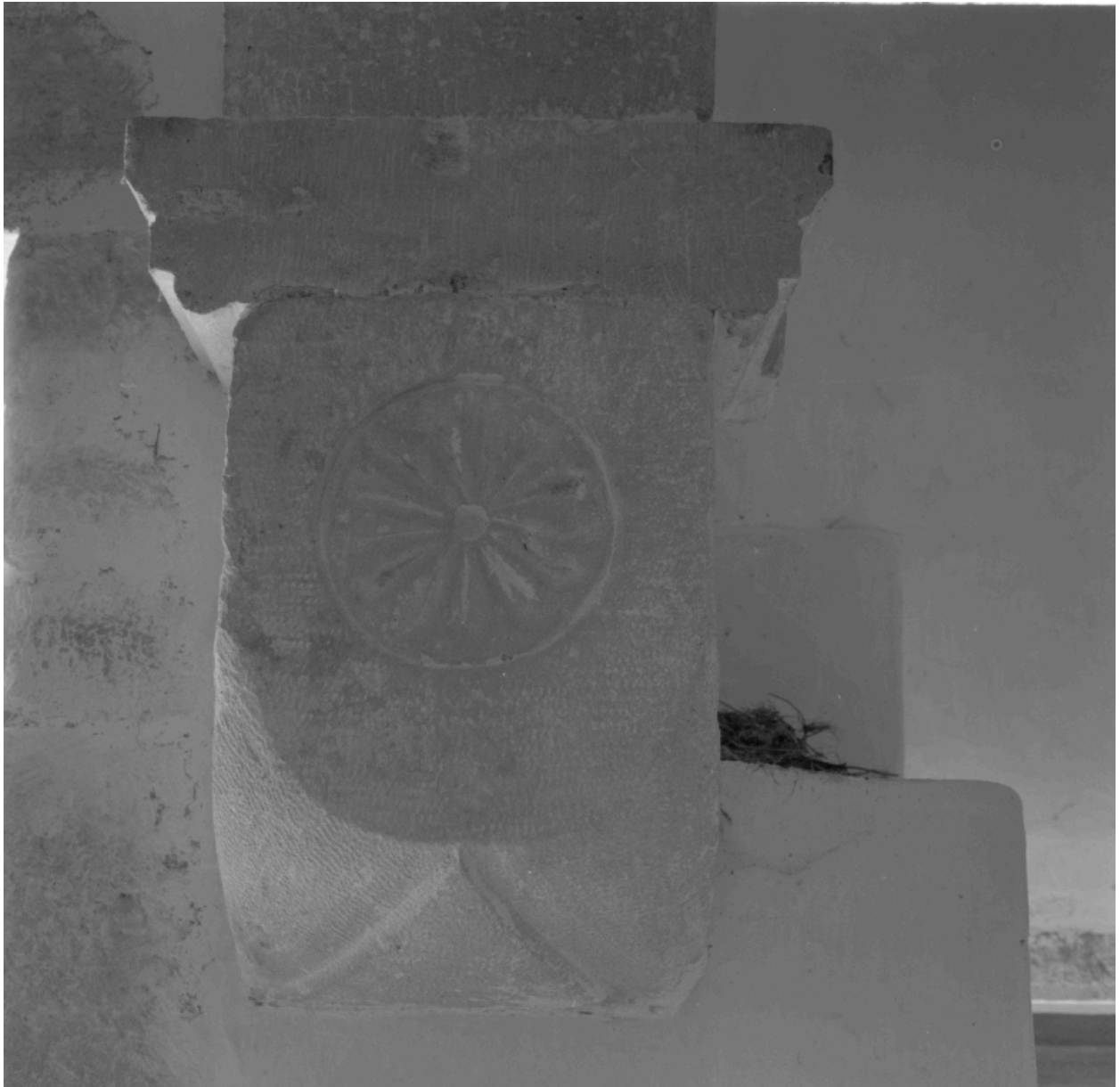
Corbeau gravé d'une rouelle, recevant les retombées des arcs formerets sud.
