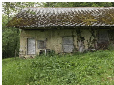
Vue depuis le sud. Phot. Eric Dessert IVR82_20137302064NUCA
