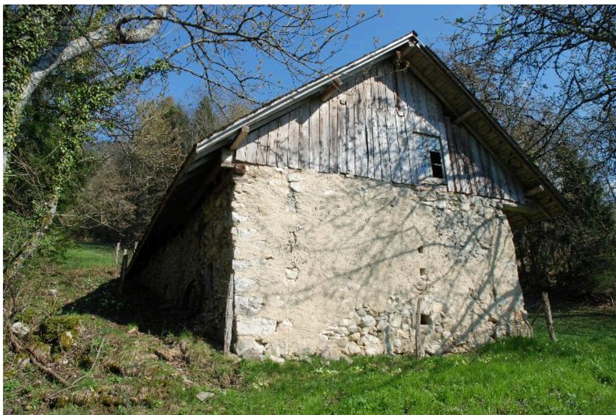
Vue du mur pignon aval.
