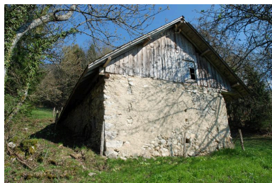
Vue du mur pignon aval. Phot. Thierry Monnet IVR82_20147302244NUCA
