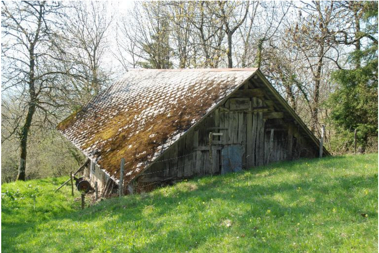
Vue du pignon amont.
