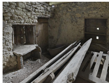
Vue intérieure du logis : cuisine. Phot. Eric Dessert IVR82_20137302061NUCAQ
