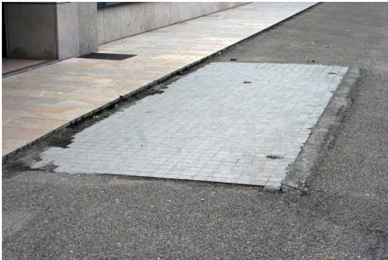
Socle d'un des portiques
