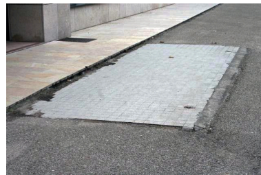
Socle d'un des portiques Phot. Ecole Saint-Luc, Liège IVR84_20220100348NUCA
