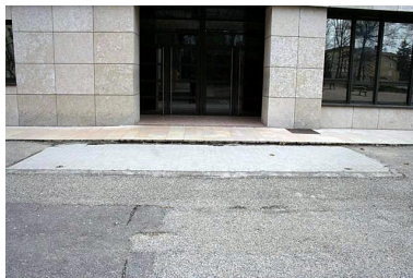
Emplacement d'un des portiques Phot. Ecole Saint-Luc, Liège IVR84_20220100349NUCA
