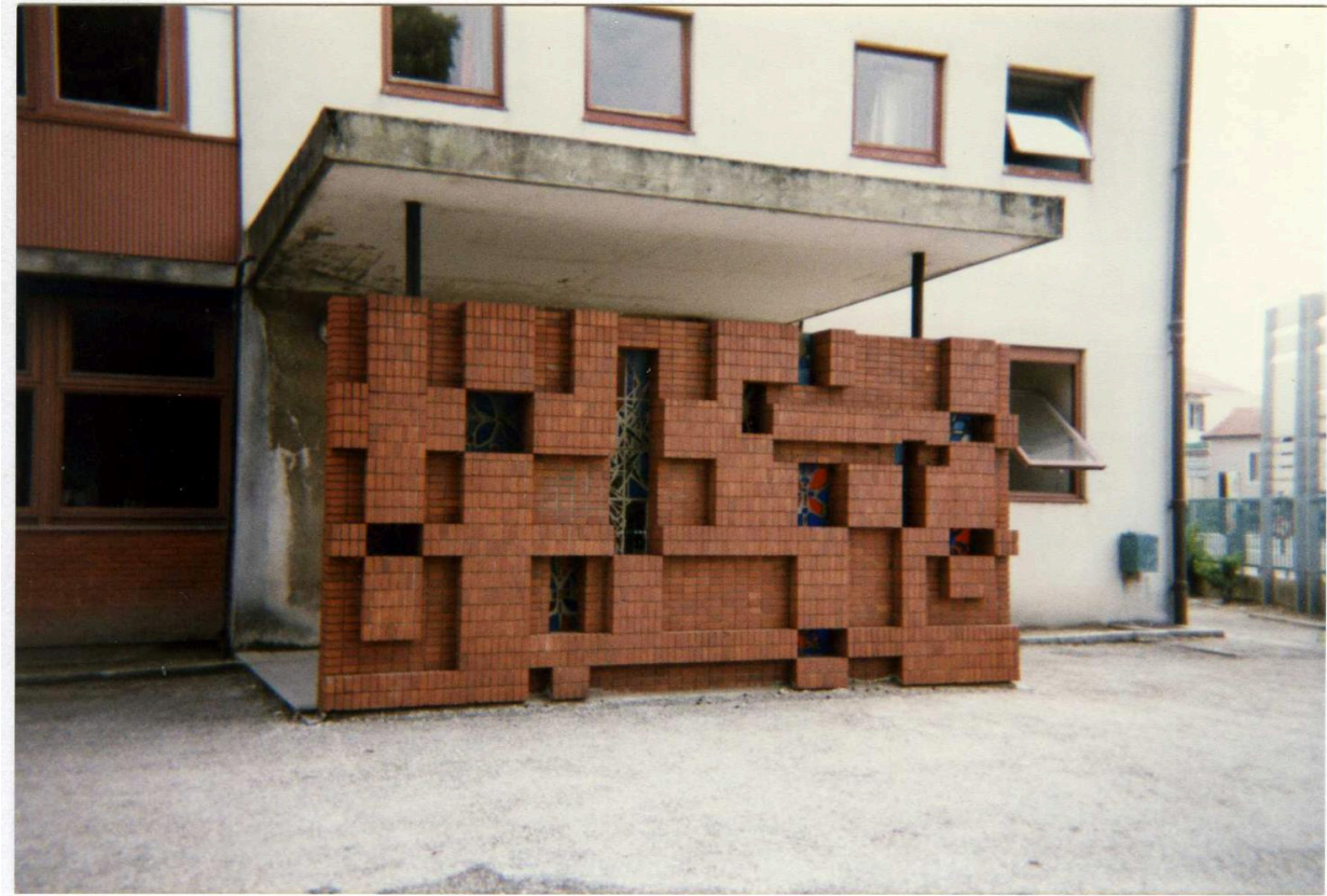
Vue d'ensemble d'un des deux portiques en 1996, avant dépose (Phot. C. Peillod)
