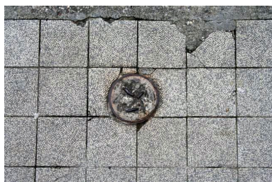
Détail des carrelages restant et de la base d'un pilier faisant partie de la structure. Phot. Ecole Saint-Luc, Liège IVR84_20220100347NUCA
