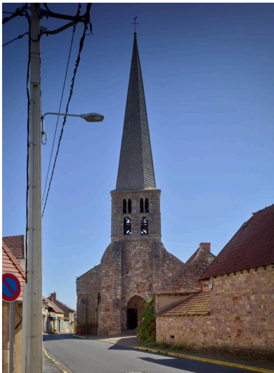
Vue générale de la façade occidentale
