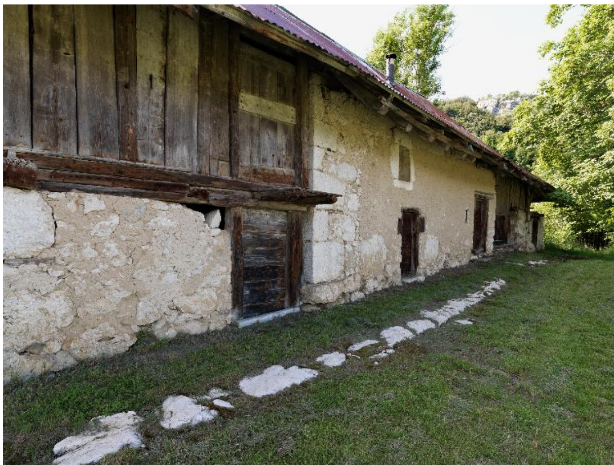
Vue d'ensemble de la façade principale.
