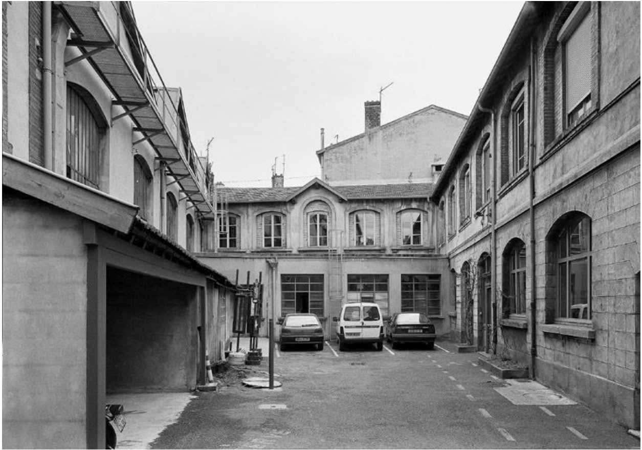
Cour intérieure, vue nord
