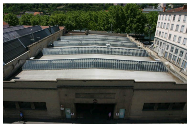
Toit du petit dépôt, vue est Phot. Rémi Dassié IVR82_20036901600NUCA
