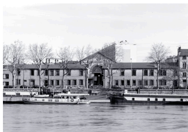
Vue depuis l'ouest, rive droite de la Saône Phot. Eric Dessert IVR82_20026903038X
