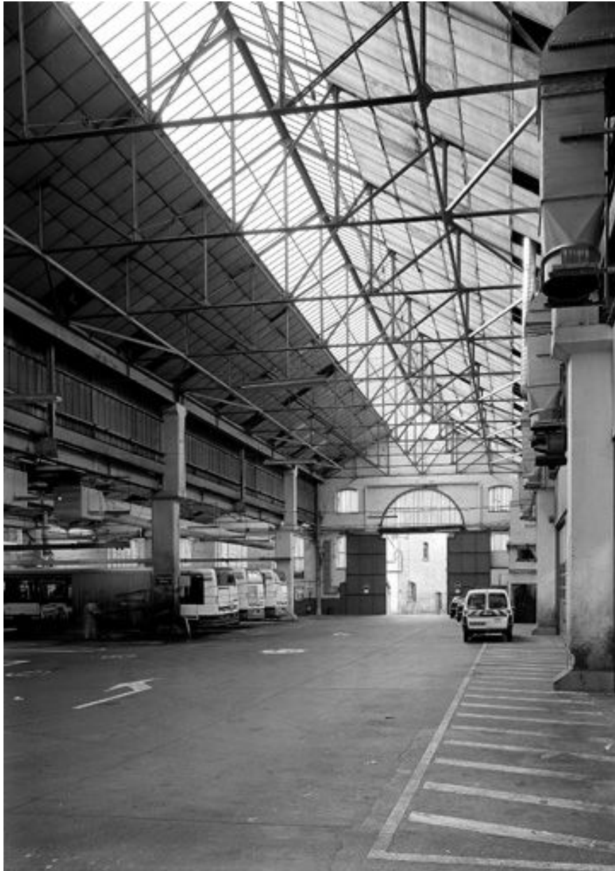
Halle de montage, vue intérieure est
