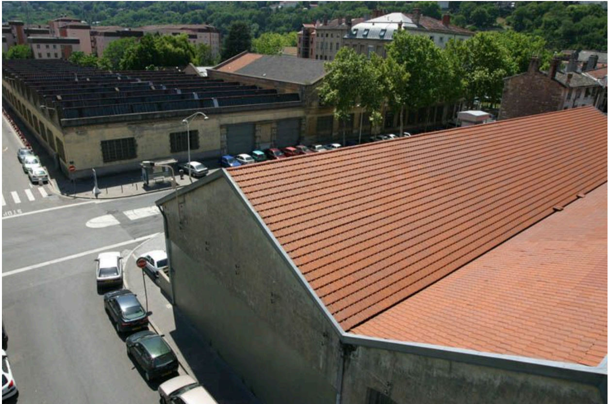
Extension sud de 1916
