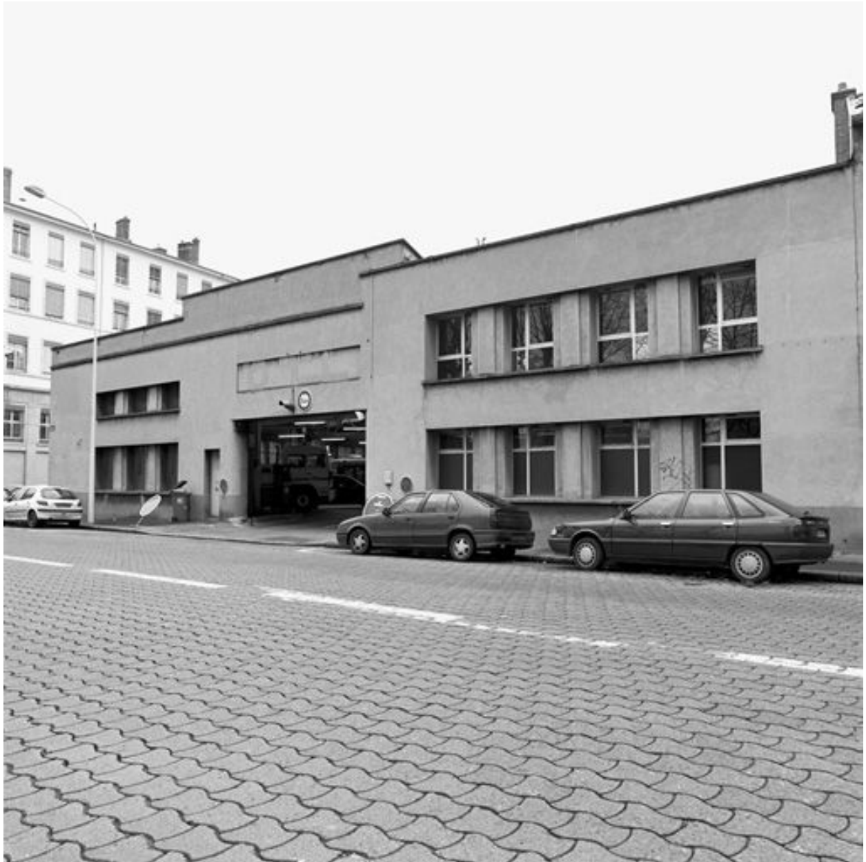
Dépôt nord dit petit dépôt, vue ouest avec enseigne, extension de 1936
