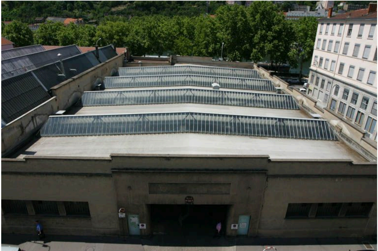
Toit du petit dépôt, vue est
