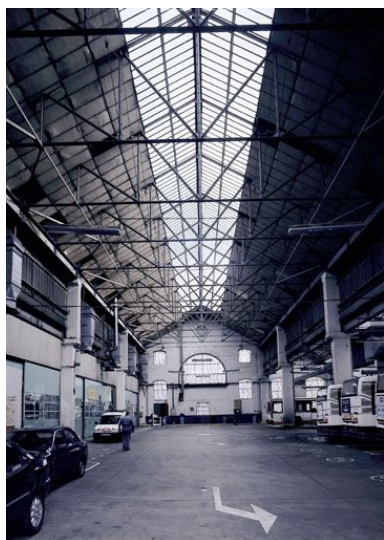
Halle de montage, vue intérieure ouest Phot. Martial Couderette IVR82_20016900543PA
