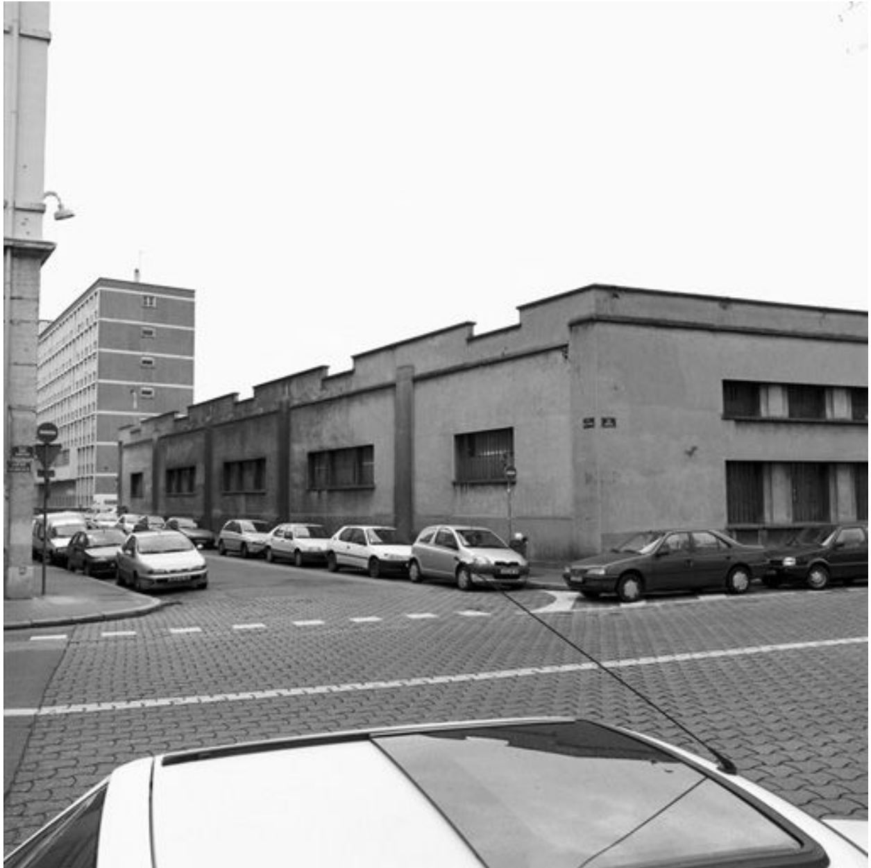
Dépôt nord dit petit dépôt, vue nord-ouest, extension de 1936
