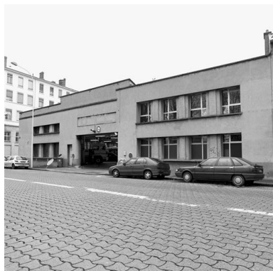
Dépôt nord dit petit dépôt, vue ouest avec enseigne, extension de 1936 Phot. Martial Couderette IVR82_20016900584X
