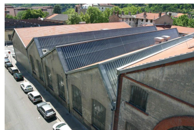
Vue sud Phot. Rémi Dassié IVR82_20036901602NUCA
