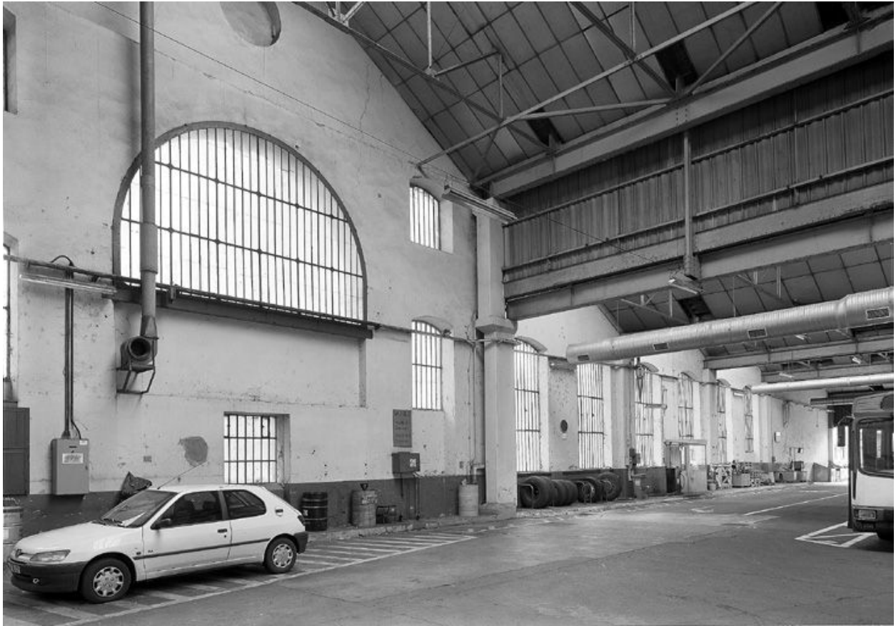
Halle de montage, vue intérieure nord-ouest
