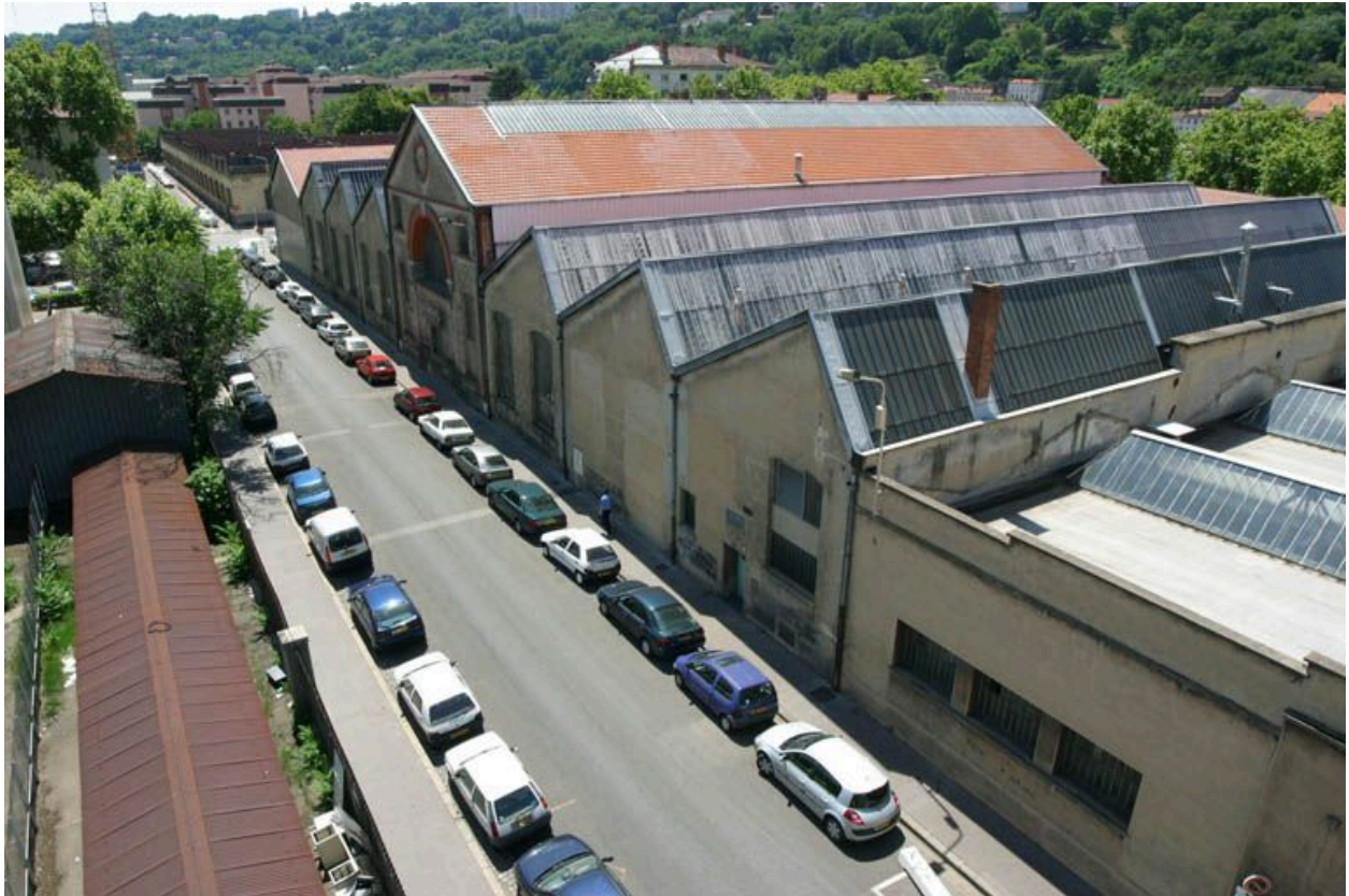
Bâtiment d'origine, vue nord-est
