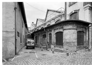
Cour intérieure, vue sud Phot. Martial Couderette IVR82_20016900541P
