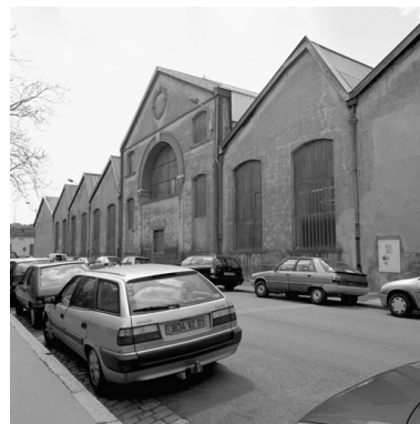
Vue nord-est du site Phot. Martial Couderette IVR82_20006900257X
