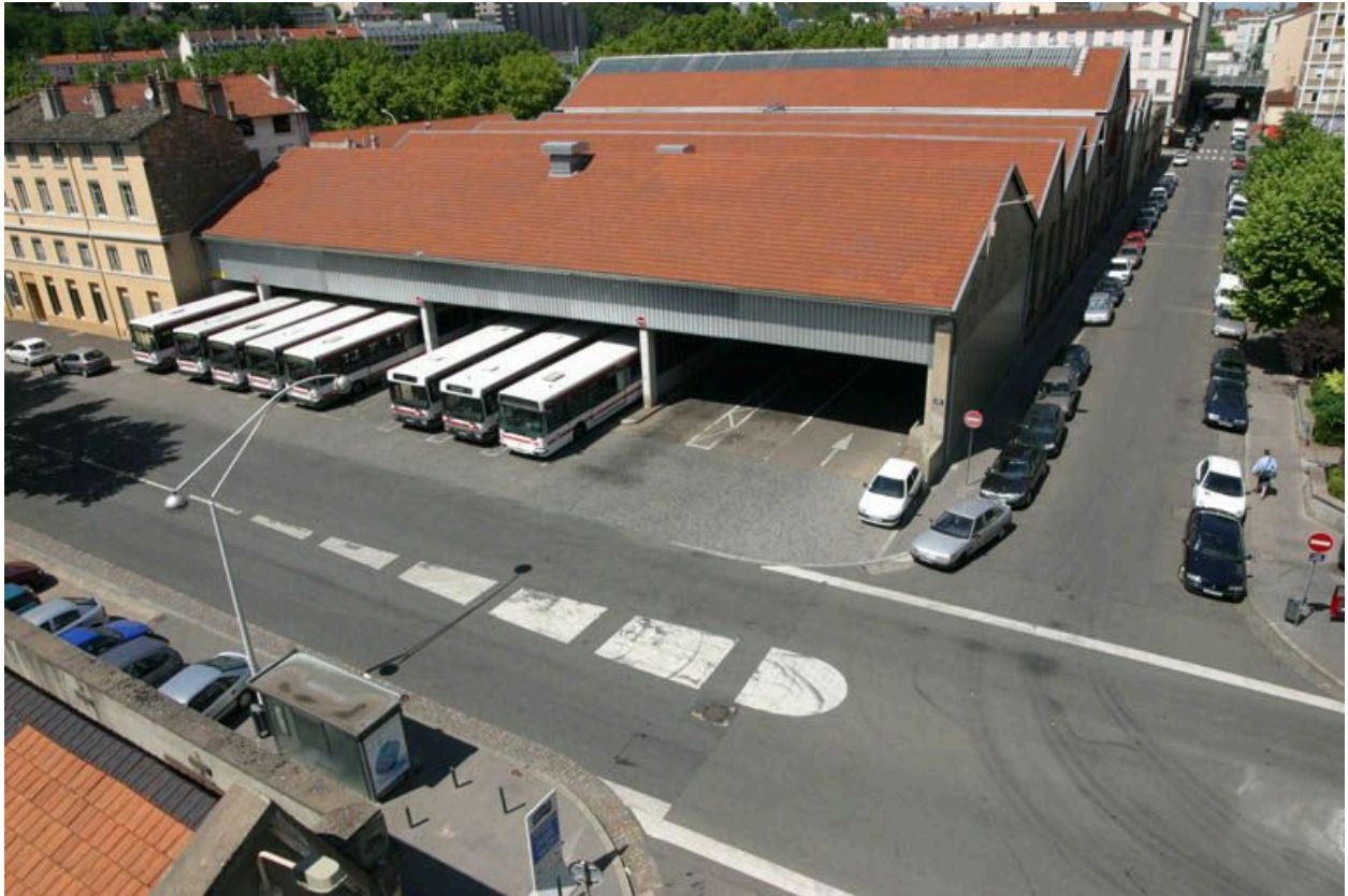
Entrée sud du dépôt de 1916, sur le cours Suchet
