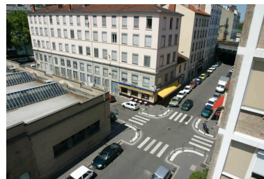
Vue sud-est, angle Dugas Montbel (Zone 360) Phot. Rémi Dassié IVR82_20036901599NUCA
