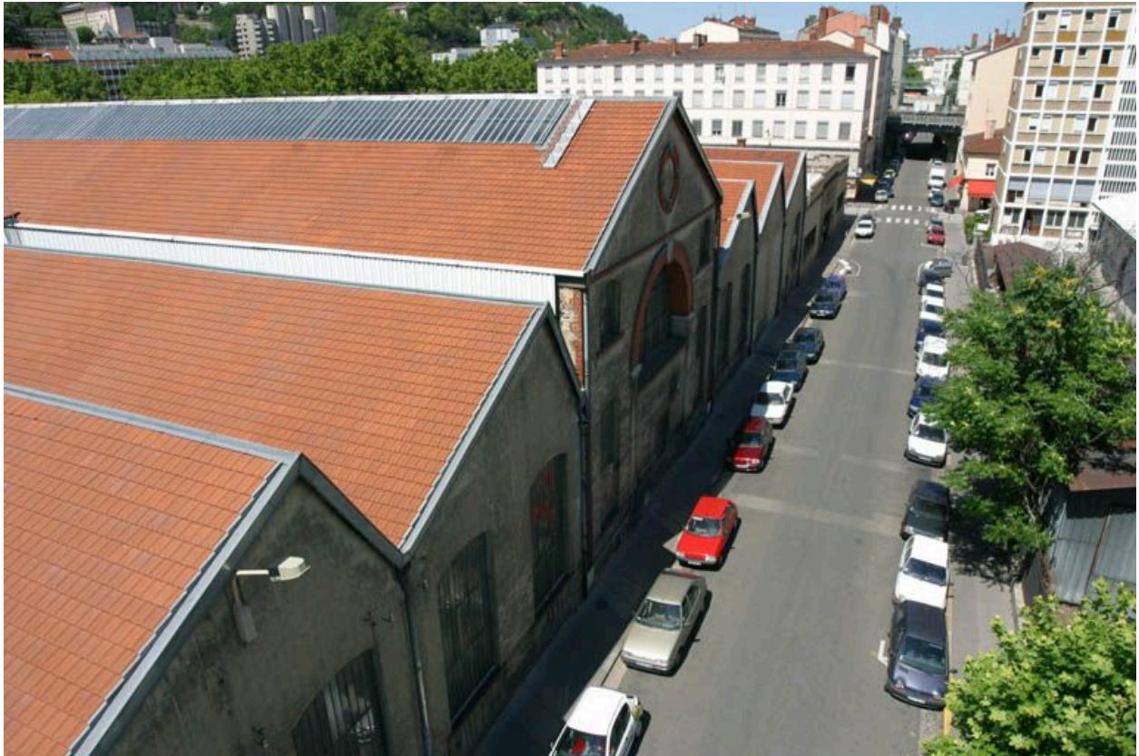
Vue d'ensemble sud
