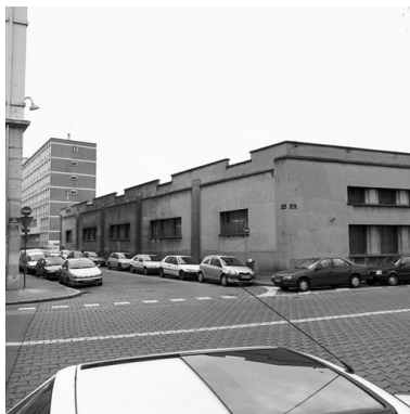
Dépôt nord dit petit dépôt, vue nord-ouest, extension de 1936 Phot. Martial Couderette IVR82_20016900585X
