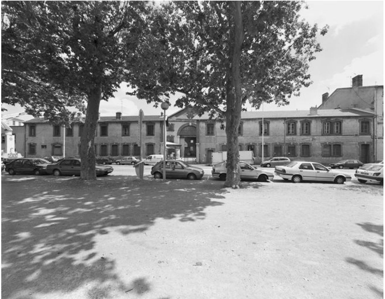
Vue de la façade ouest du quai Rambaud
