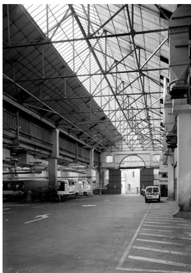
Halle de montage, vue intérieure est Phot. Martial Couderette IVR82_20016900544P
