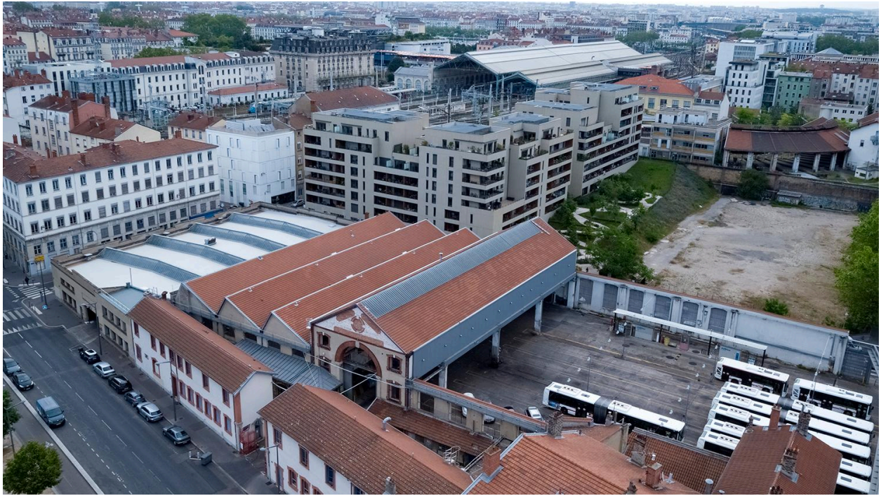
Usine Satre actuellement dépôt TCL (drone)
