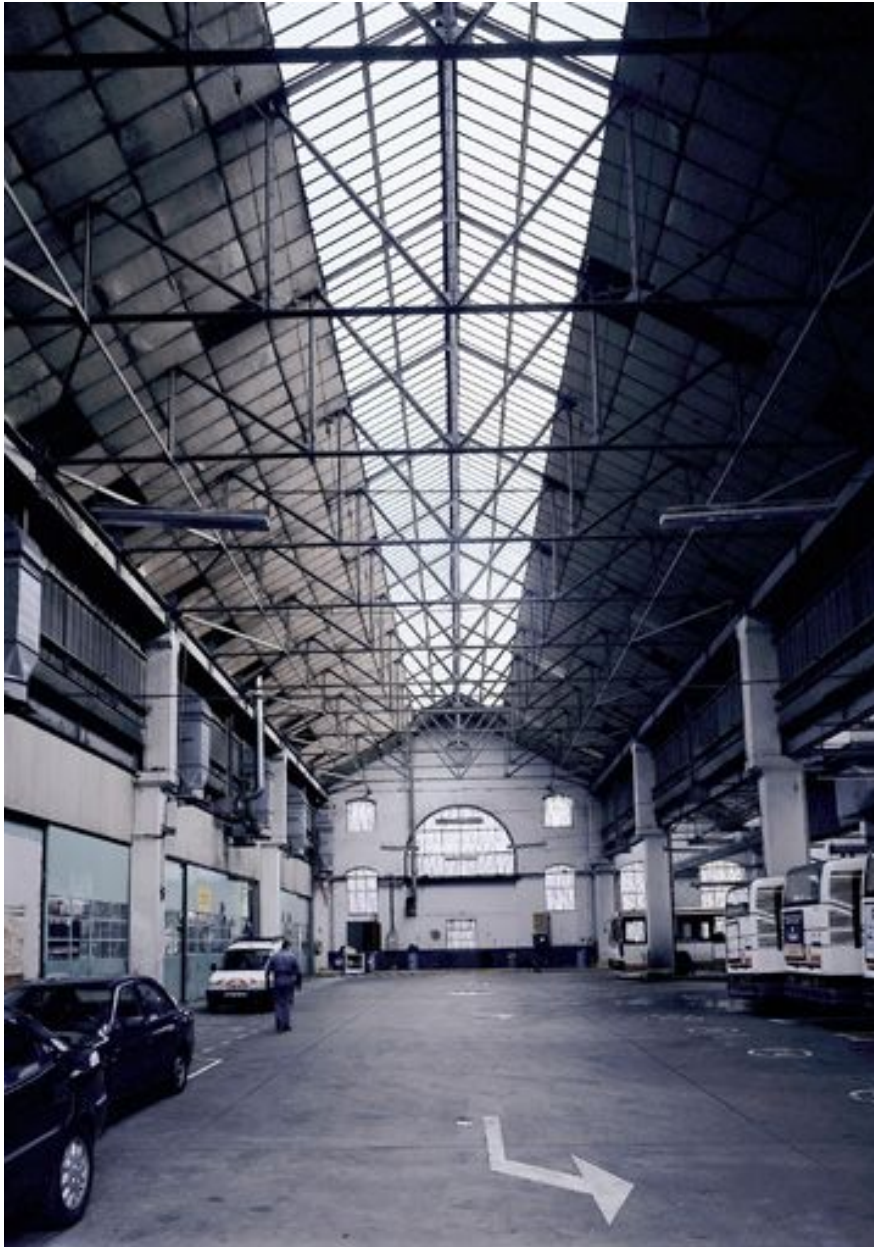
Halle de montage, vue intérieure ouest
