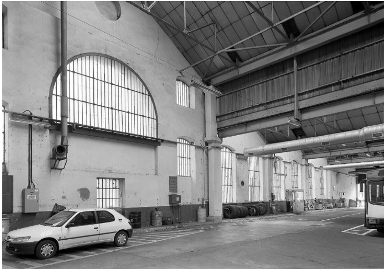
Halle de montage, vue intérieure nord-ouest
