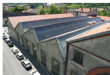
Vue sud Phot. Rémi Dassié IVR82_20036901602NUCA
