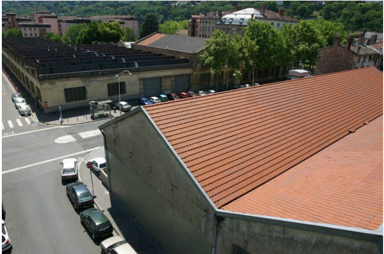
Extension sud de 1916
