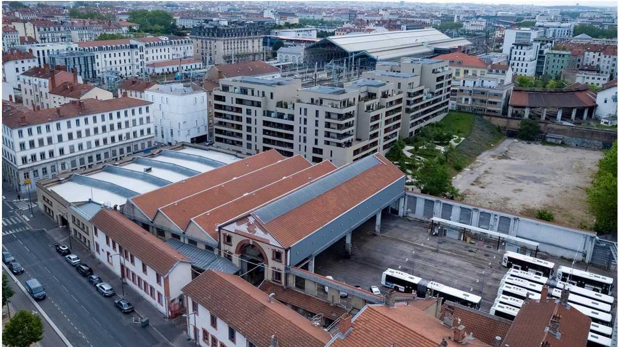
Usine Satre actuellement dépôt TCL (drone)
