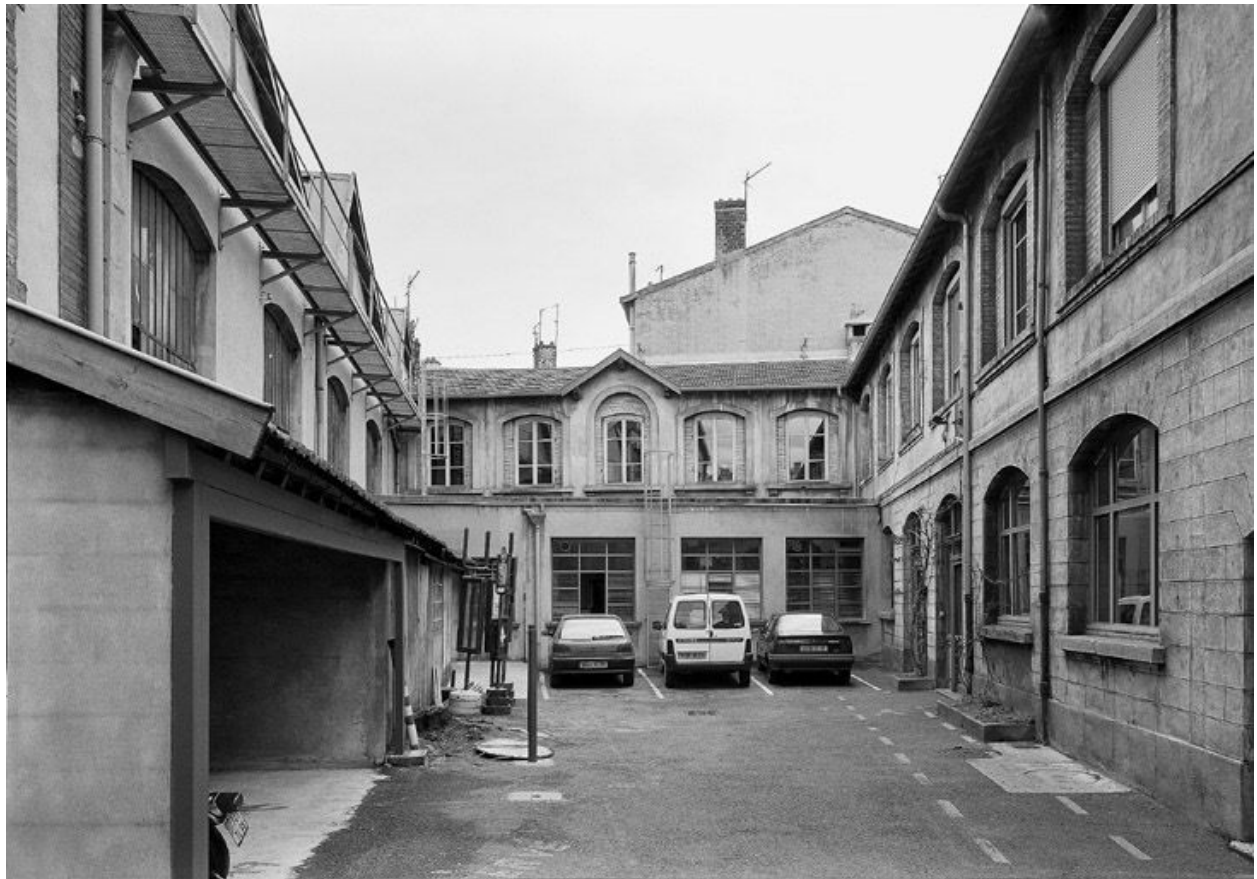
Cour intérieure, vue nord
