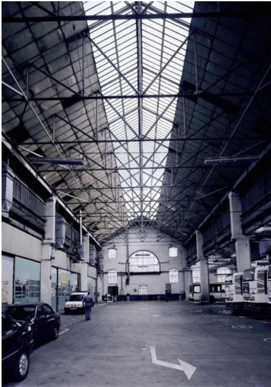
Halle de montage, vue intérieure ouest
