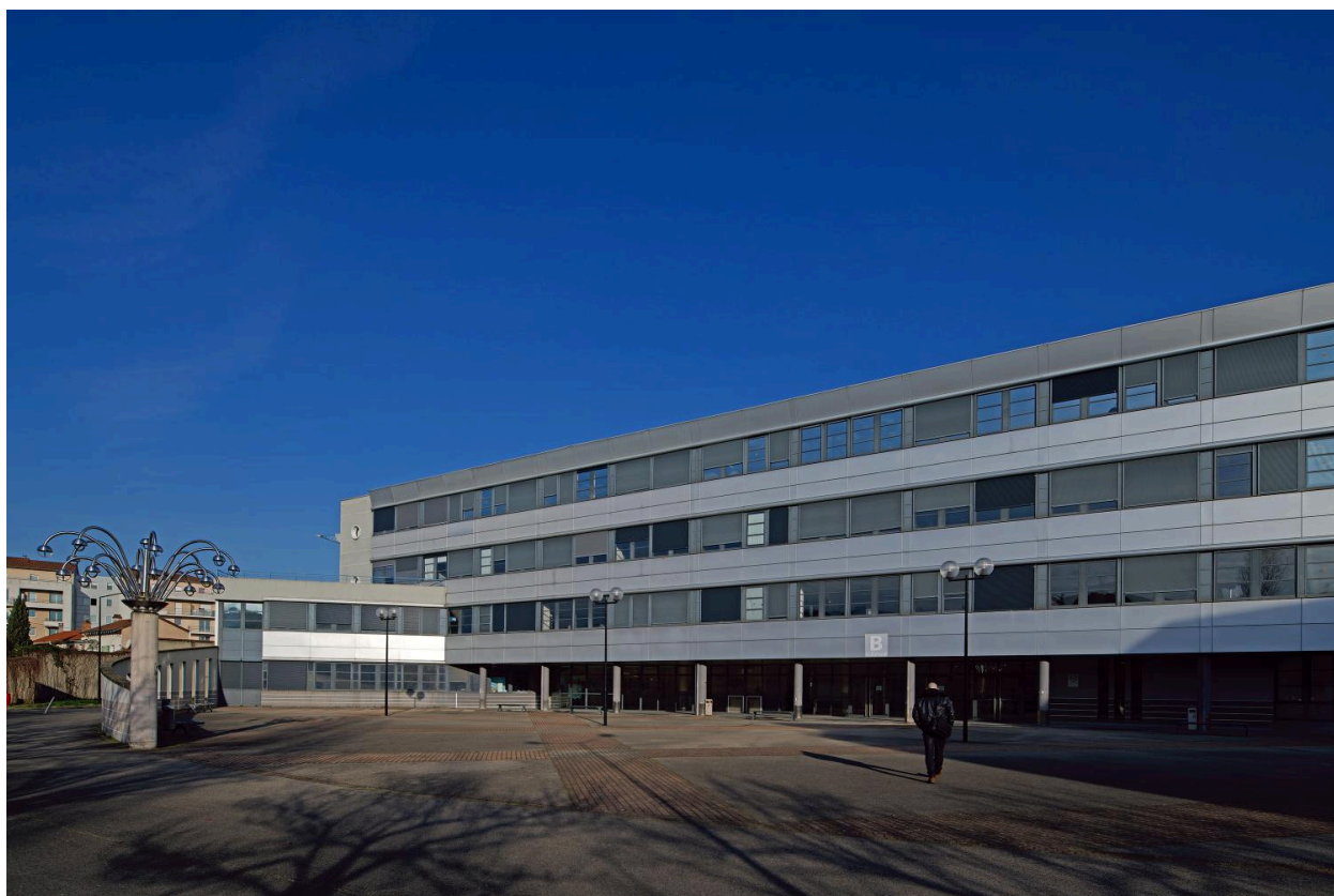
Vue d'ensemble (vers entrée B).
