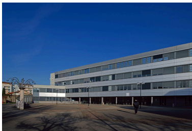
Vue d'ensemble (vers entrée B). Phot. Michel Pérès IVR84_20206900198NUCA
