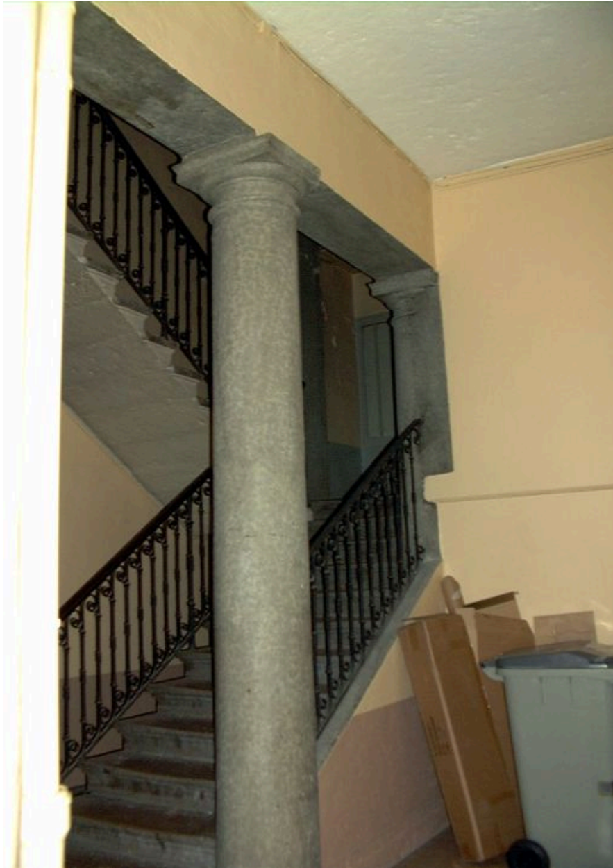
Vue partielle du vestibule et des deux premières volées de l'escalier
