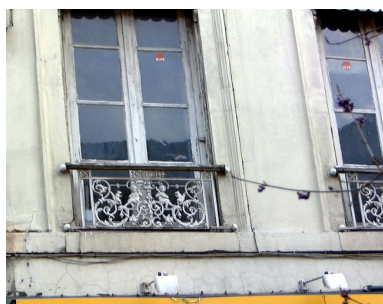
Elévation antérieure : détail d'un garde-corps Phot. Maryannick Chalabi IVR82_20006900369NUCA
