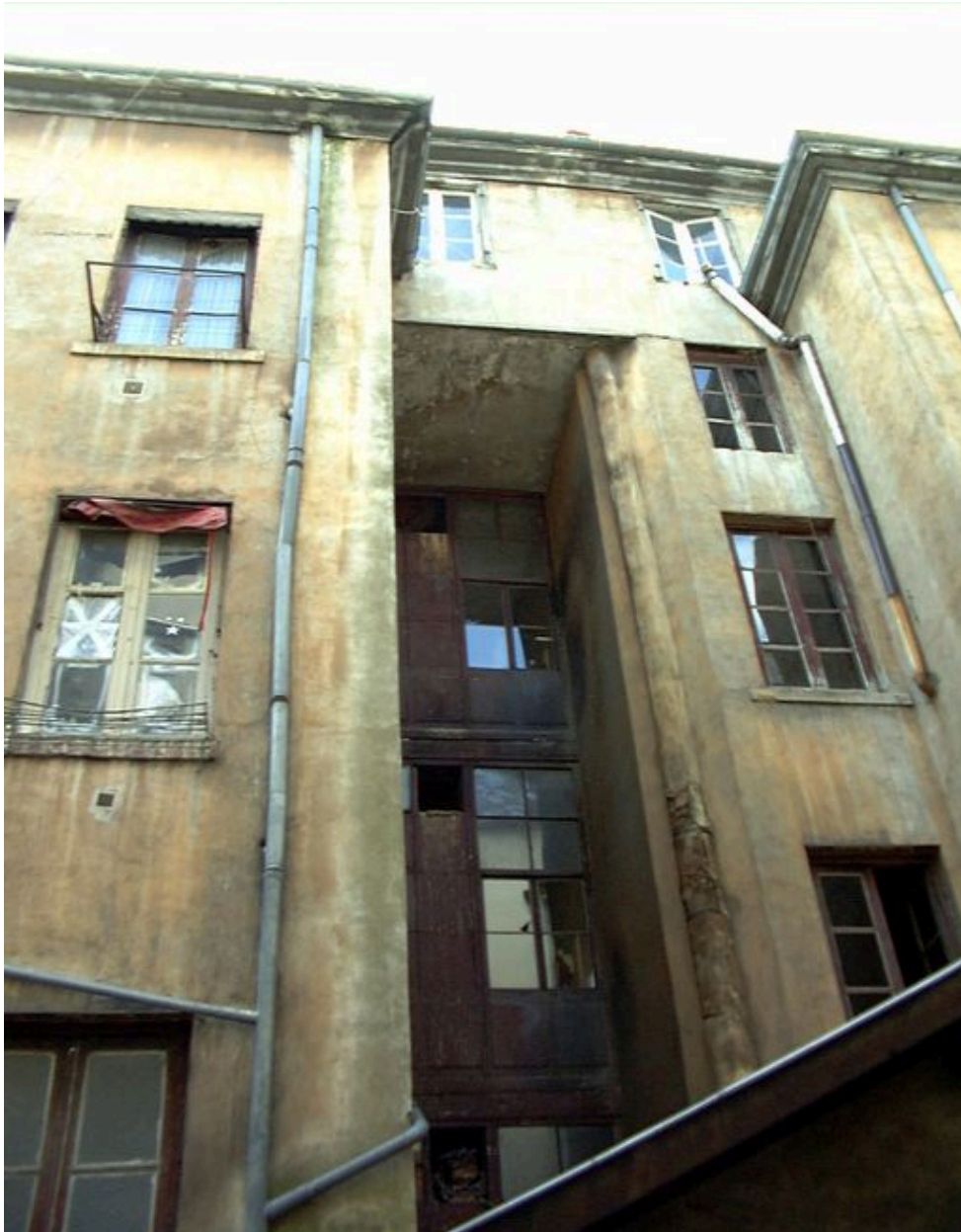
Vue partielle de l'élévation postérieure
