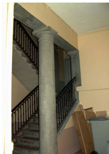
Vue partielle du vestibule et des deux premières volées de l'escalier Phot. Maryannick Chalabi IVR82_20006900370NUCA
