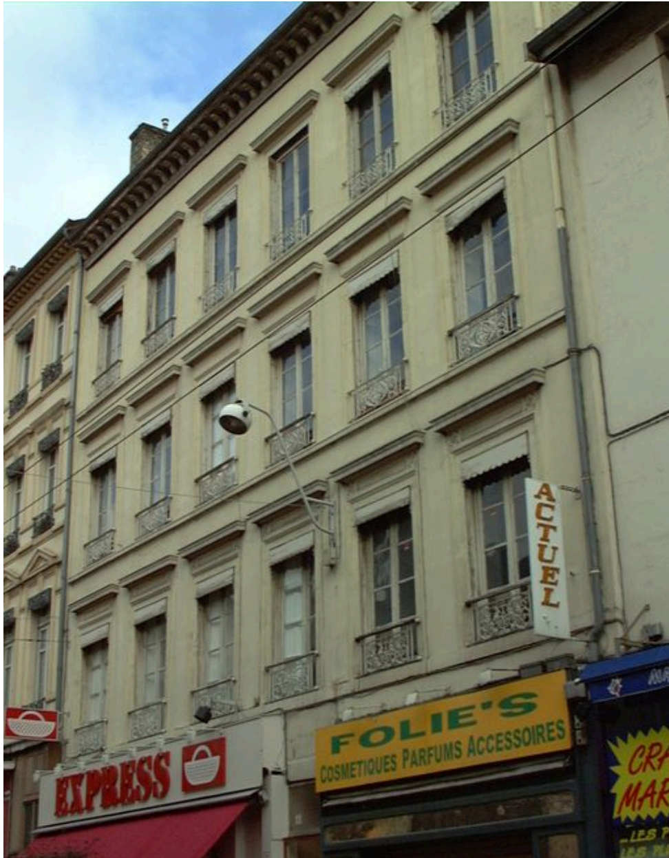
Elévation antérieure : détail des trois étages carrés
