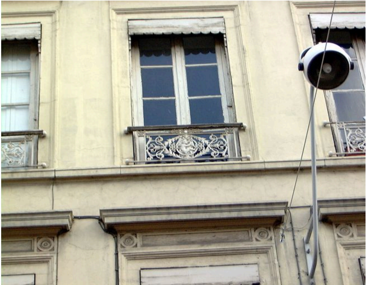
Elévation antérieure : détail d'une fenêtre
