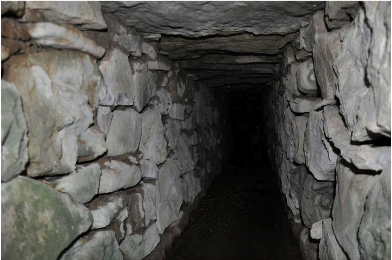
Vue intérieure du canal de fuite
