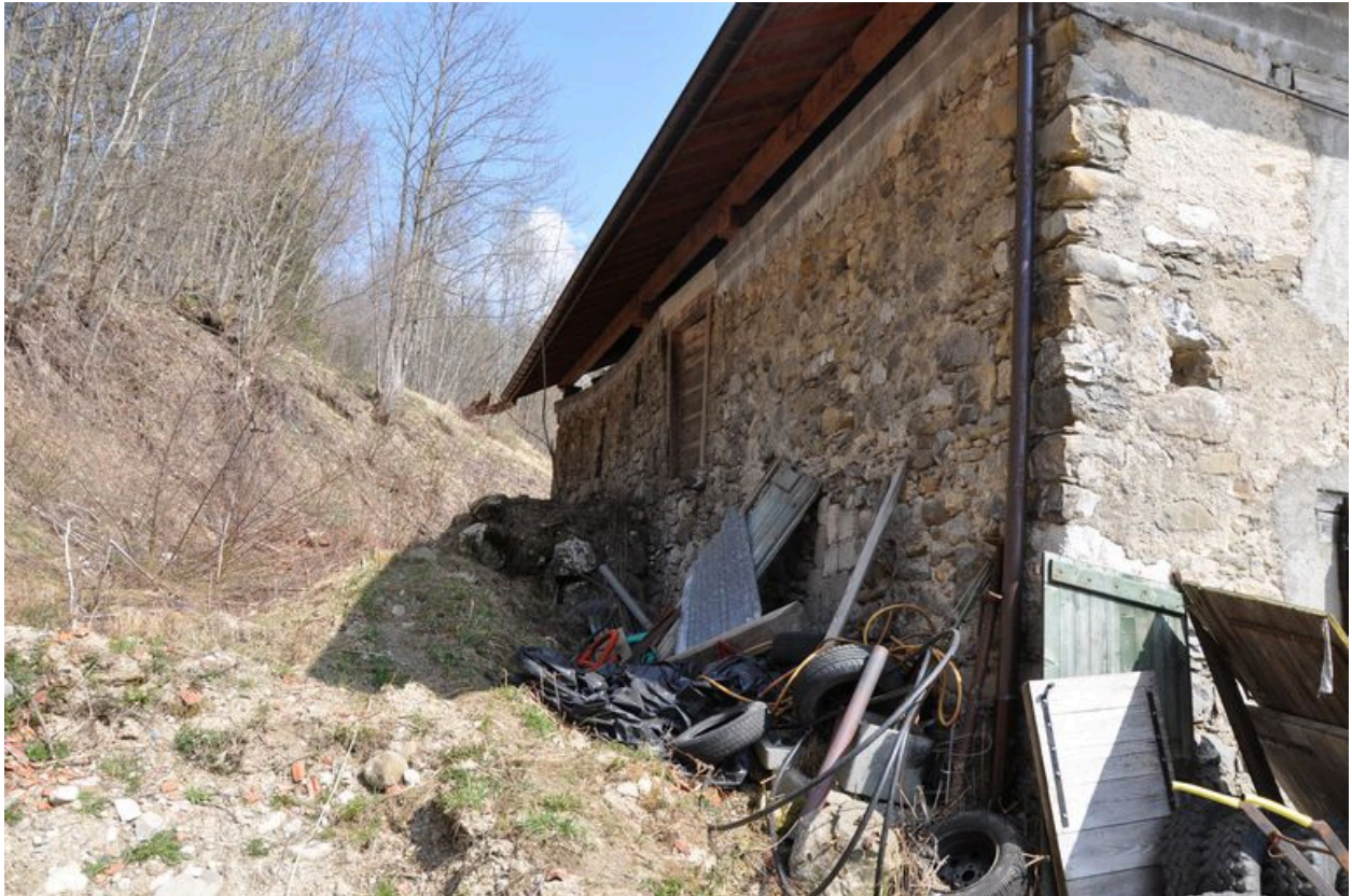
Détail de la façade postérieure de l'ancien bâtiment du moulin
