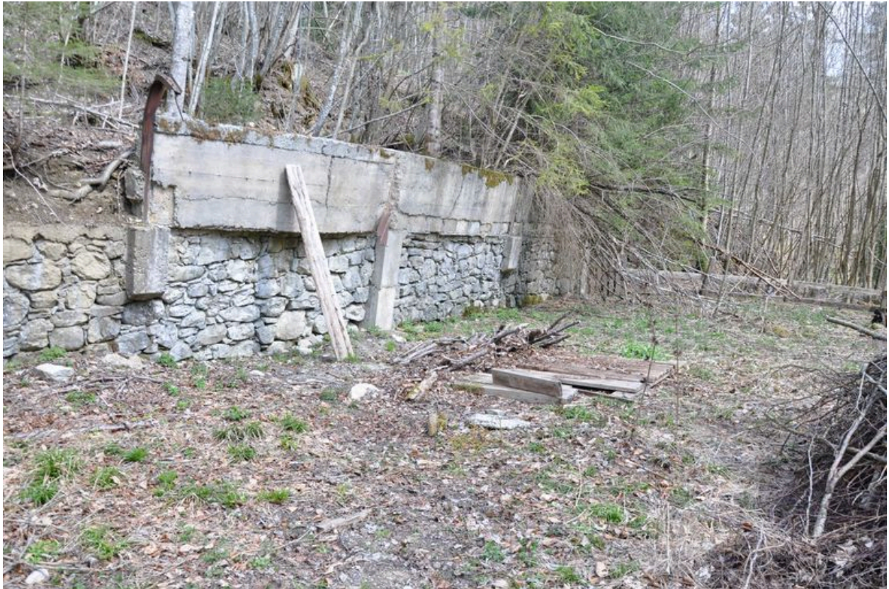
Vestiges du hangar de la scierie
