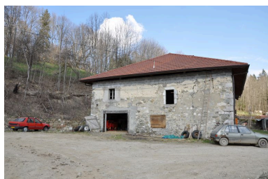
Vue générale Phot. Samir Mahfoudi, Autr. Samir Mahfoudi IVR82_20107400255NUCA
