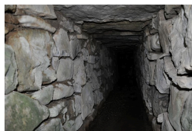
Vue intérieure du canal de fuite Phot. Samir Mahfoudi, Autr. Samir Mahfoudi IVR82_20107400262NUCA
