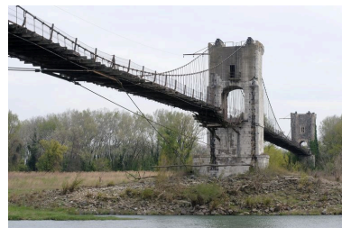
Vue du côté aval (depuis la rive droite)
