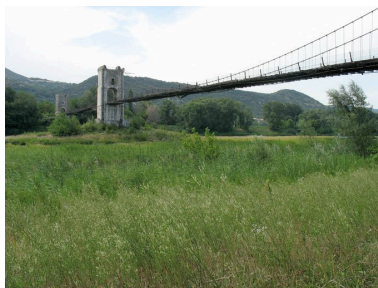
Vue du côté aval (depuis la rive gauche)
