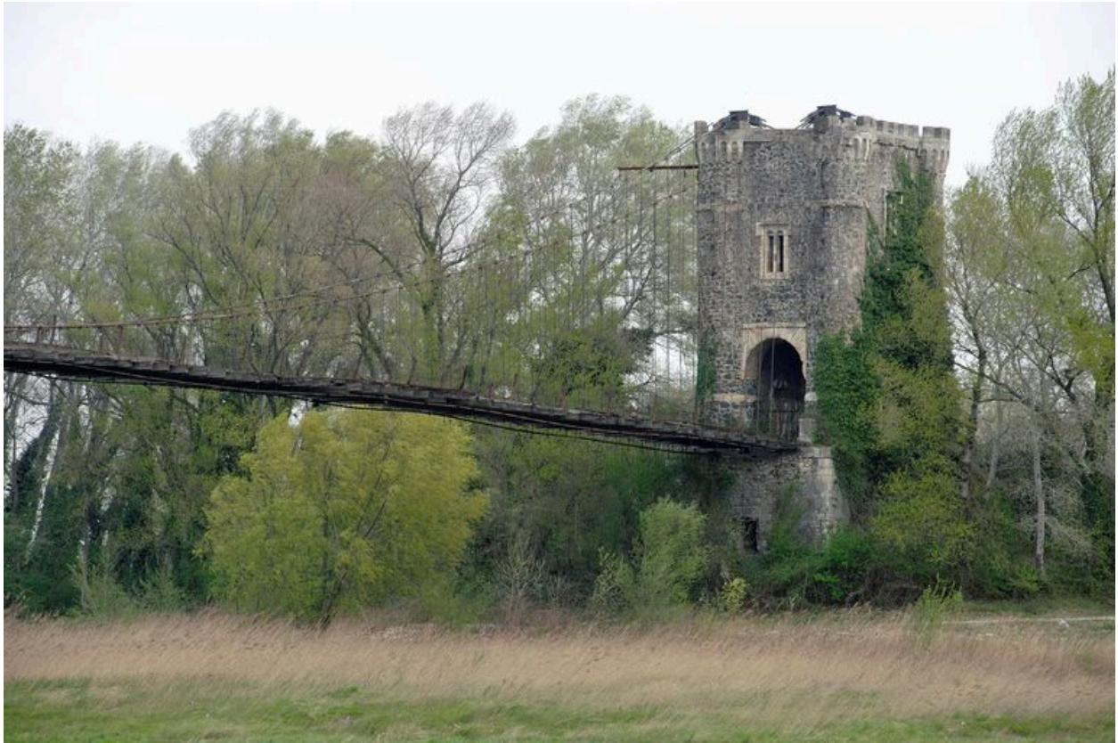
Tour formant tête de pont sur la rive gauche, vue générale (ouest)
