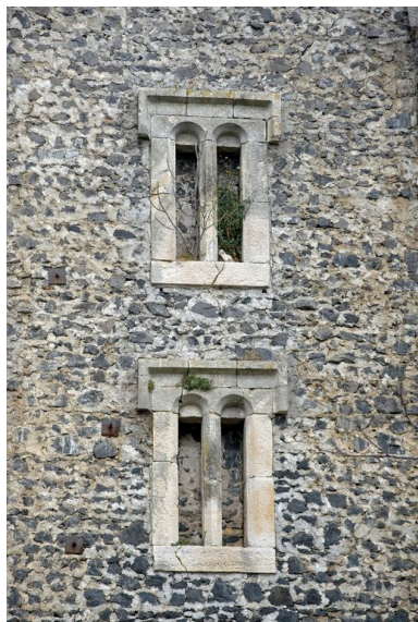
Tour formant tête de pont sur la rive droite : vue de deux ouvertures, face sud-ouest Phot. G. Gellert IVR82_20090700076NUCA
