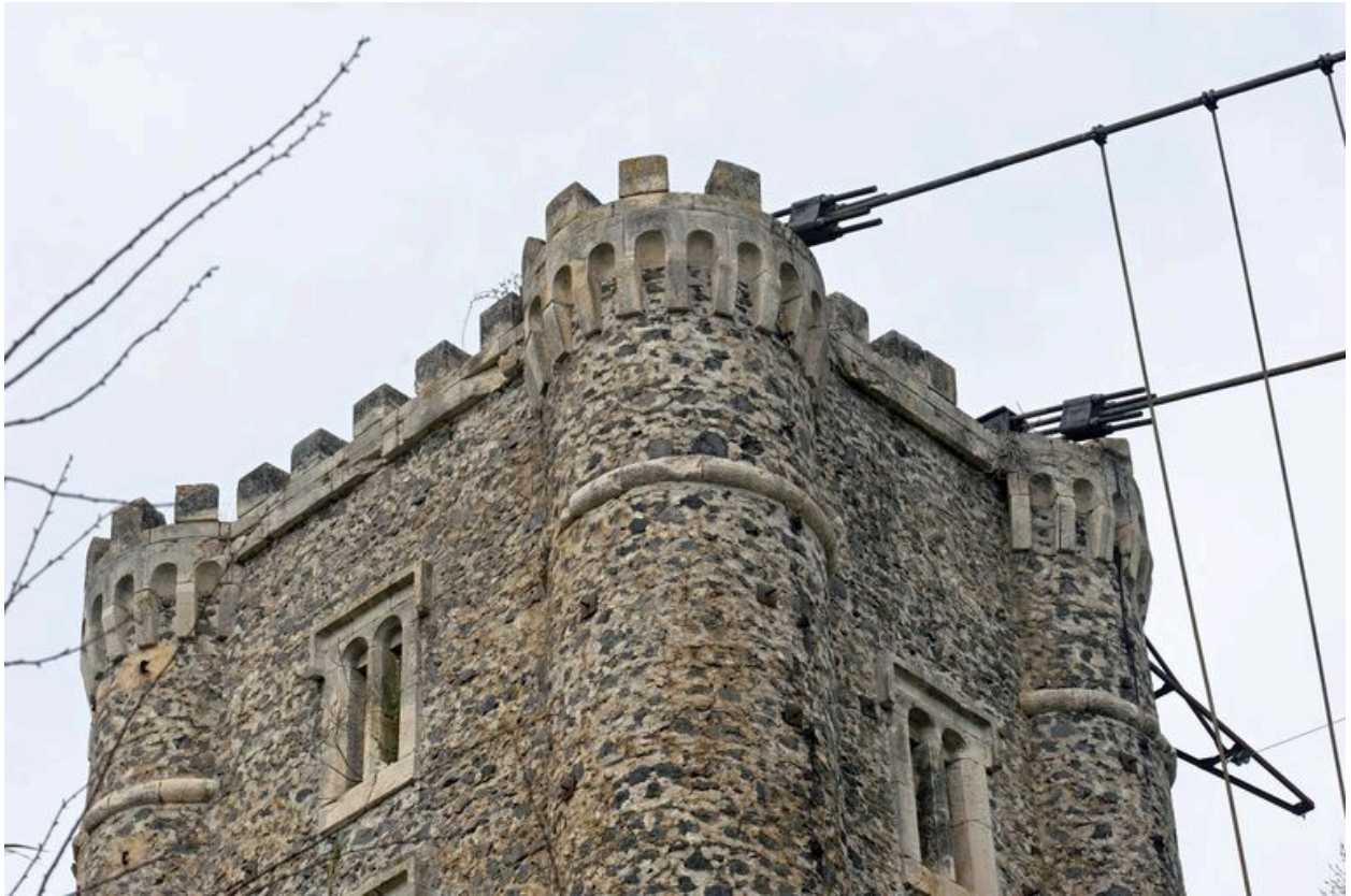
Tour formant tête de pont sur la rive droite : vue des parties hautes
