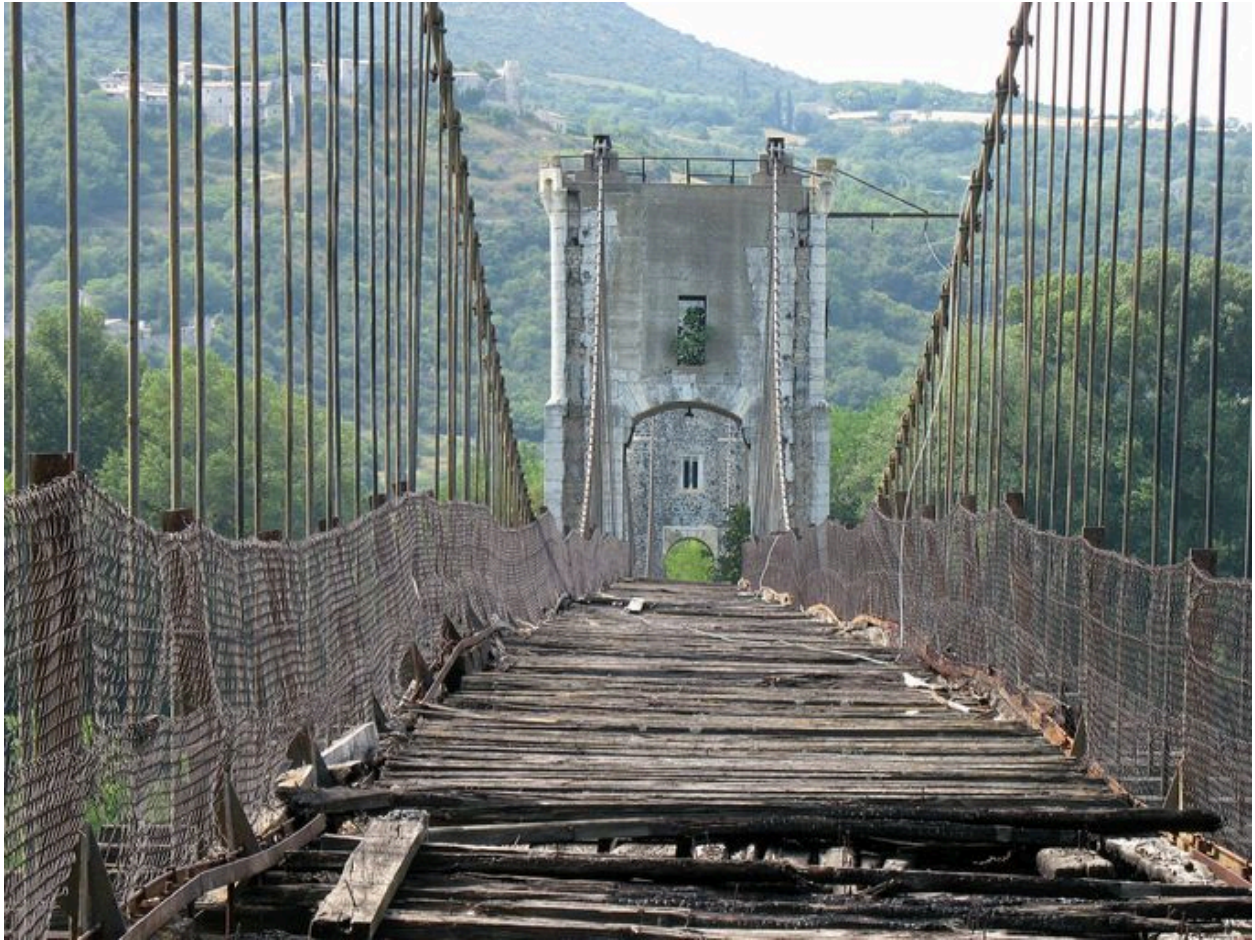
Vue de la chaussée (depuis la tour de la rive gauche) et pile centrale (face sud-est)
