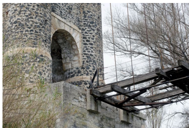
Tour formant tête de pont sur la rive droite : vue de l'accès au pont (face sud-est) et dessous du tablier, vue partielle Phot. G. Gellert IVR82_20090700077NUCA
