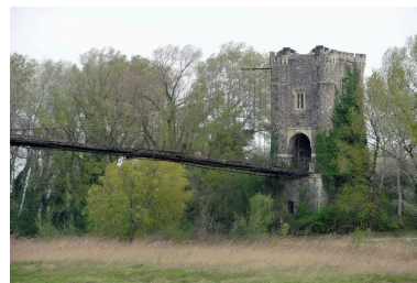
Tour formant tête de pont sur la rive gauche, vue générale (ouest) Phot. G. Gellert IVR82_20090700078NUCA
