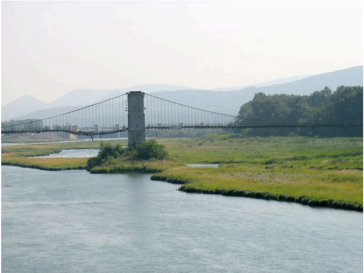
Vue partielle du pont dans le site, côté aval (depuis le pont moderne)
