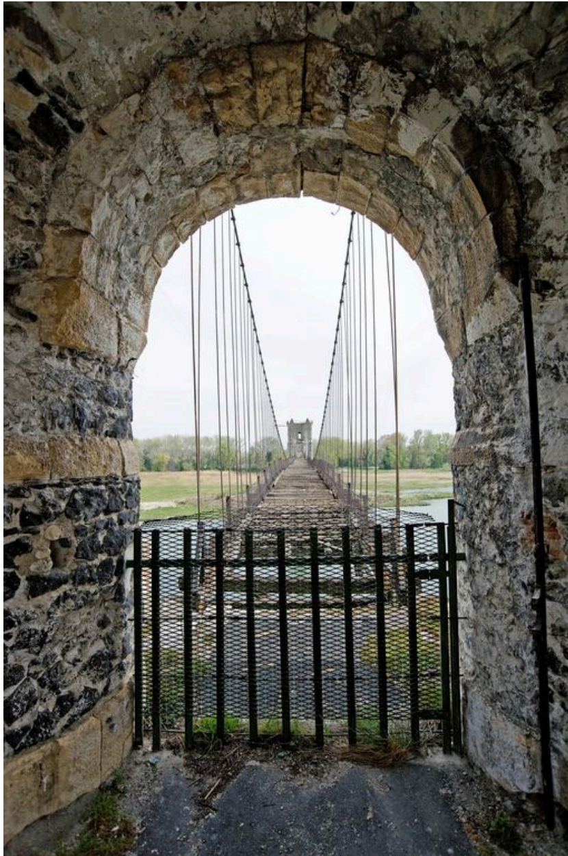
Vue de la chaussée, depuis la tour de la rive droite
