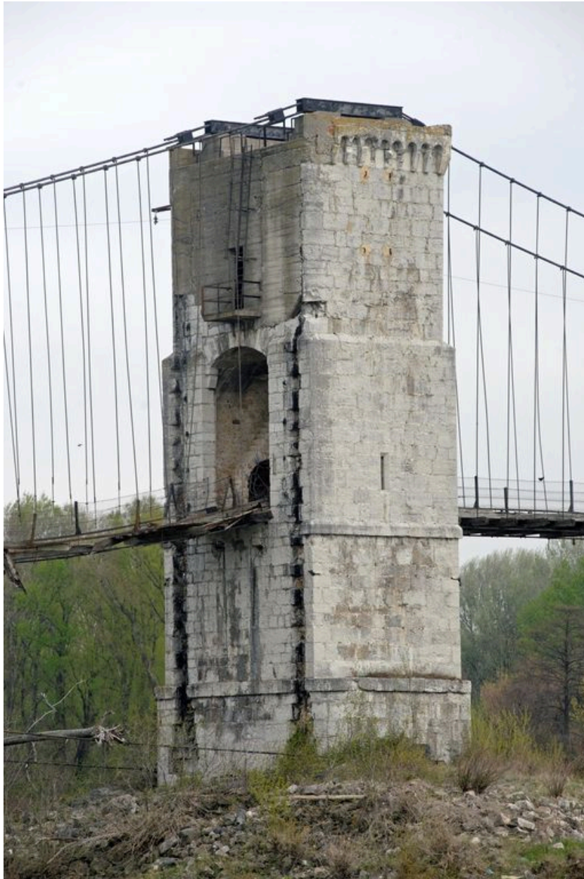
Vue de la pile centrale (de biais)
