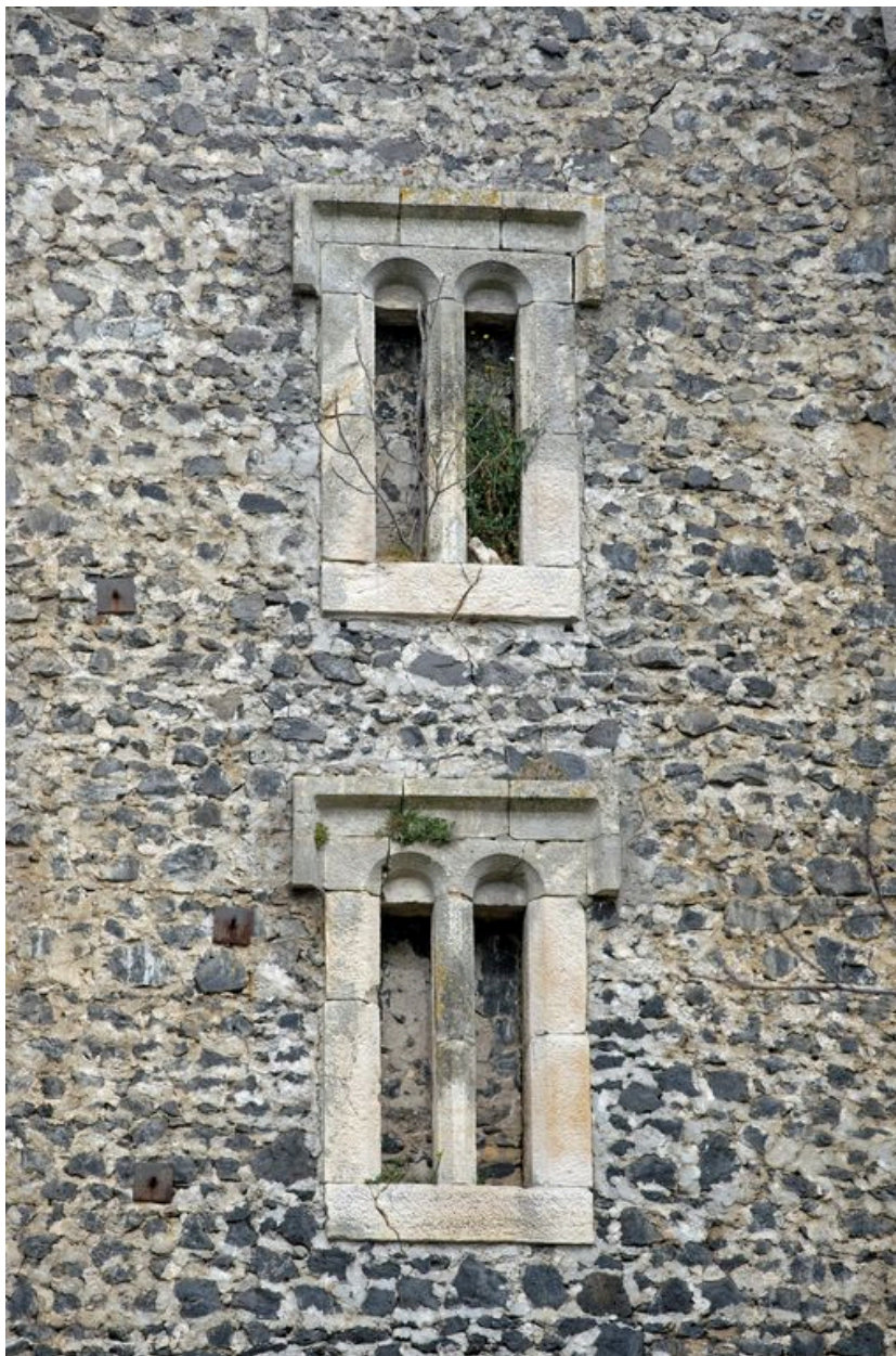
Tour formant tête de pont sur la rive droite : vue de deux ouvertures, face sud-ouest
