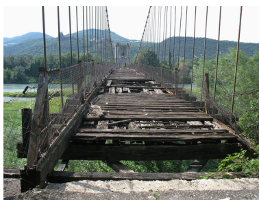
Vue de la chaussée, depuis la tour de la rive gauche Phot. I. Havard IVR82_20090700044NUCA
