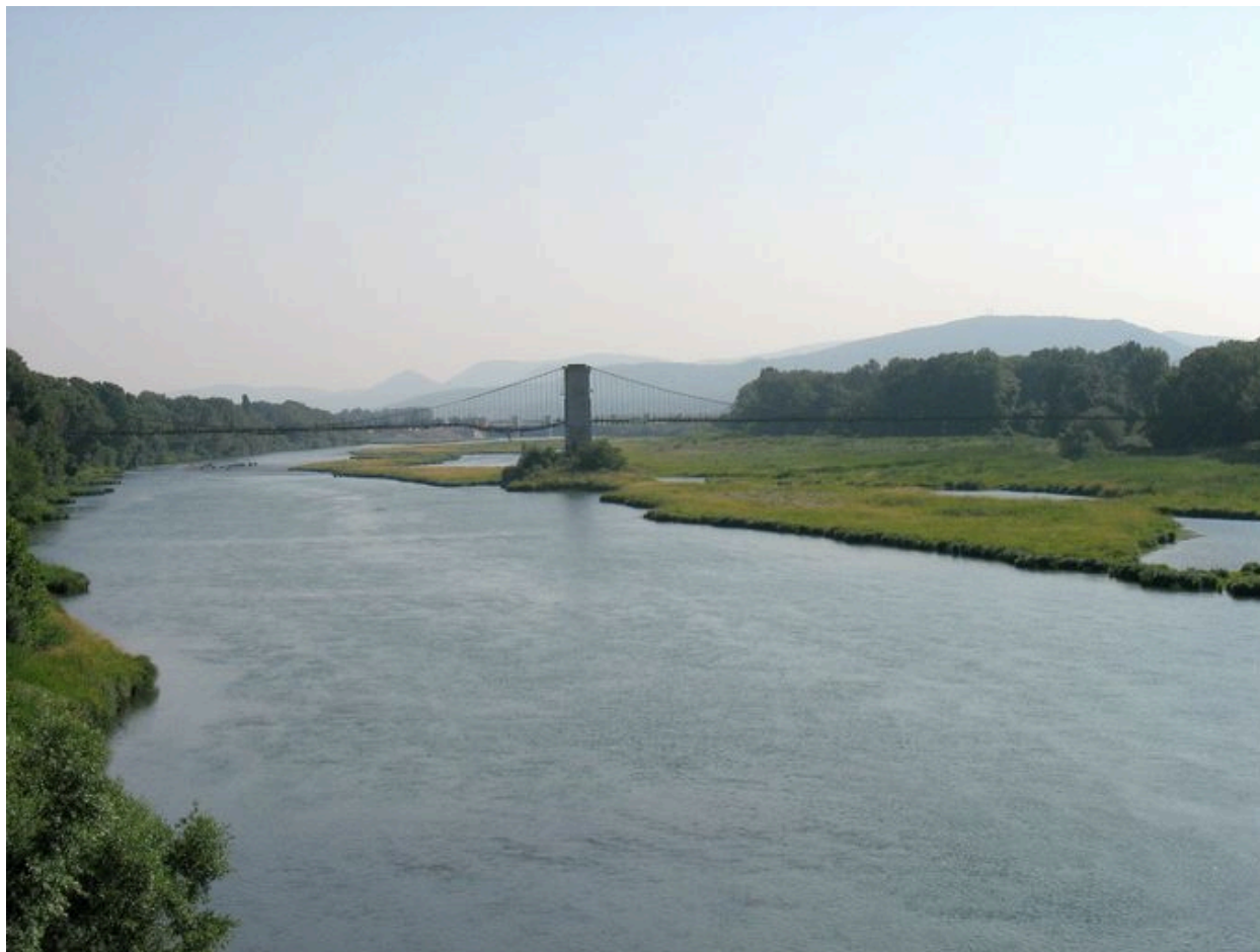
Vue du pont dans le site, côté aval (depuis le pont moderne)
