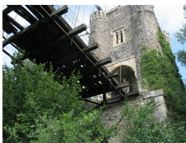
Tour formant tête de pont sur la rive gauche, vue en contreplongée (face nord-ouest) et dessous du tablier, vue partielle Phot. I. Havard IVR82_20090700047NUCA
