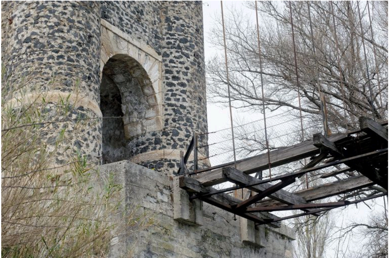
Tour formant tête de pont sur la rive droite : vue de l'accès au pont (face sud-est) et dessous du tablier, vue partielle
