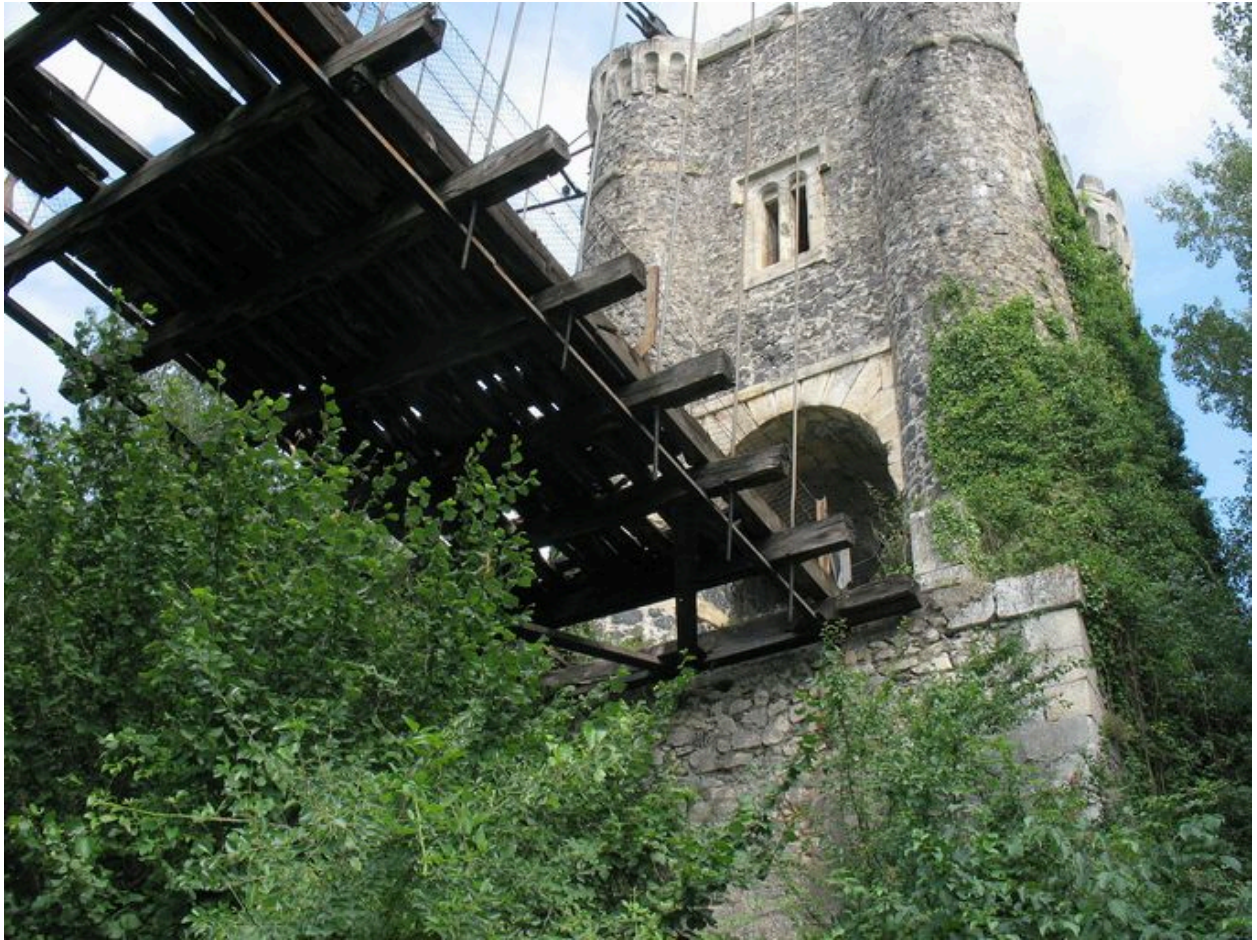
Tour formant tête de pont sur la rive gauche, vue en contreplongée (face nord-ouest) et dessous du tablier, vue partielle
