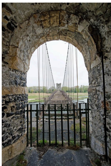
Vue de la chaussée, depuis la tour de la rive droite Phot. G. Gellert IVR82_20090700079NUCA
