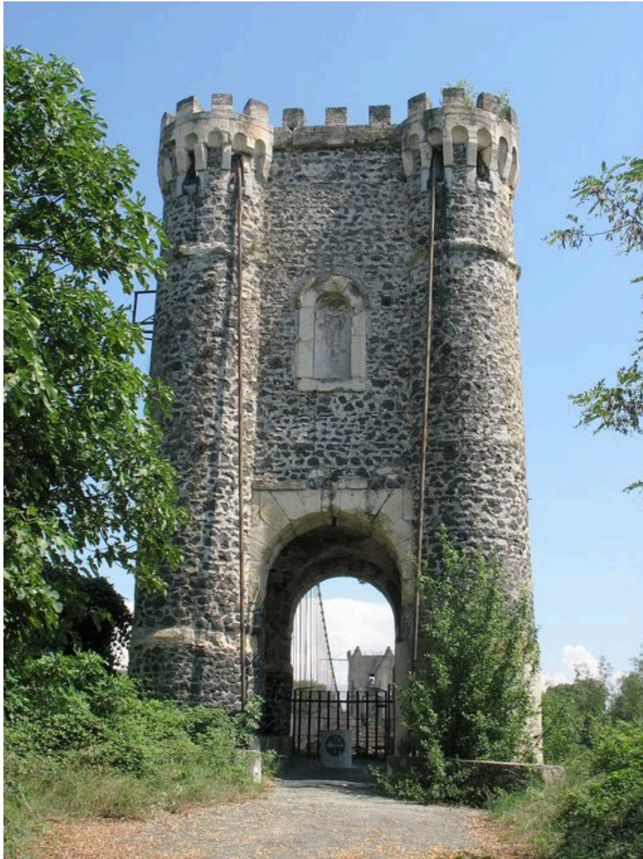
Tour formant tête de pont sur la rive droite, face nord-ouest : vue rapprochée
