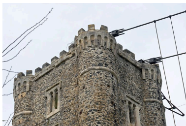
Tour formant tête de pont sur la rive droite : vue des parties hautes Phot. G. Gellert IVR82_20090700074NUCA
