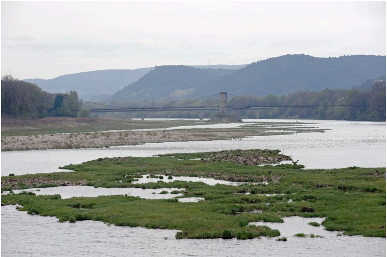
Vue du pont dans le site, côté amont
