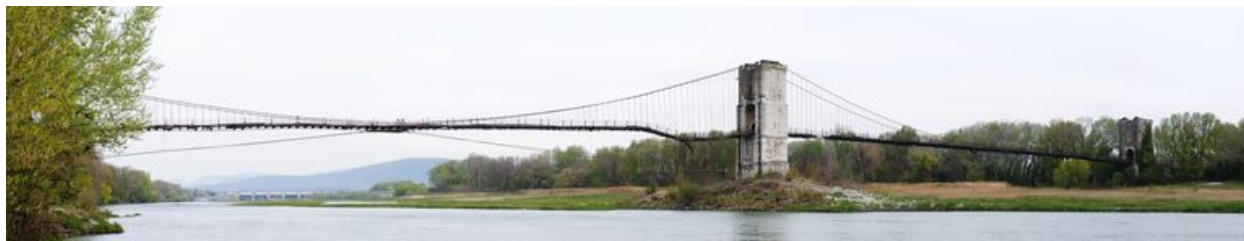
Vue panoramique, côté aval
