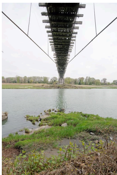
Vue du dessous du tablier (depuis la rive droite) Phot. G. Gellert IVR82_20090700080NUCA
