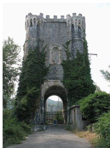
Tour formant tête de pont sur la rive gauche, face sud-est : vue rapprochée Phot. I. Havard IVR82_20090700043NUCA
