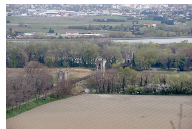
Vue du pont dans le site Phot. G. Gellert IVR82_20090700068NUCA
