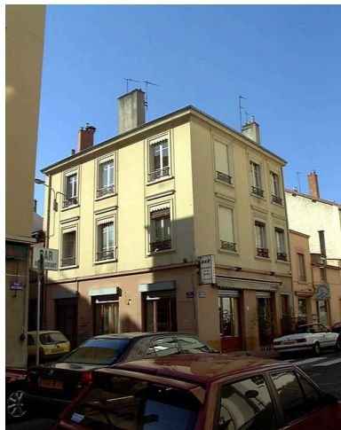
Vue générale des façades sur rue Phot. Bernard Ducouret IVR82_20016900850NUCA
