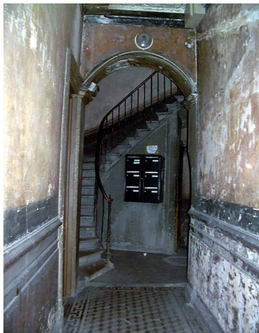
Allée et escalier Phot. Bernard Ducouret IVR82_20016900852NUCA
