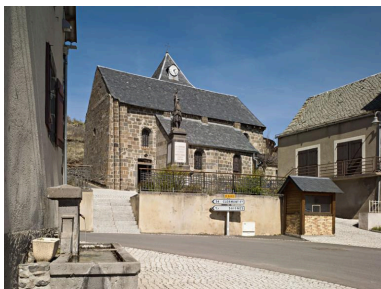
Vue générale Phot. Jean-Michel Périn IVR83_20146300306NUC4A
