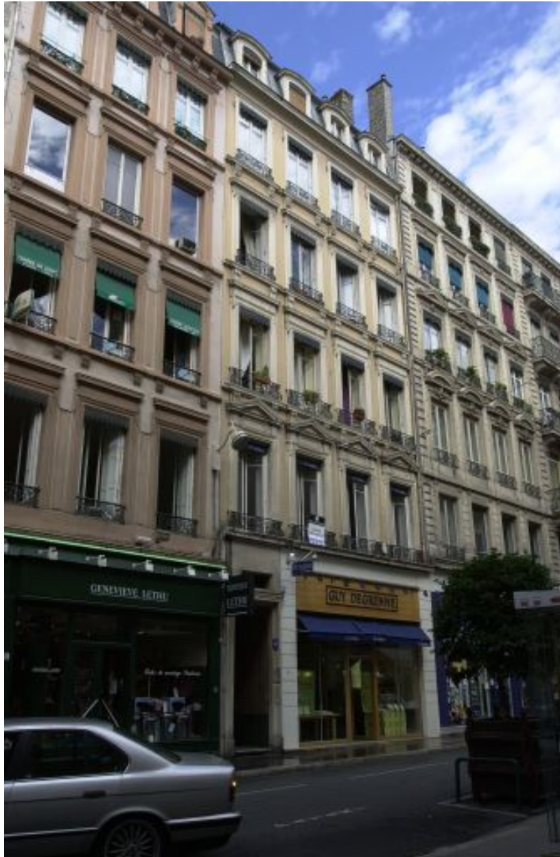
Façade, vue générale de trois quarts
