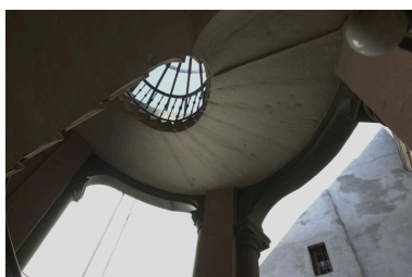
5e étage d'escalier, vue par-dessous Phot. Bernard Ducouret IVR82_20046905802NUCA
