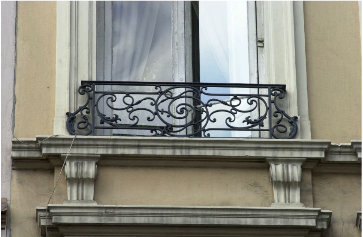
Façade, 4e niveau, détail de la 1ère fenêtre
