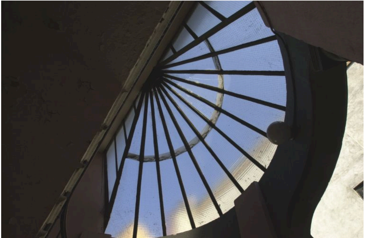
Cage d'escalier, verrière du toit
