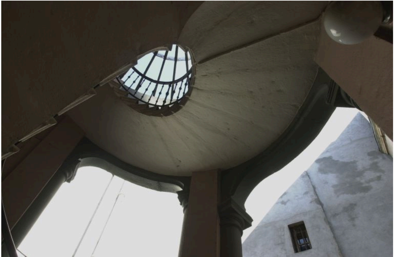
5e étage d'escalier, vue par-dessous
