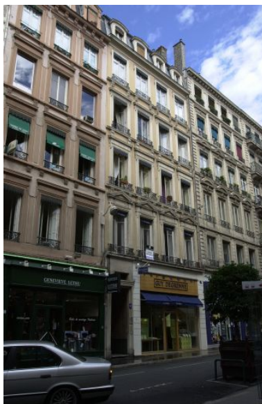
Façade, vue générale de trois quarts Phot. Bernard Ducouret IVR82_20046905796NUCA
