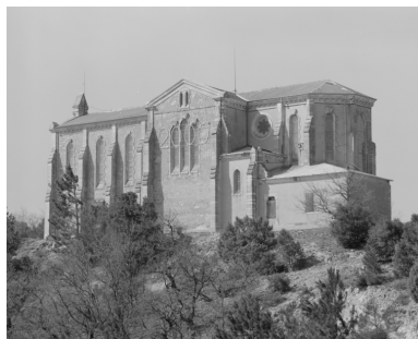
Vue d'ensemble, prise de l'est. Phot. Alain Franchella, Phot. Martial Couderette IVR82_20002600246X
