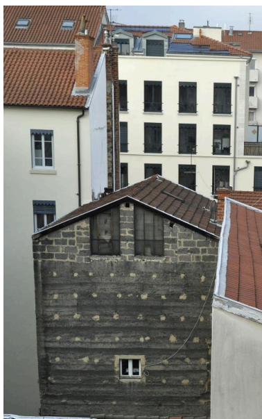
Vue postérieure de l'atelier Phot. Magali Delavenne IVR82_20156902582NUCA
