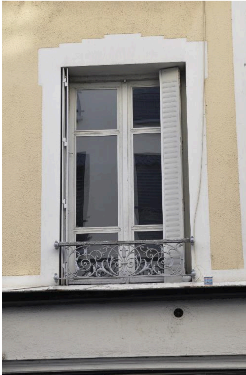
Bâtiment sur rue : détail d'une fenêtre
