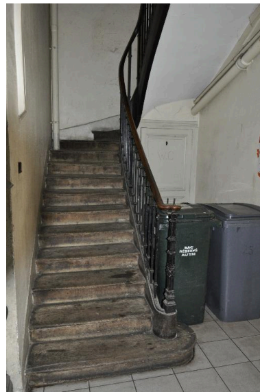
Bâtiment sur rue : escalier en charpente Phot. Magali Delavenne IVR82_20156902549NUCA
