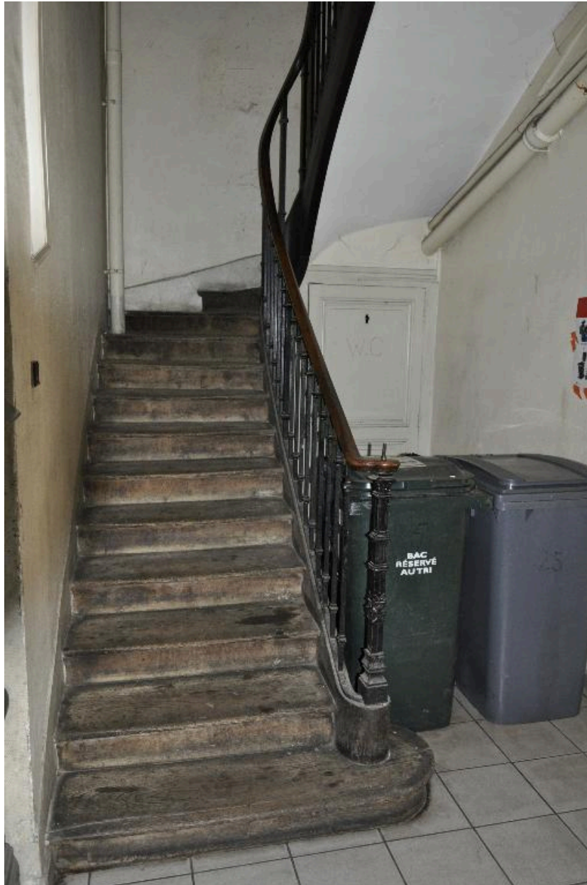
Bâtiment sur rue : escalier en charpente
