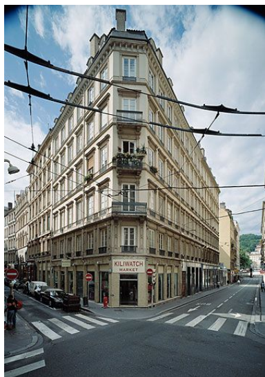
Vue générale Phot. Didier Gourbin IVR82_20046900839PA
