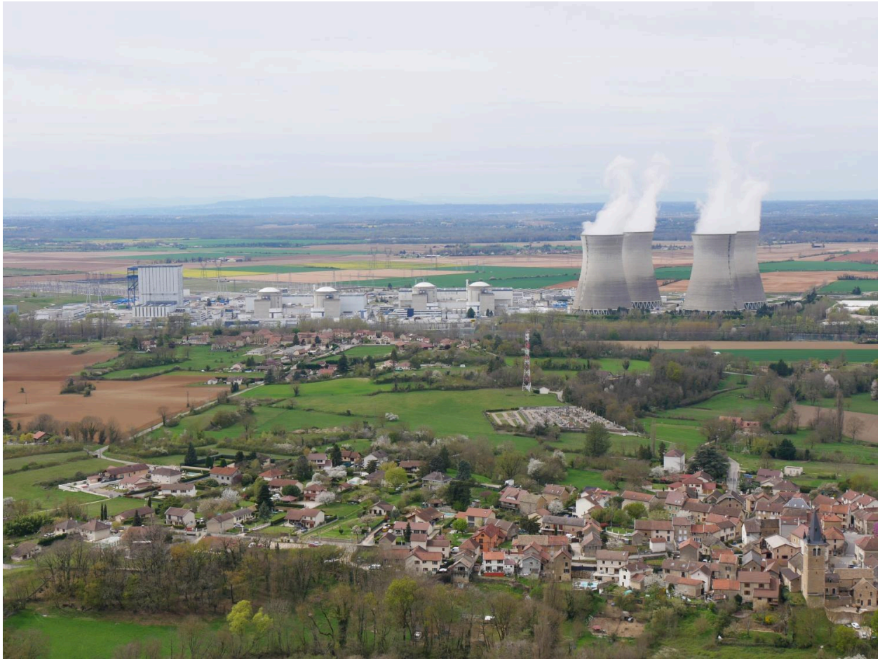
Vue d'ensemble est de la centrale du Bugey (du site archéologique de Larina).
