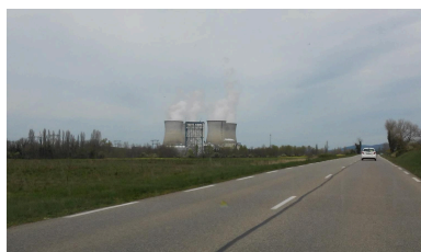
Vue nord du site Phot. Nadine Halitim-Dubois IVR84_20230100114NUCA
