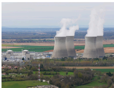
tours aéroréfrigérantes de 128 mètres de hauteur Phot. Nadine Halitim-Dubois IVR84_20230100112NUCA
