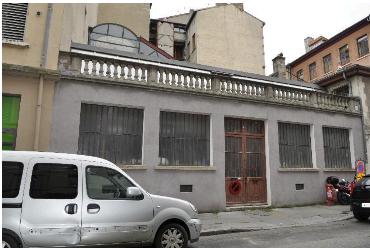
Vue d'ensemble de l'atelier au n°8 rue Dumenge
