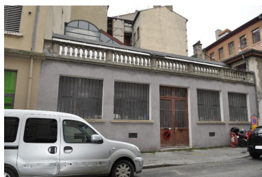
Vue d'ensemble de l'atelier au n°8 rue Dumenge Phot. Nadine Halitim-Dubois IVR82_20136900436NUCA
