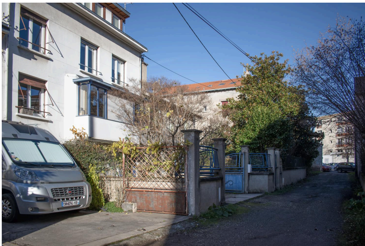
Façade sur la voie de desserte
