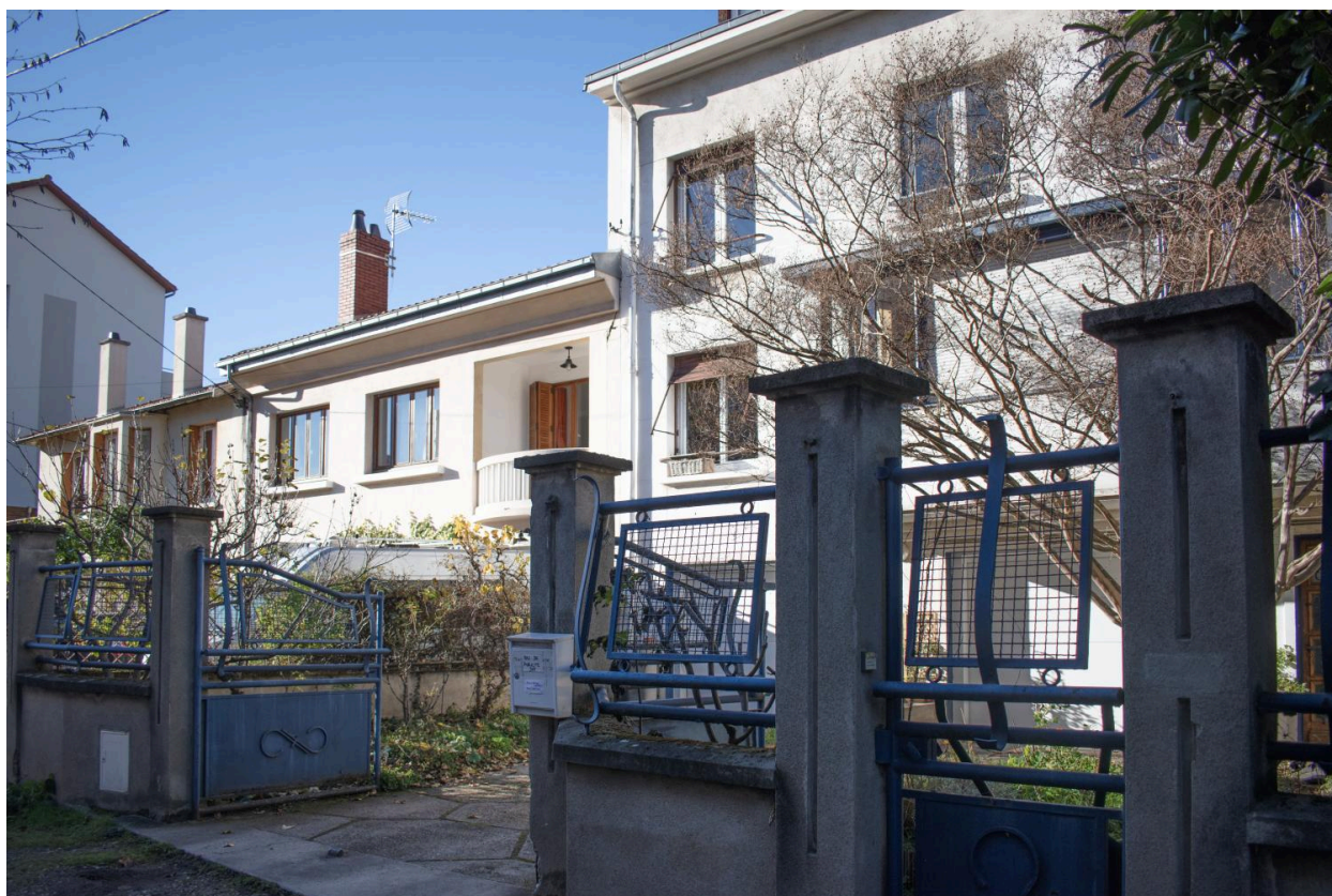
Façades sur la voie de desserte
