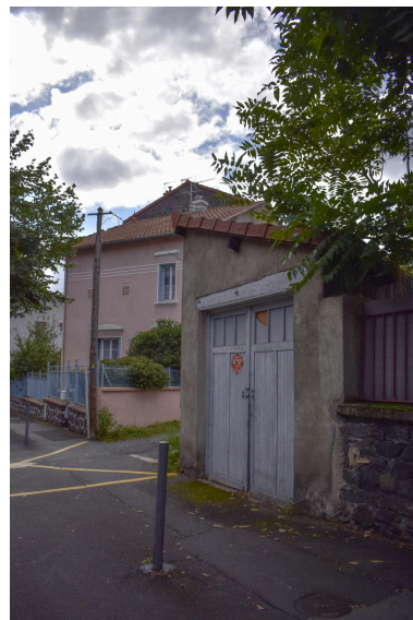
Maison et garage automobile de part et d'autre de l'impasse desservant le lotissement Loradoux Phot. Félicie Fougère IVR84_20256302188NUCA
