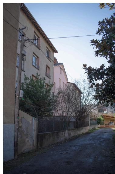
Côté oriental de la voie de desserte Phot. Félicie Fougère IVR84_20256302495NUCA
