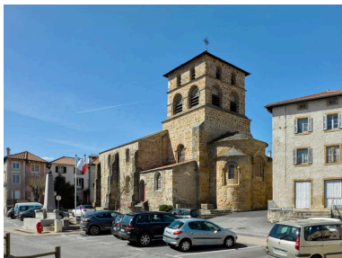
vue du sud - est Phot. Christian Parisey IVR84_20174300087NUC4A
