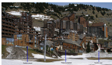
Vue depuis l'ouest Phot. Jean-François Lyon-Caen, Phot. C. Salomon-Pelen IVR82_20087400430NUCA
