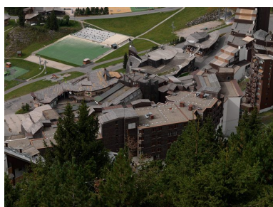
Vue d'ensemble des toitures depuis le nord-est Phot. Eric Dessert IVR82_20097400628NUCA
