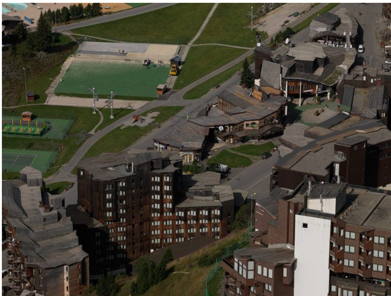
Vue d'ensemble des toitures depuis le sud-est
