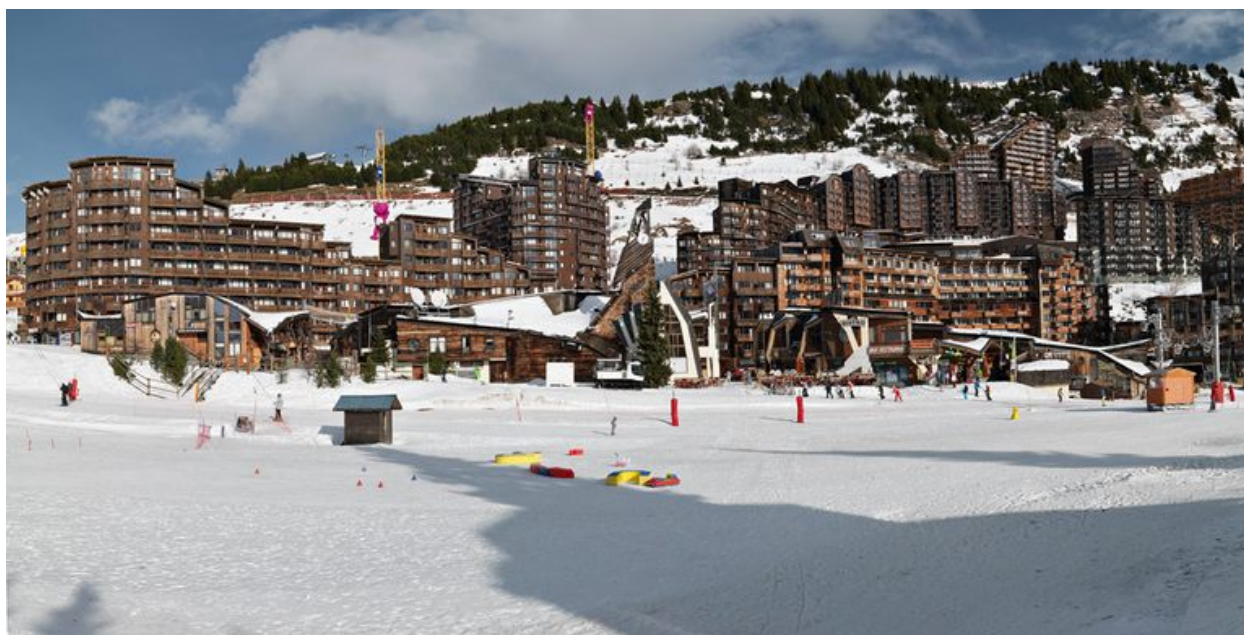
Vue depuis le sud-ouest
