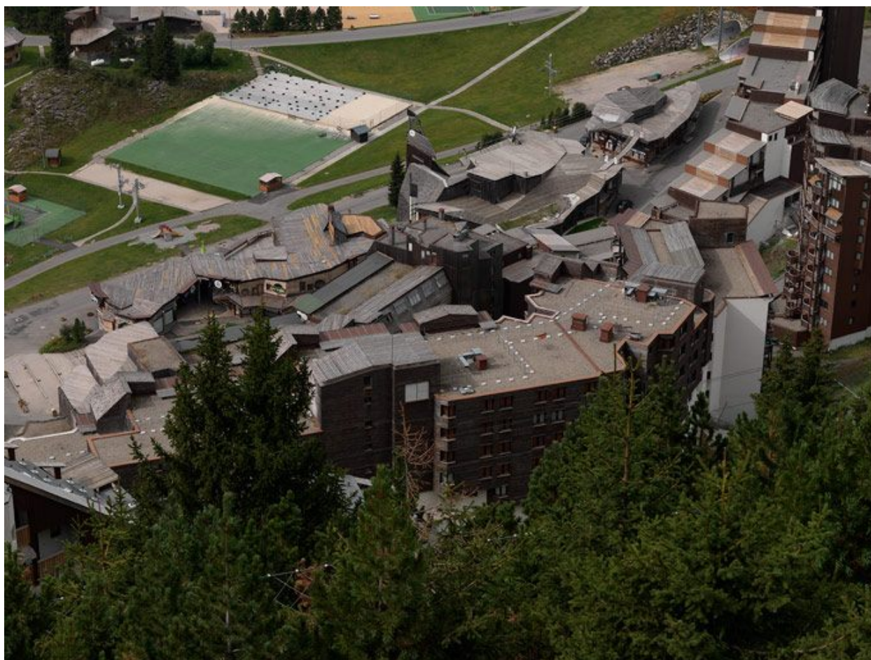
Vue d'ensemble des toitures depuis le nord-est
