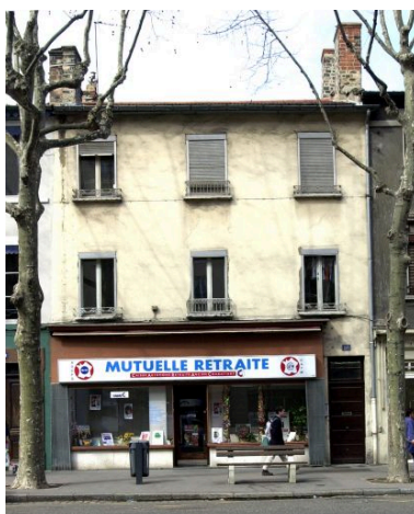
Élévation cours Charlemagne Phot. Maryannick Chalabi IVR82_20016901798NUCA
