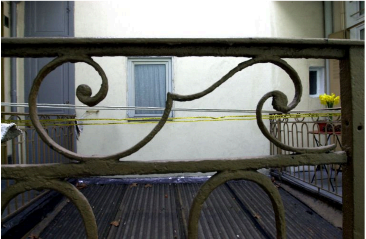
Détail de ferronnerie du garde-corps des coursières
