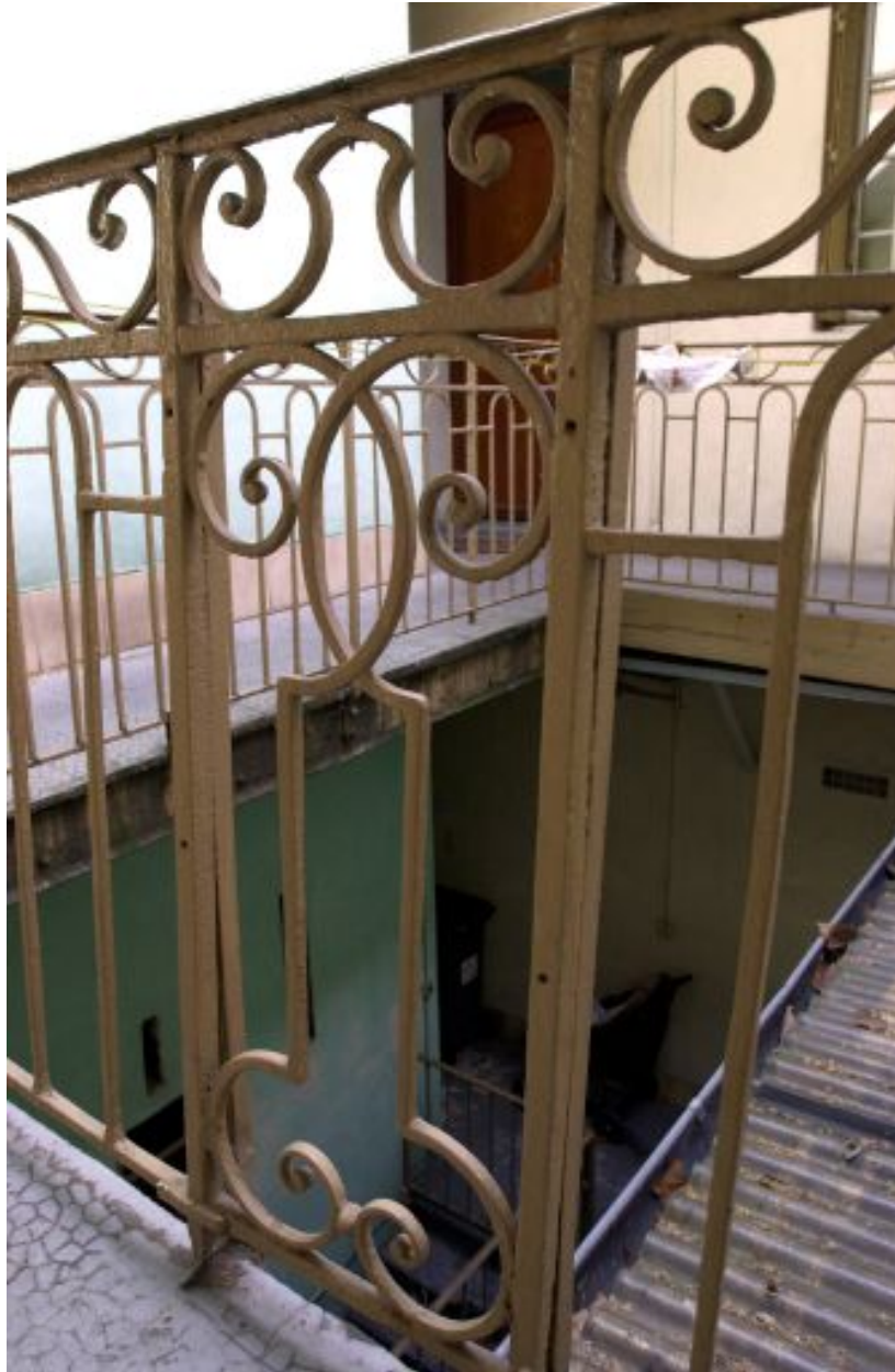
Détail de ferronnerie du garde-corps des coursières
