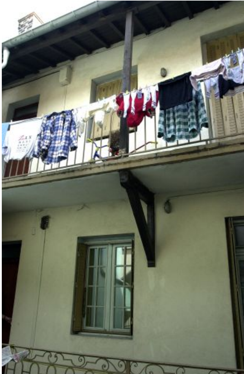
Détail des coursières : garde-corps et support
