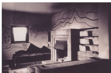
Le living-room et le coin feu Phot. F. Véry IVR82_20127402104NUCAB
