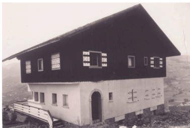
Vue générale Phot. F. Véry IVR82_20127402103NUCAB
