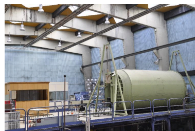
Détail de la mezzanine de la halle Phot. Nadine Halitim-Dubois IVR82_20126900048NUCA
