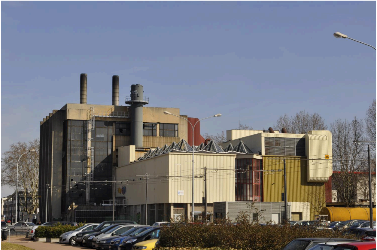
Vue de la chaufferie
