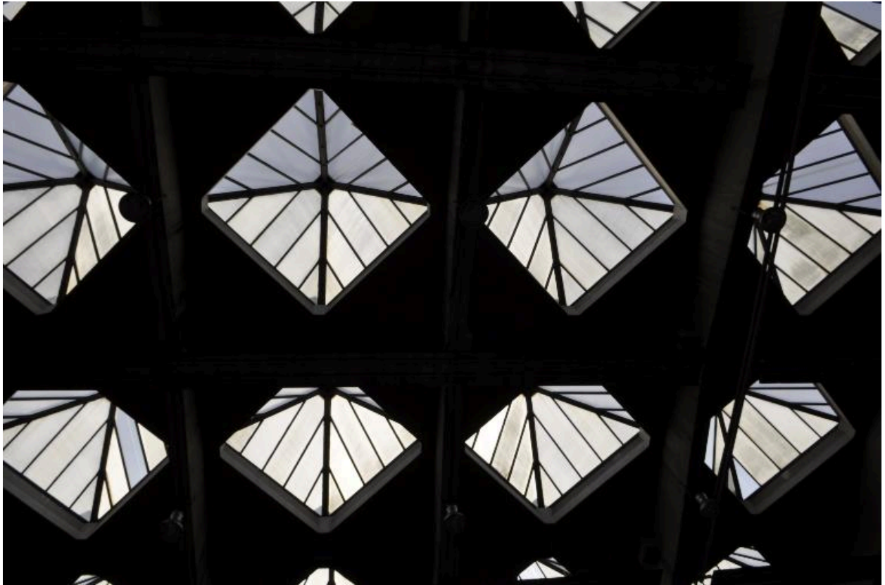
Vue des ouvertures zénithales
