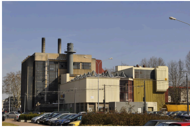
Vue de la chaufferie Phot. Nadine Halitim-Dubois IVR82_20126900110NUCA
