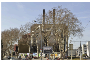
Vue d'ensemble de la chaufferie : centrale thermique à charbon. Phot. Nadine Halitim-Dubois IVR82_20126900041NUCA
