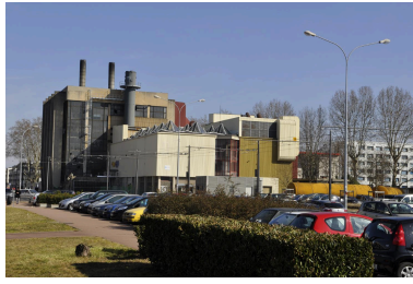
Chaufferie vue nord-est Phot. Nadine Halitim-Dubois IVR82_20126900111NUCA
