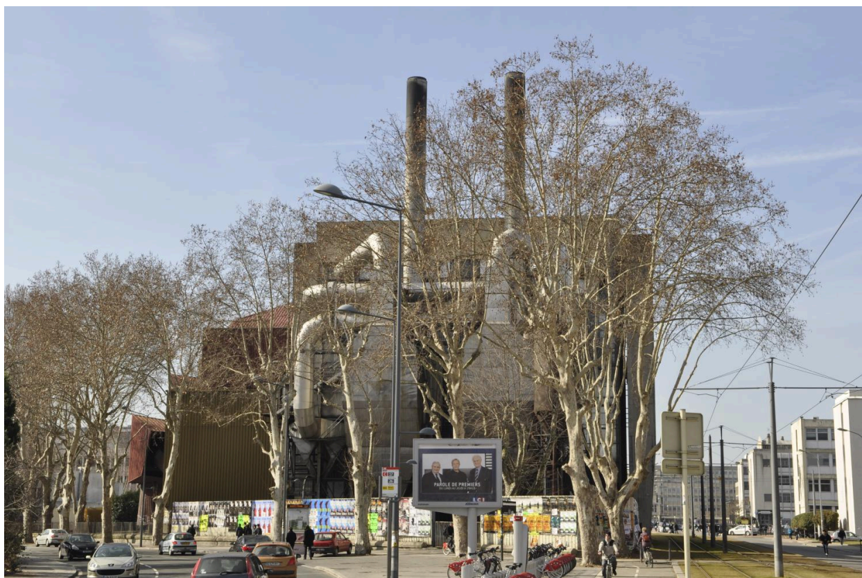
Vue d'ensemble de la chaufferie : centrale thermique à charbon.
