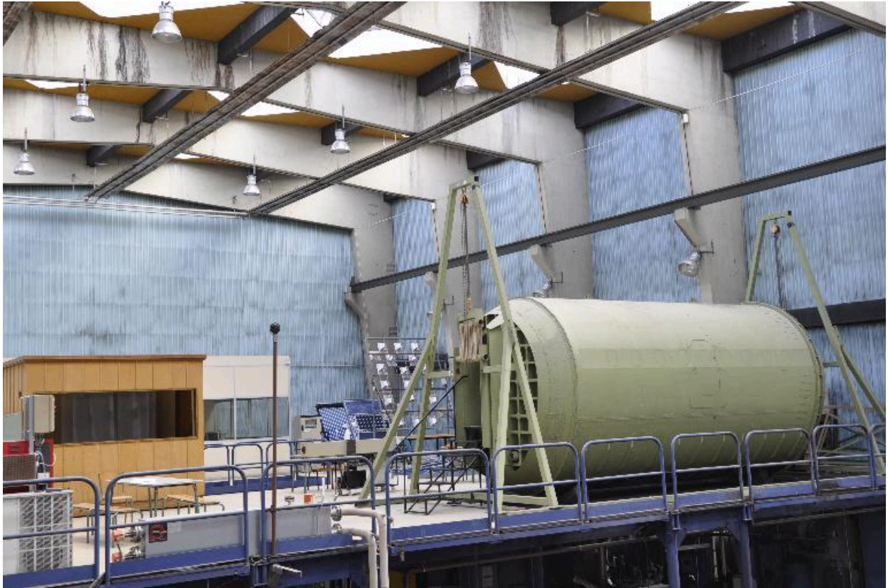
Détail de la mezzanine de la halle
