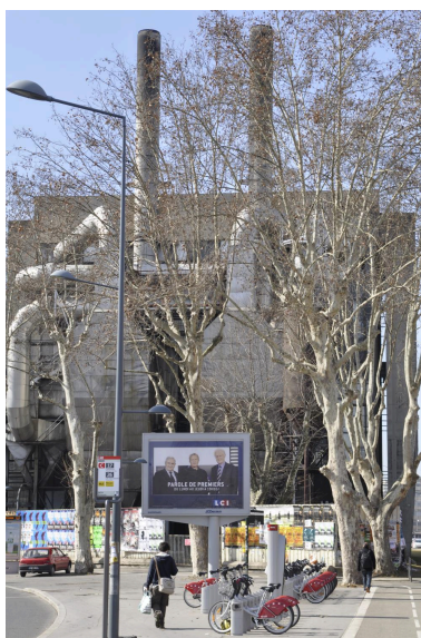
Détail chaufferie INSA Phot. Nadine Halitim-Dubois IVR82_20126900042NUCA
