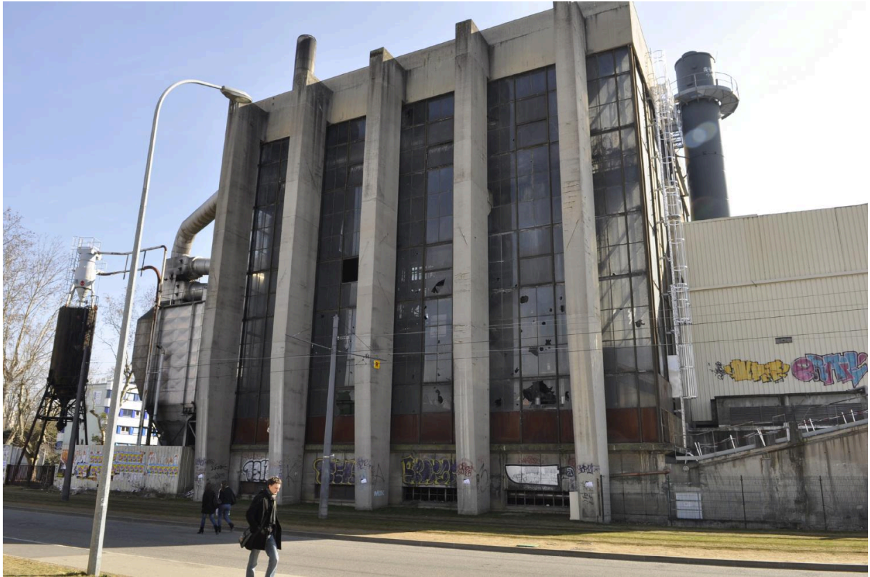
Vue latérale de la chaufferie
