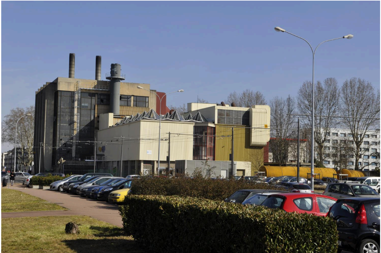
Chaufferie vue nord-est
