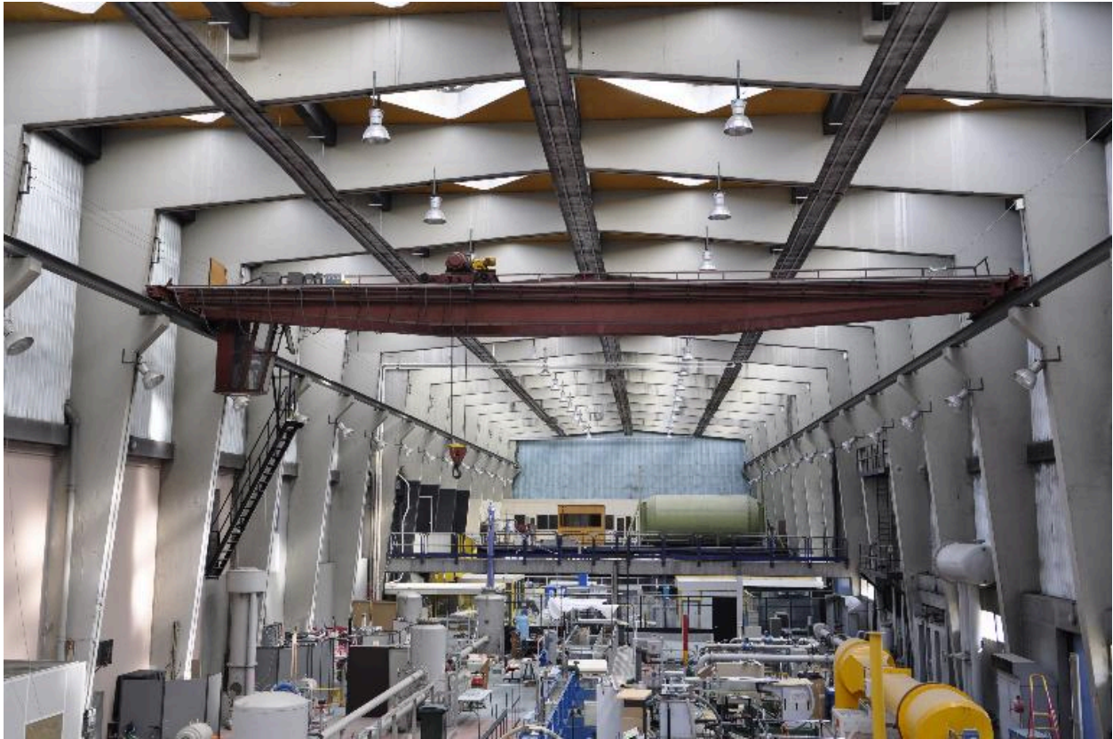
Vue de la structure et de la charpente en béton
