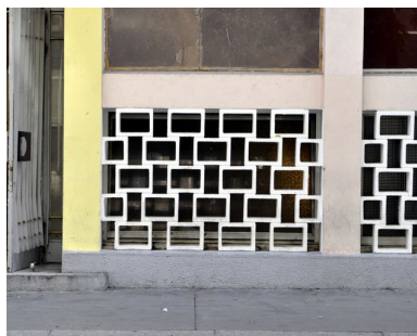
Détail de la claustra du rez-de-chaussée Phot. Catherine Guégan IVR82_20096903500NUCA
