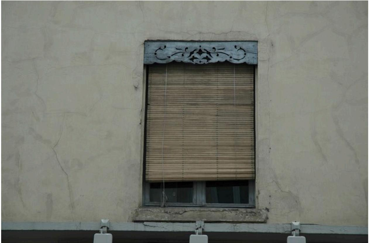
Détail d'une fenêtre et de son lambrequin, élévation latérale
