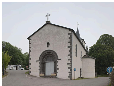
Vue générale sud-ouest Phot. Jean-Michel Périn IVR83_20146300416NUC4A
