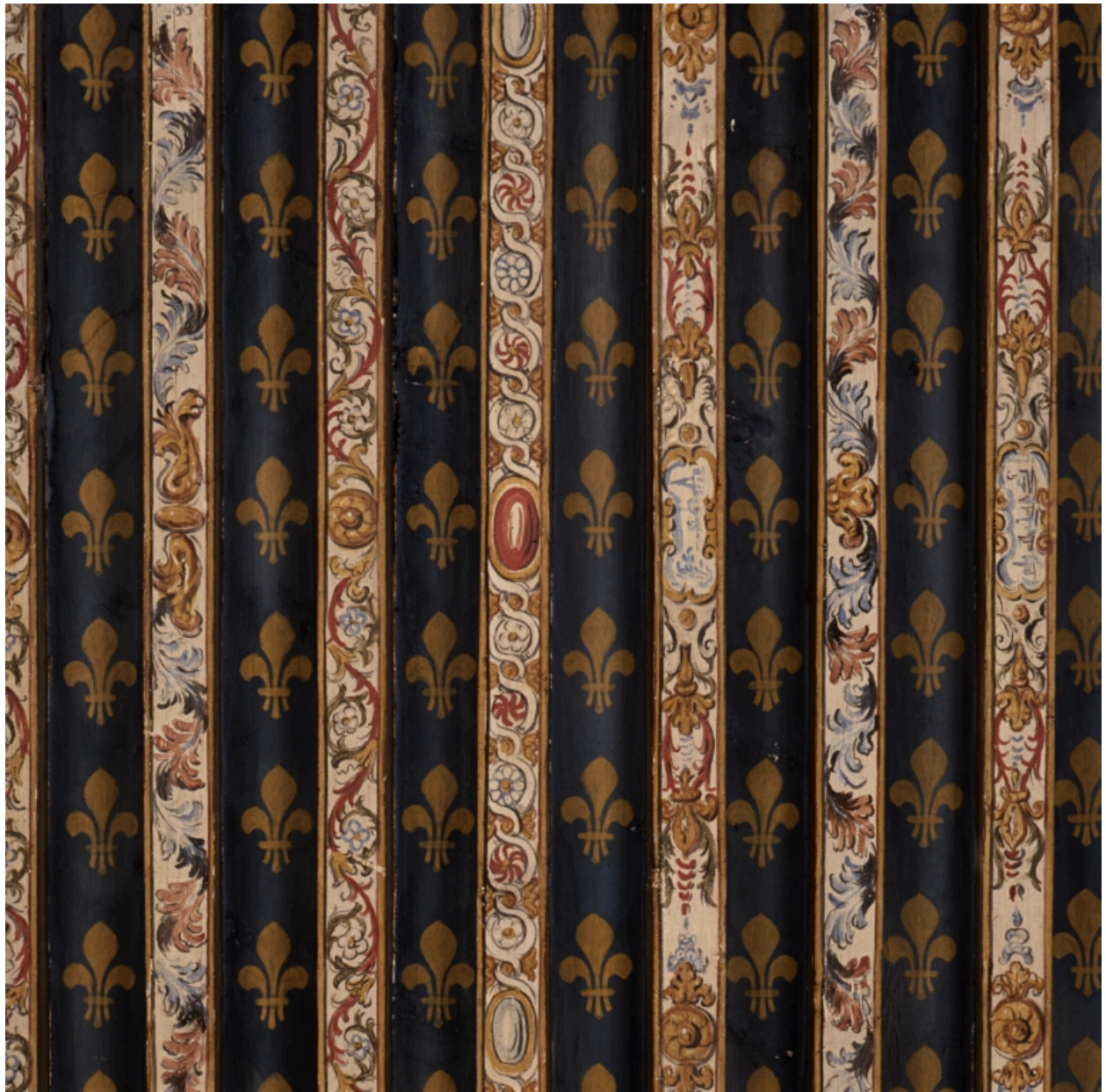
Solives, 2e travée, centre, détail.
