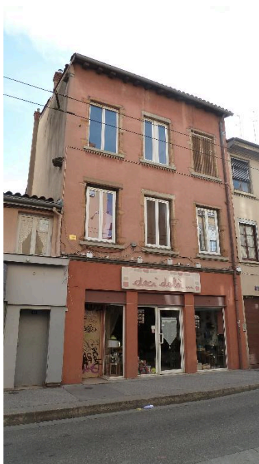
Vue d'ensemble nord ouest Phot. Nadine Halitim-Dubois IVR82_20146900305NUCA
