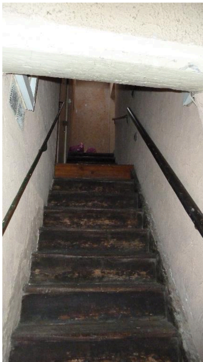
vue du second escalier de l'immeuble depuis le premier étage
