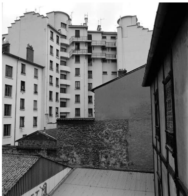
Elévations postérieures depuis le 153 rue Baraban Phot. Didier Gourbin IVR82_20036903258X
