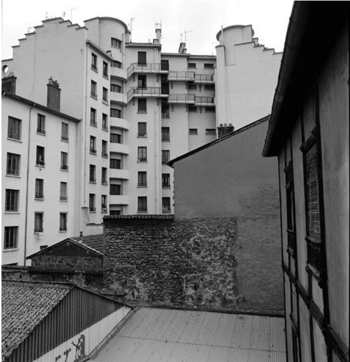
Elévations postérieures depuis le 153 rue Baraban
