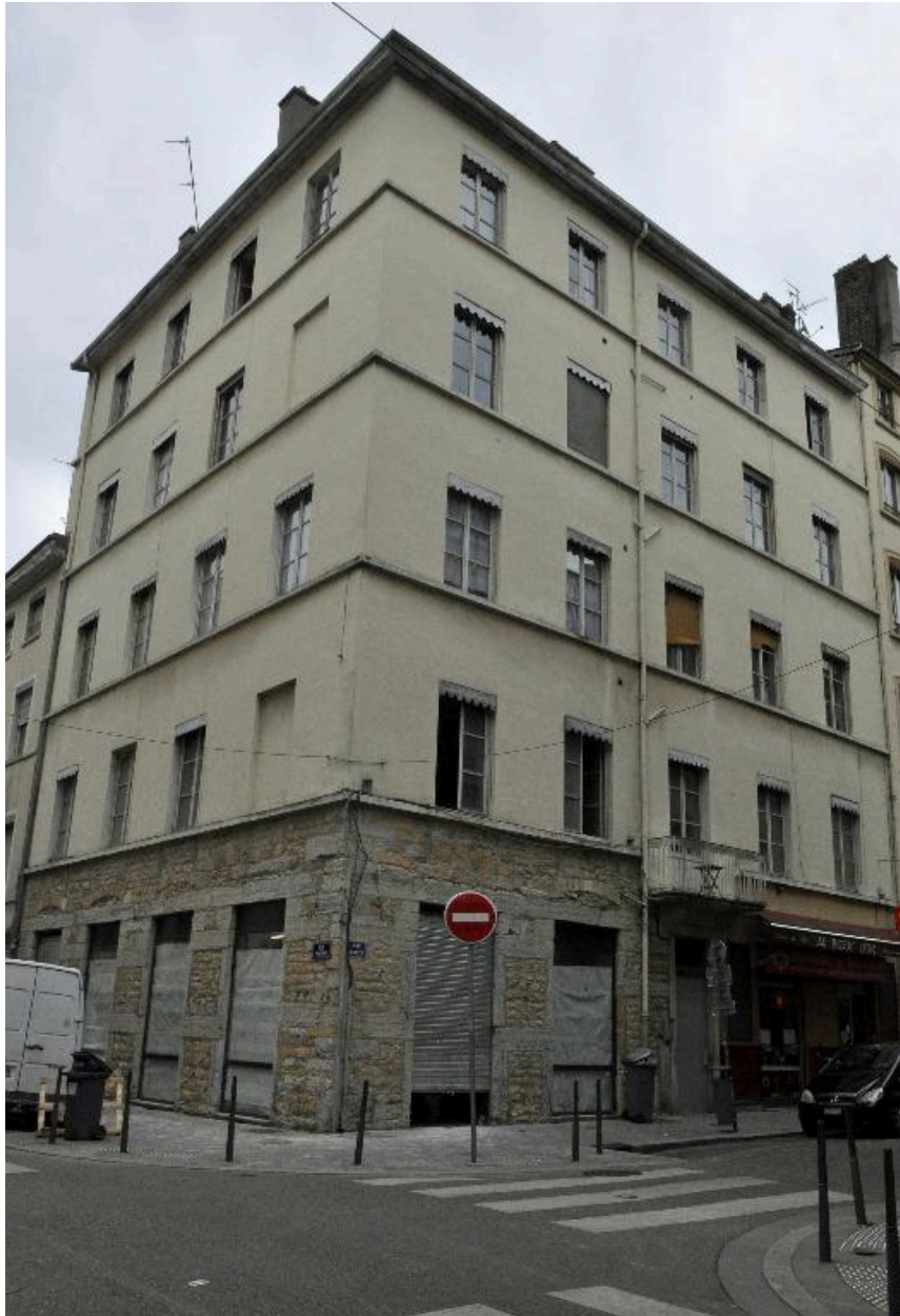
Vue d'ensemble de l'immeuble, depuis la rue Pasteur
