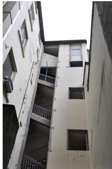
Vue partielle de l'élévation sur cour, escalier à cage ouverte Phot. Catherine Guégan IVR82_20156901013NUCA
