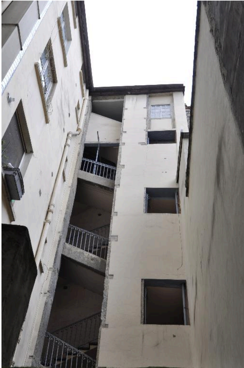
Vue partielle de l'élévation sur cour, escalier à cage ouverte
