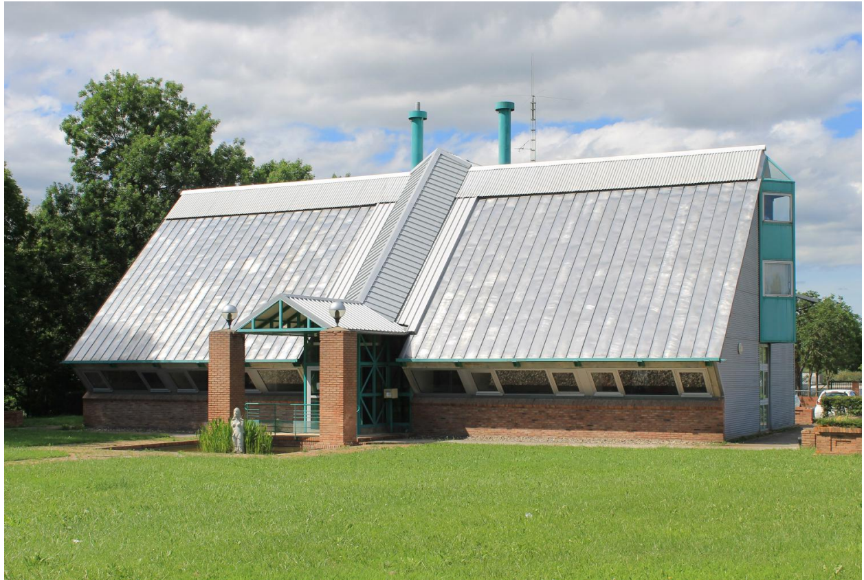
Billom, subdivision de la DDE, le corps de bâtiment méridional vu du sud, état de 2021. Des bacs métalliques ont totalement occulté la verrière et les renforcements.
