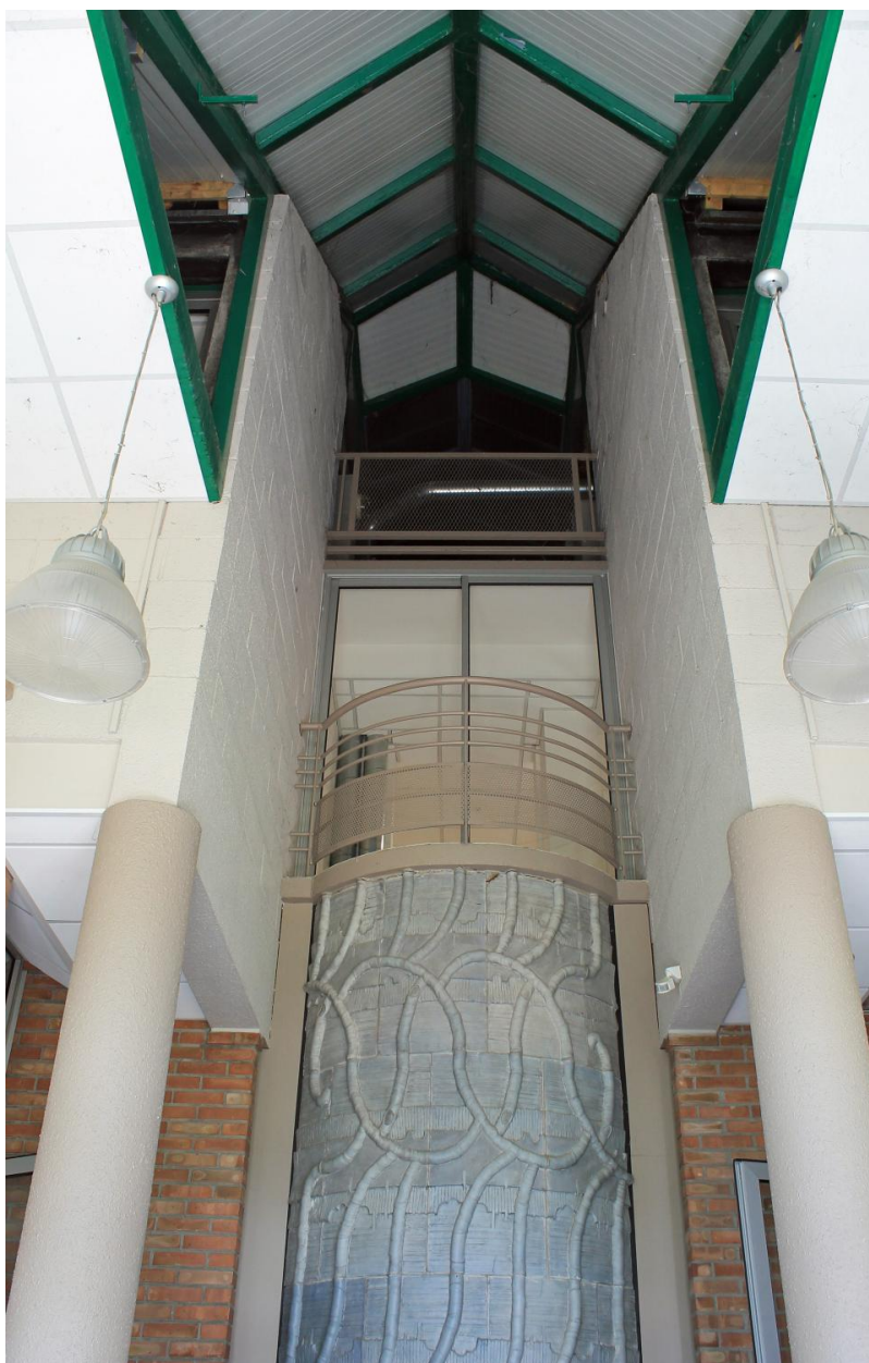
Billom, subdivision de la DDE, la partie supérieure de la cuve de stockage et, sous la verrière, l'espace ouvert entre le vestibule et les deux étages.
