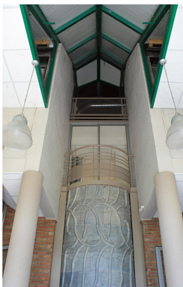
Billom, subdivision de la DDE, la partie supérieure de la cuve de stockage et, sous la verrière, l'espace ouvert entre le vestibule et les deux étages. Phot. Christophe Laurent IVR84_20216302774NUCA
