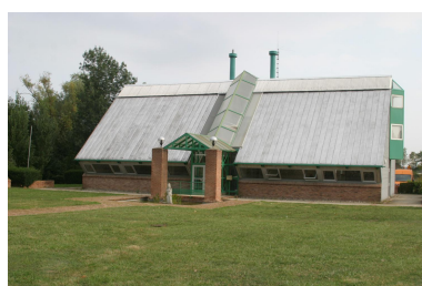
Billom, subdivision de la DDE, le corps de bâtiment méridional vu du sud, état de 2012. Les capteurs solaires ont semble-t-il été démontés en 1995. Un bardage en zinc a été posé à leur place. Des panneaux translucides ont fermé les renforcements de part et d'autre de la verrière. Phot. Christophe Laurent IVR84_20216302771NUCA
