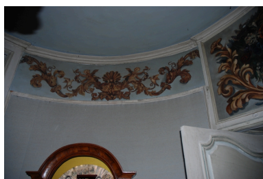
Tour d'angle sud-ouest, 1er étage : frise peinte sur toile marouflée. Phot. Thierry Monnet IVR82_20134204431NUCA
