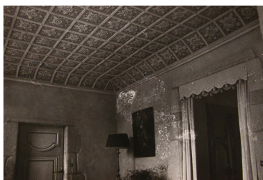
[Vestibule du château] Dossier de recensement MH établi en 1973. Photographie argentique en noir et blanc. AD Loire. 1111 VT 269 Repro. Thierry Monnet, Autr. Louis Bernard IVR82_20134204735NUCAB
