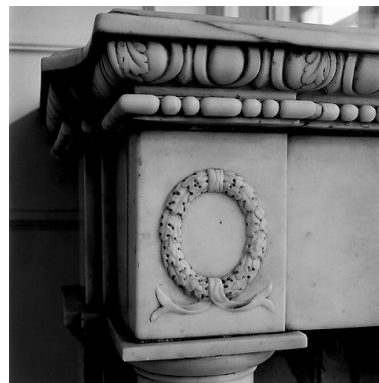
Détail de l'entablement au-dessus des colonnes Phot. Didier Gourbin IVR82_20036902080X
