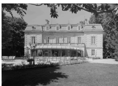
Façade principale donnant sur le parc.
