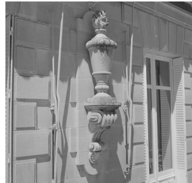
Décor de façade : pot à feu sur console. Phot. Eric Dessert IVR82_20002600673X
