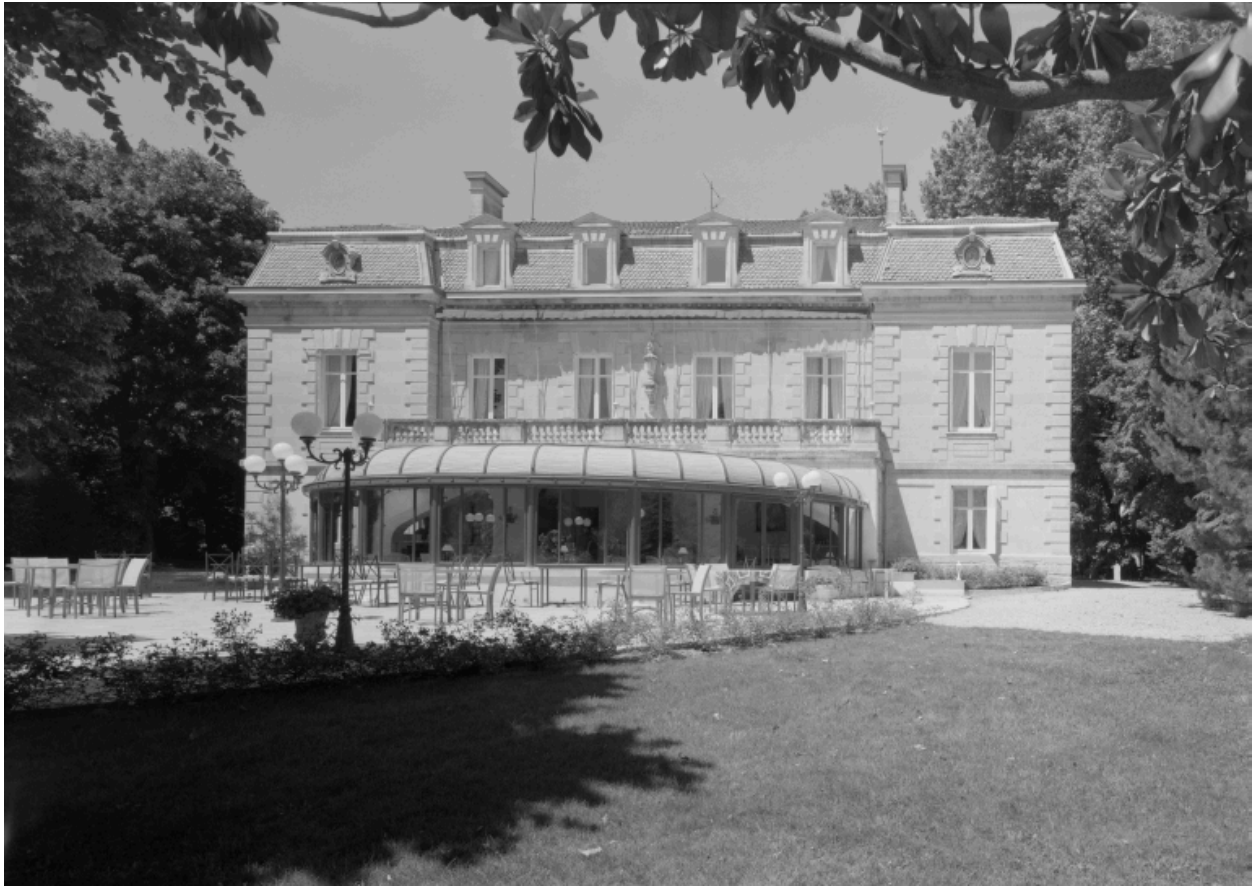
Façade principale donnant sur le parc.
