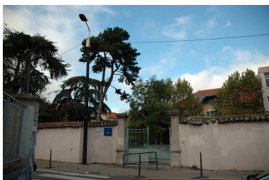
Vue du portail 23 rue des Alouettes Phot. Véronique Belle IVR82_20086901702NUCA
