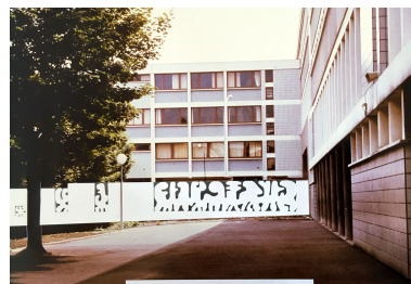
1er projet, 1979 : vue rapprochée du mur côté cour (AN, 19910237/14) Repro. Catherine Guégan, Autr. Erwin Neuhaus IVR84_20246300279NUCA
