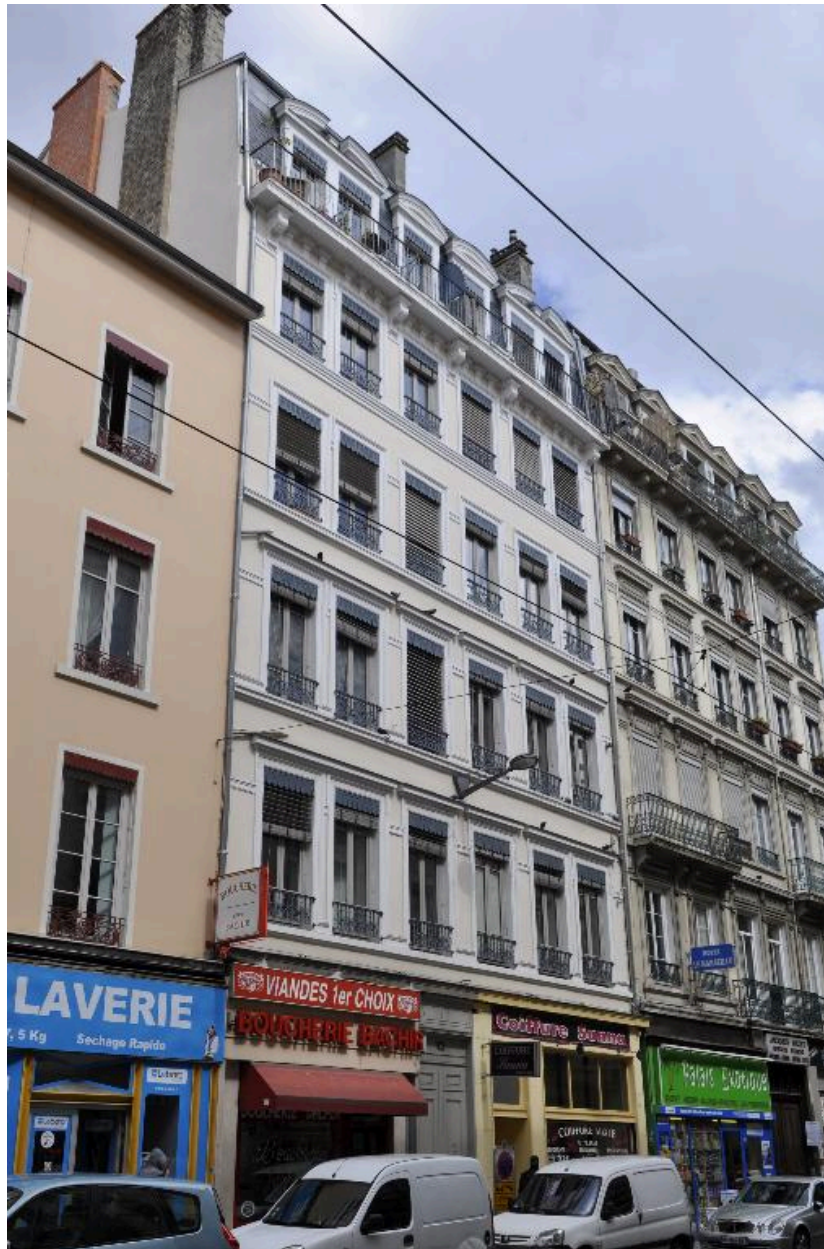
Vue générale de l'élévation sur rue
