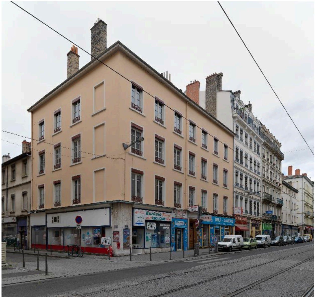
Vue de situation au sein de l'ilot
