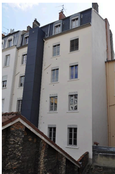
Elévation sur cour
