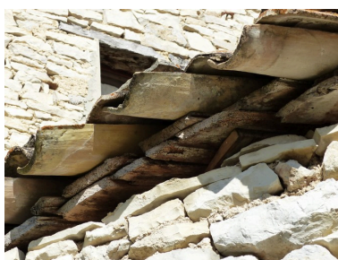
Etable à cochon, plancher de couverture. Phot. Alexeï Laurent IVR84_20162600549NUCA
