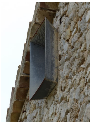
Pignon sud, troisième niveau. Baie du pigeonnier, protection ébrasée en zinc. Phot. Alexeï Laurent IVR84_20162600537NUCA
