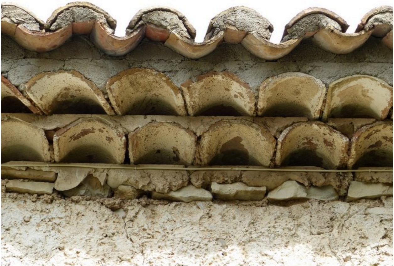
Elévation est, avant-toit constitué de deux rangs de gênoise, peints en blanc.
