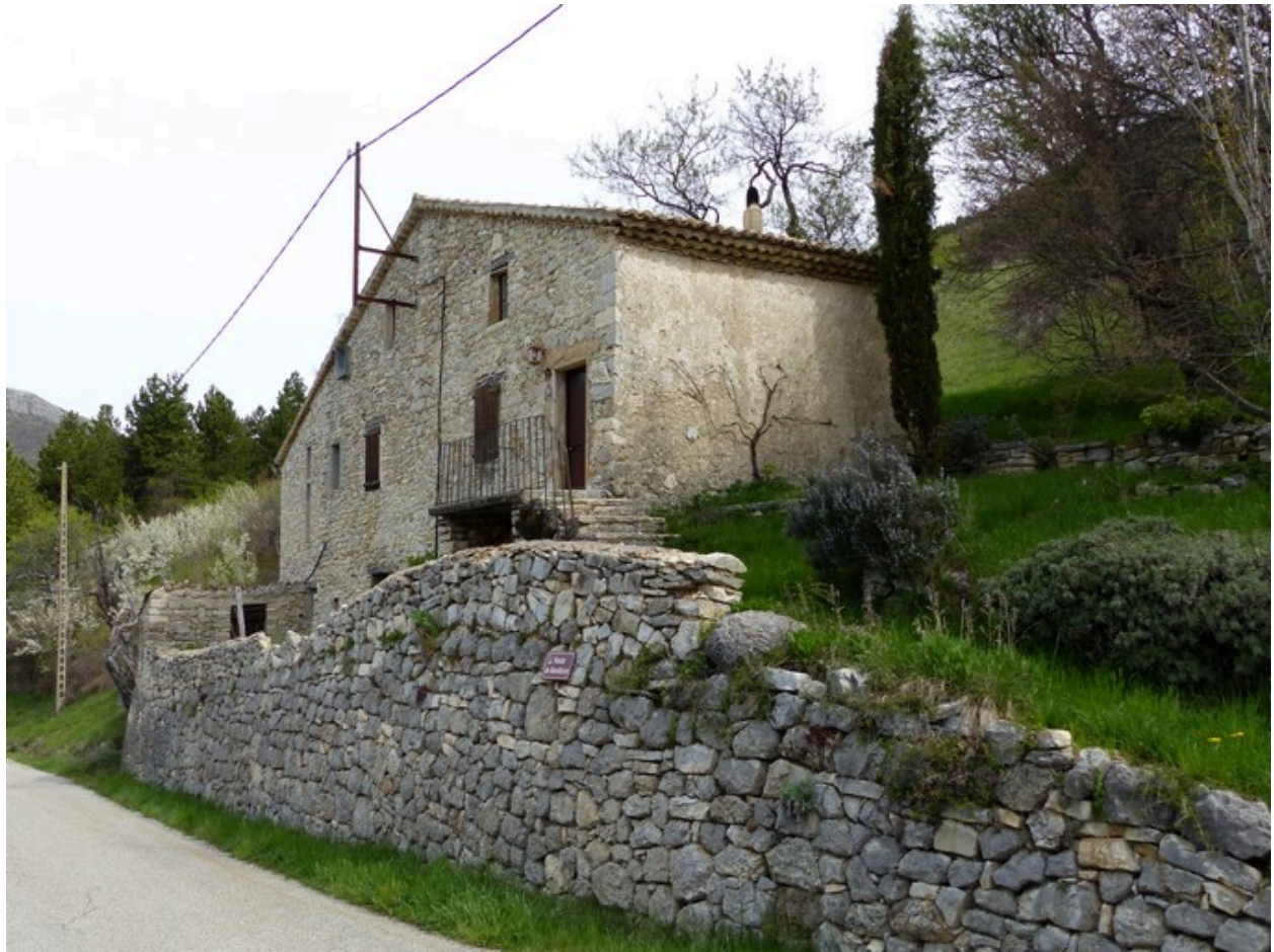
Vue d'ensemble prise du sud-est.
