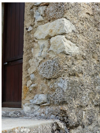
Base de la chaîne d'angle sud- est, gros moellons équarris en calcaire et en brèche calcaire. Phot. Alexeï Laurent IVR84_20162600533NUCA
