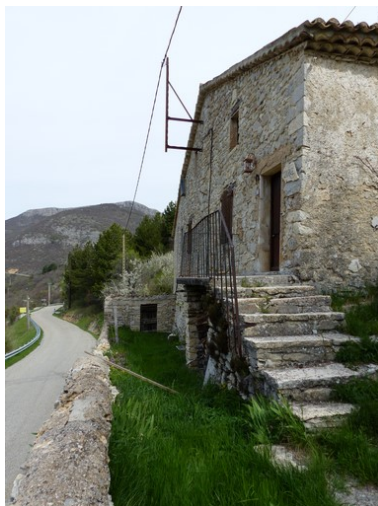
Cour devant l'élévation sud, vue prise de l'est. Phot. Alexeï Laurent IVR84_20162600531NUCA
