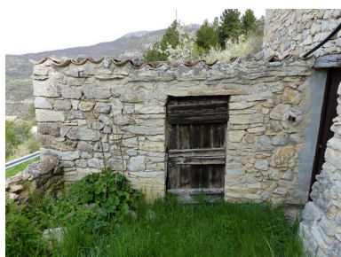
Etable à cochon, élévation est. Phot. Alexeï Laurent IVR84_20162600548NUCA
