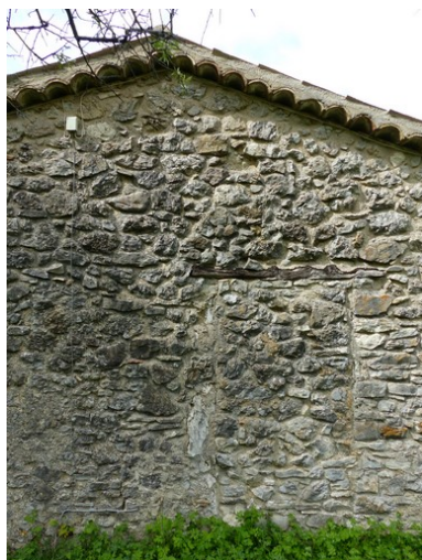
Pignon nord, porte murée. Phot. Alexeï Laurent IVR84_20162600542NUCA
