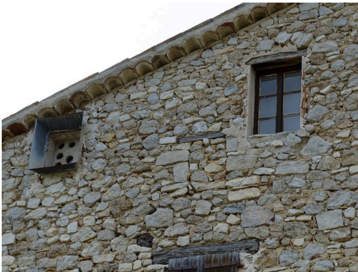
Pignon sud, troisième niveau. Jour muré.
