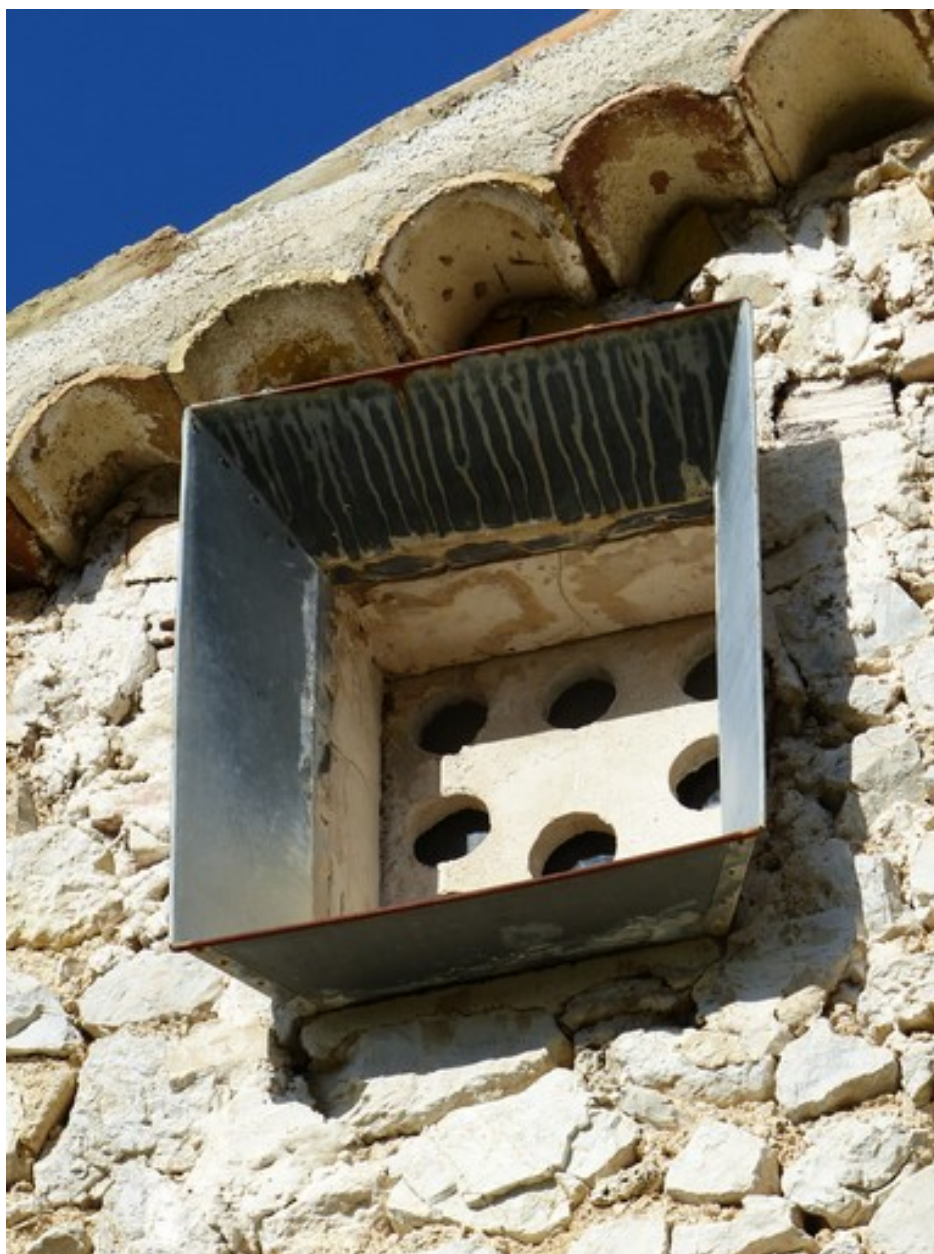
Pignon sud, troisième niveau. Baie du pigeonier.
