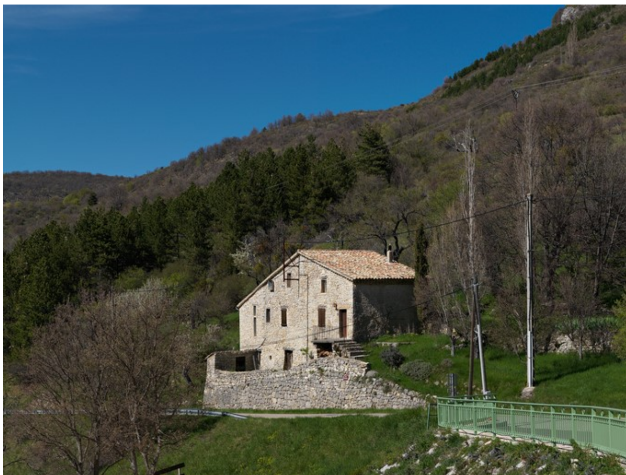
Vue de situation prise du sud-est.
