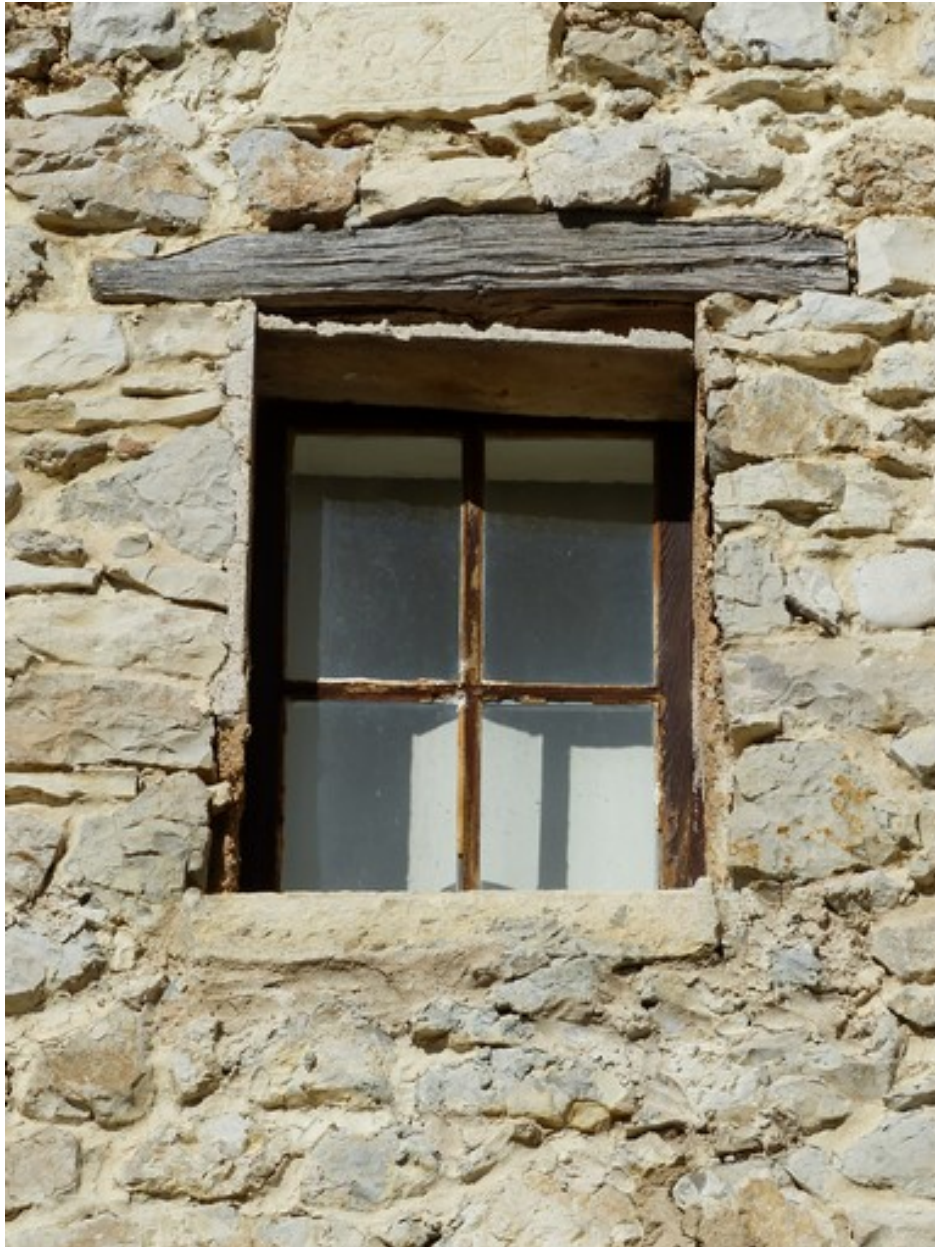
Pignon sud, troisième niveau. Fenêtre.
