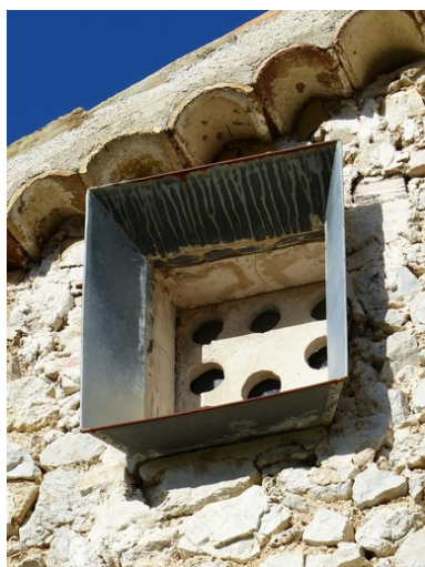
Pignon sud, troisième niveau. Baie du pigeonnier. Phot. Alexeï Laurent IVR84_20162600536NUCA
