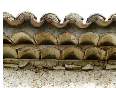
Elévation est, avant-toit constitué de deux rangs de génoise, peints en blanc. Phot. Alexeï Laurent IVR84_20162600544NUCA
