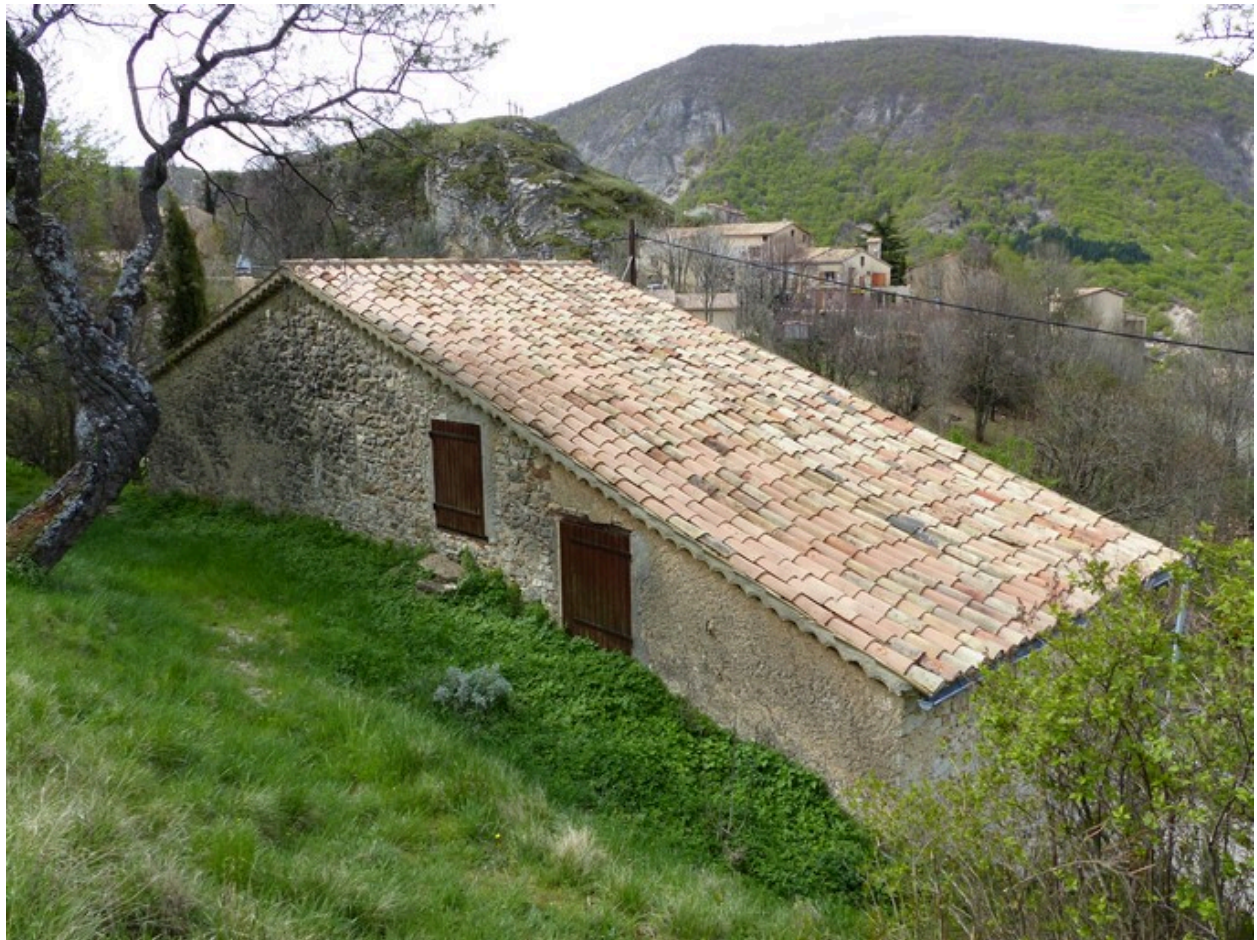
Vue d'ensemble prise du nord-ouest.
