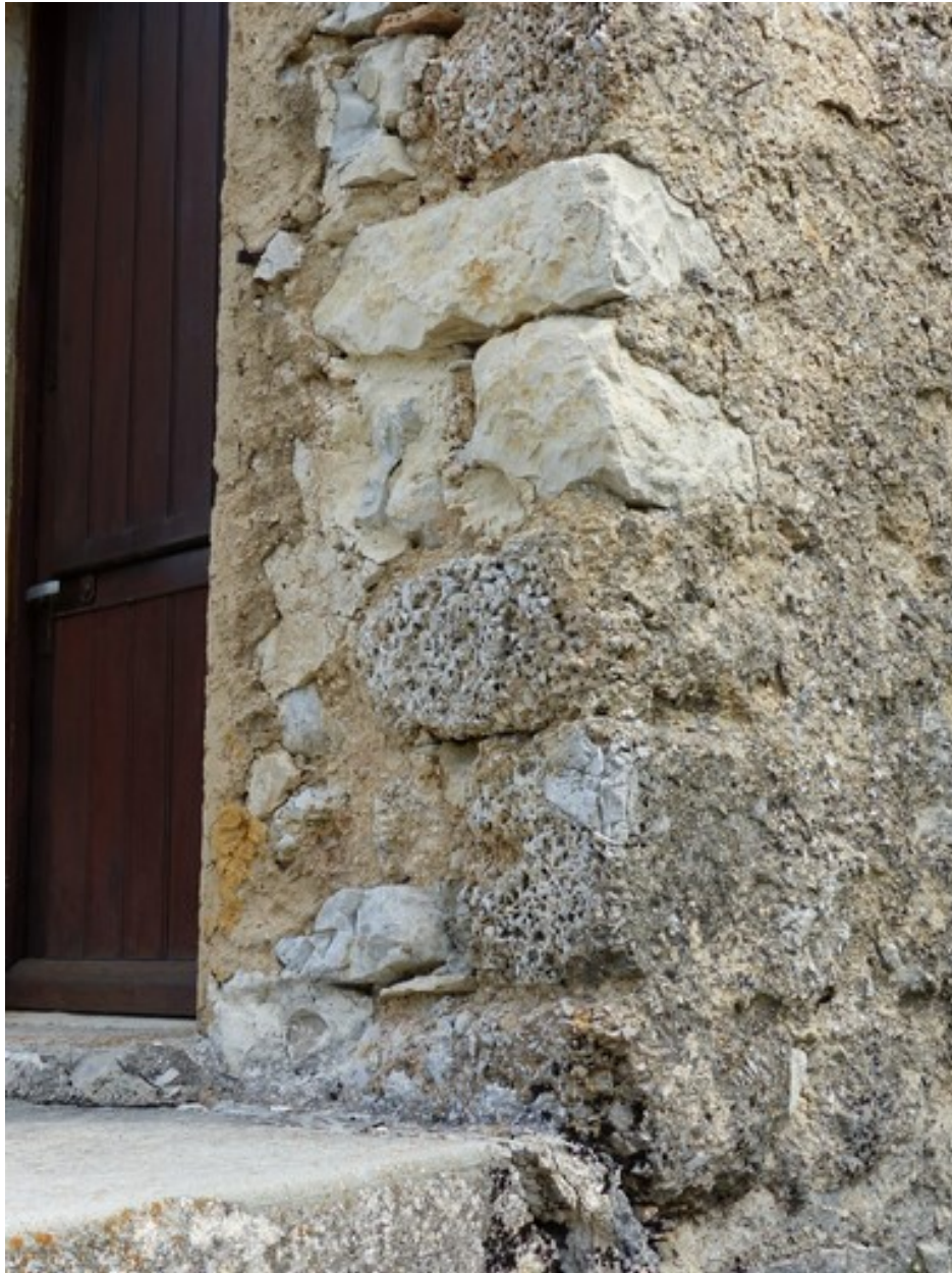
Base de la chaîne d'angle sud-est, gros moellons équarris en calcaire et en brèche calcaire.
