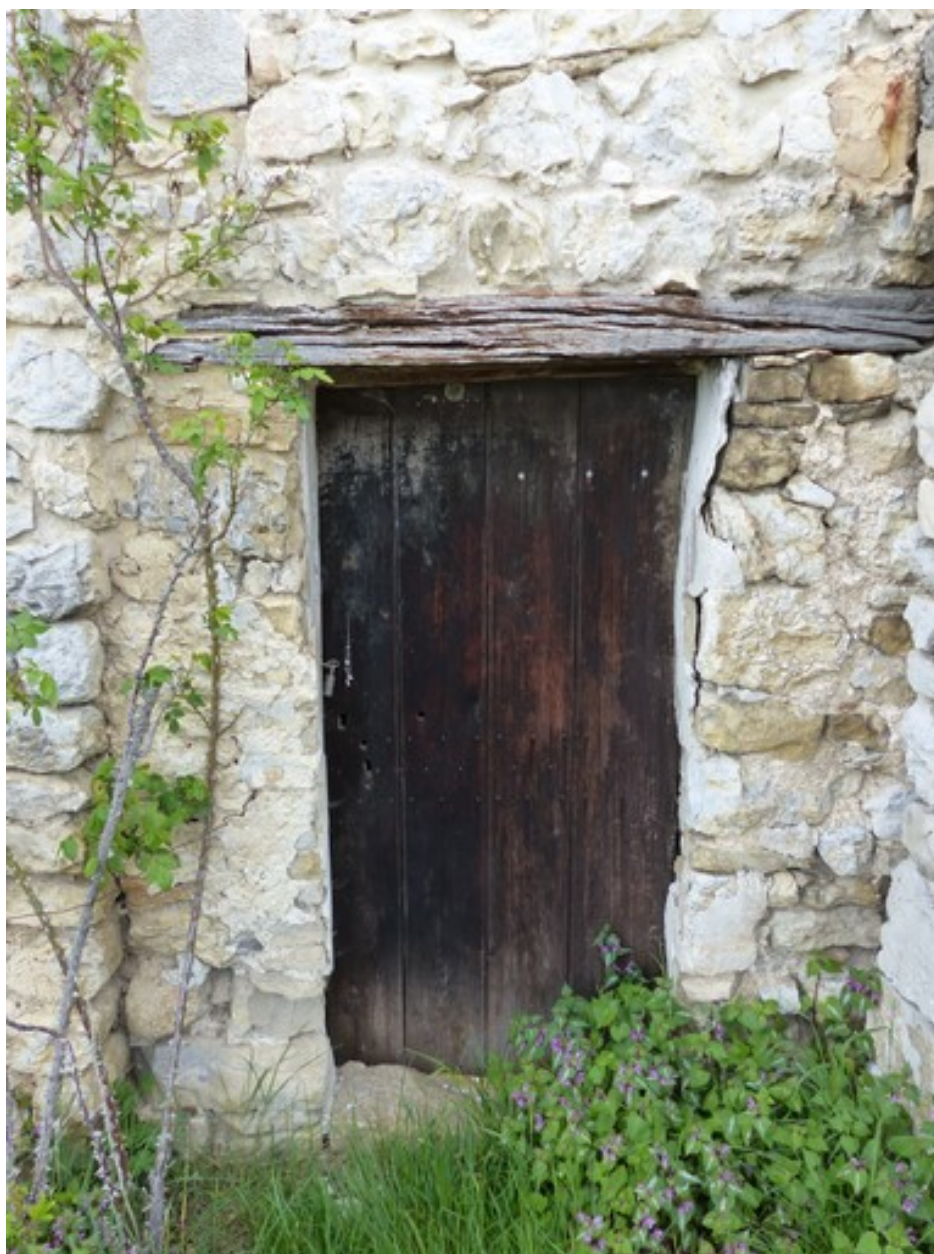
Pignon sud, premier niveau. Porte est.
