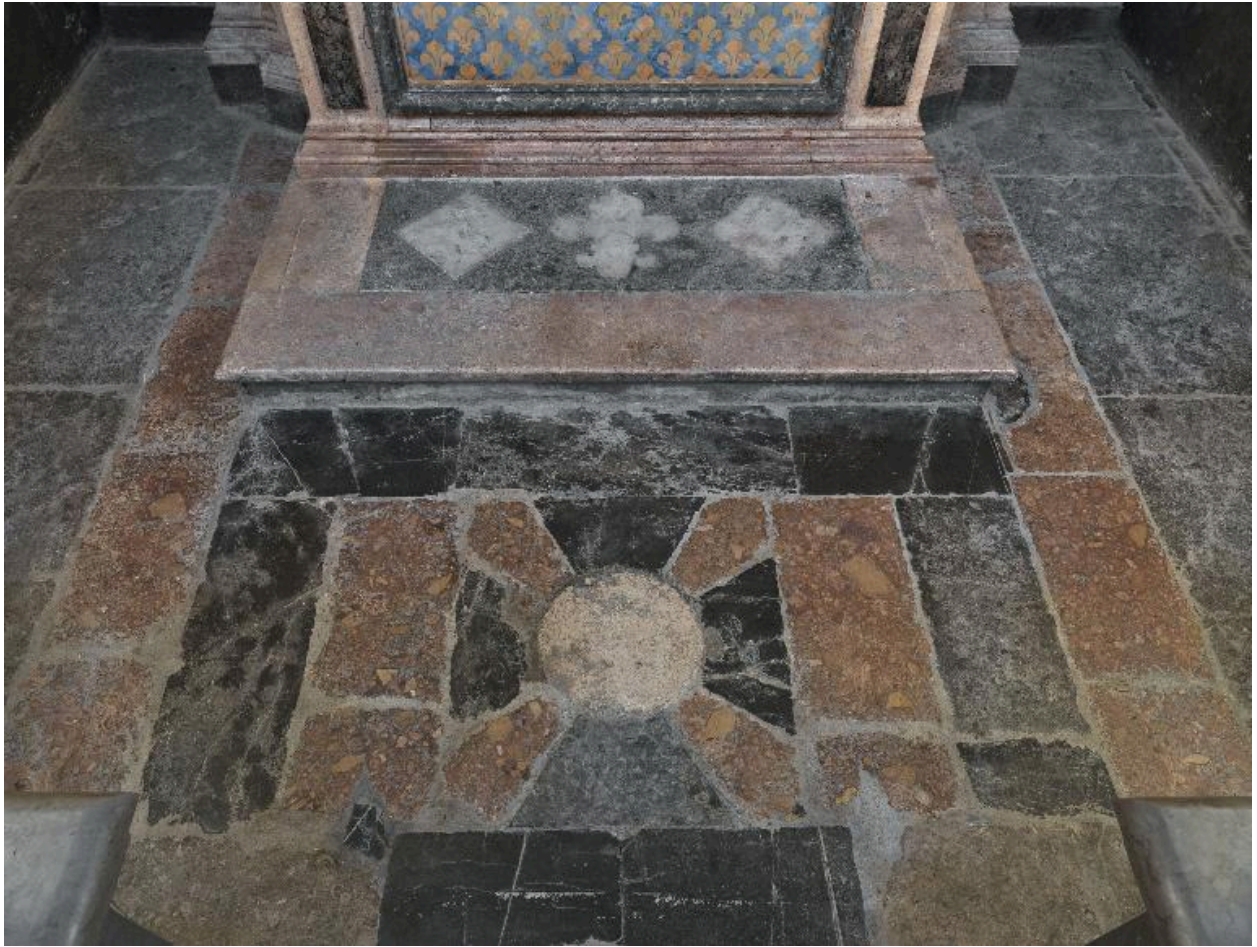
4e chapelle du bas-côté sud : détail du dallage
