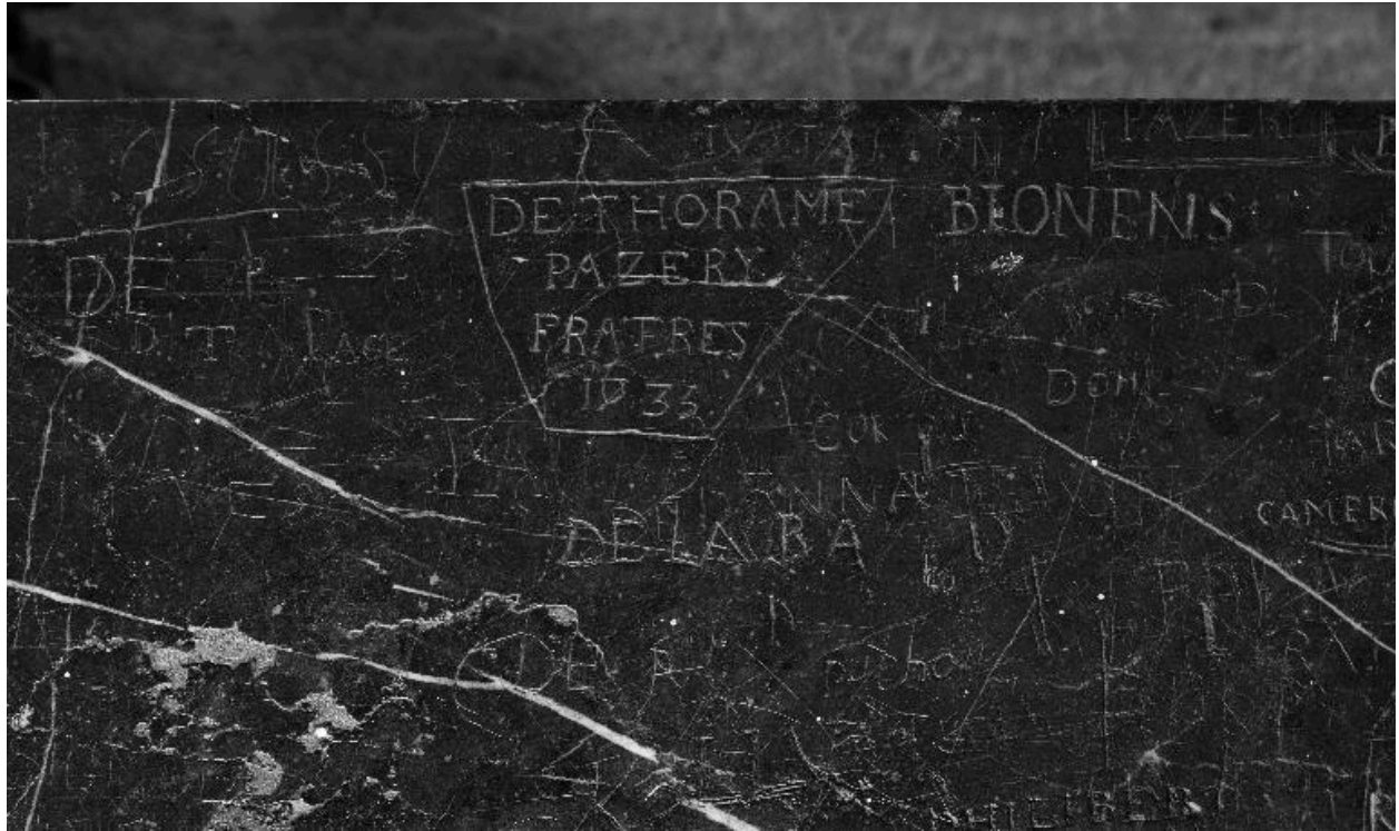
3e tribune sud, balustrade : graffiti, détail
