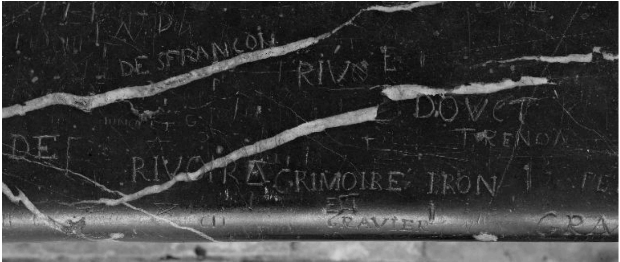
2e tribune sud, balustrade : graffiti, vue d'ensemble
