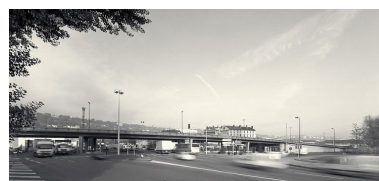
Vue d'ensemble du carrefour cours Charlemagne - quai Perrache Phot. Eric Dessert IVR82_20016902944V
