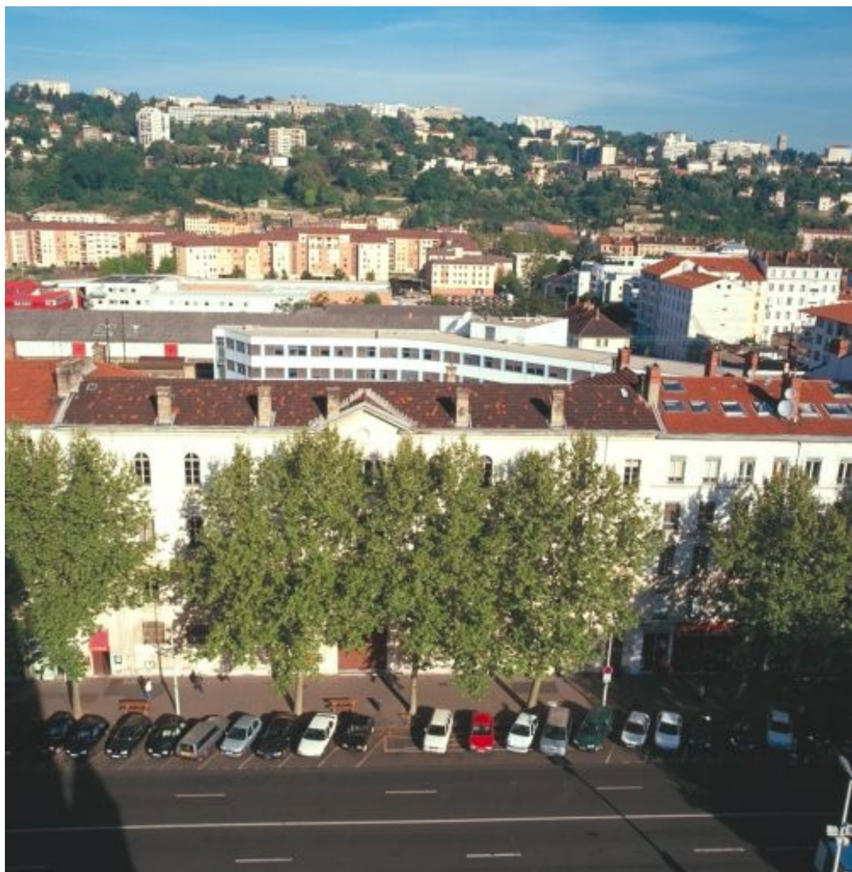
Vue d'ensemble, à la hauteur de la place de l'Hippodrome, depuis le clocher de l'église Sainte-Blandine
