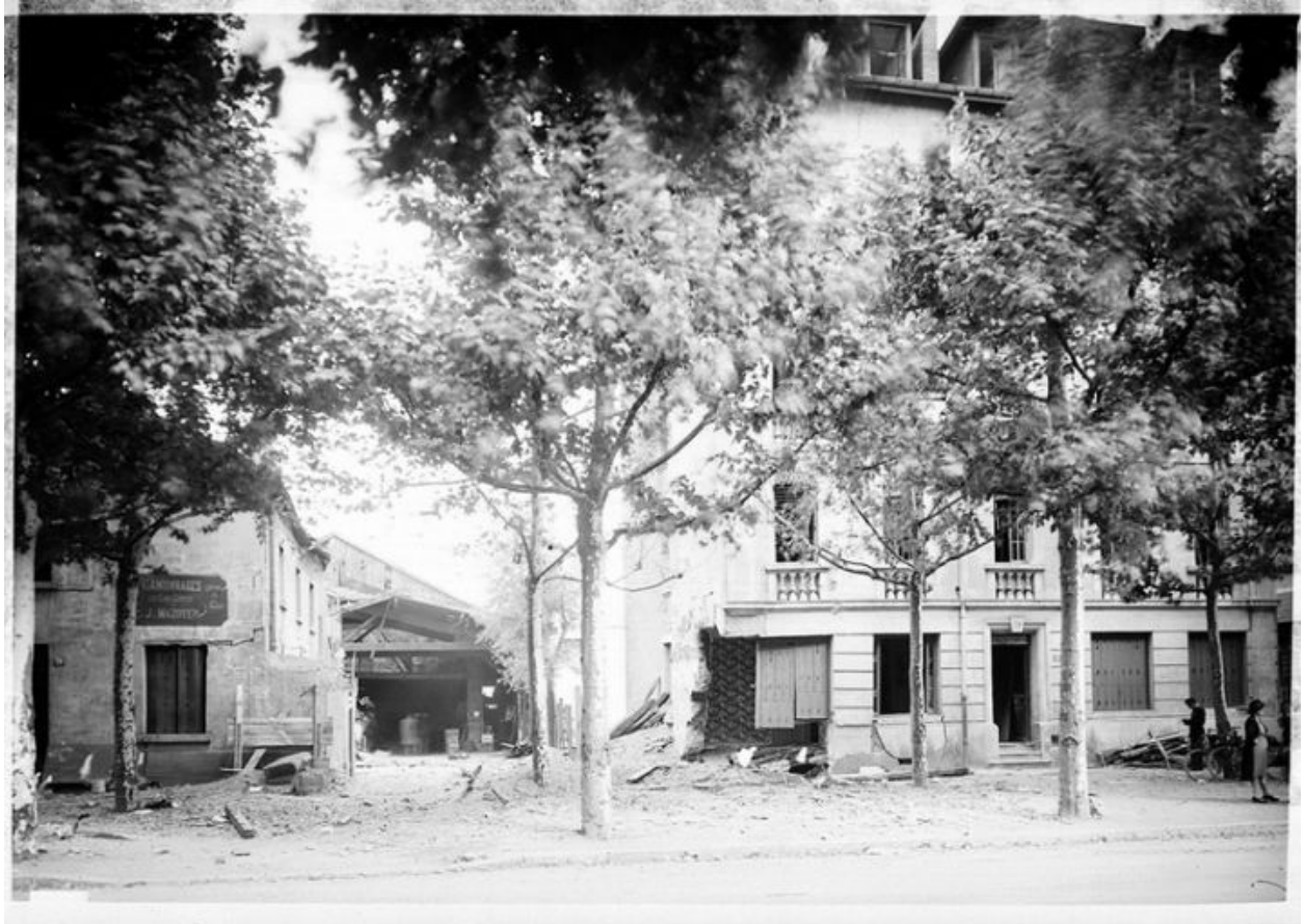
Bombardement de Lyon par l'aviation alliée le 26 mai 1944. Destruction de l'immeuble 81 cours Charlemagne
