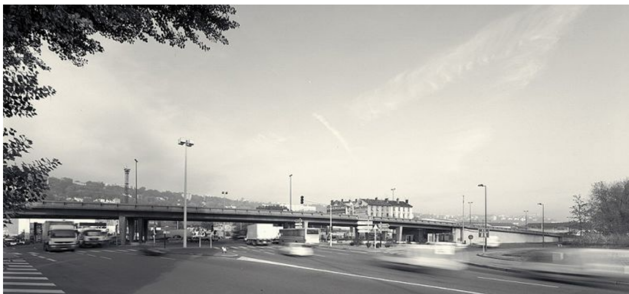
Vue d'ensemble du carrefour cours Charlemagne - quai Perrache
