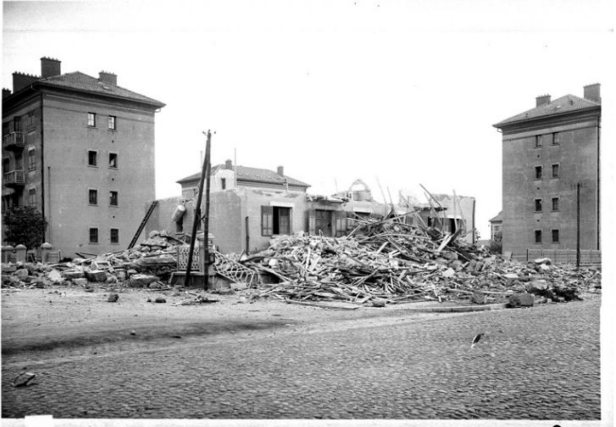
Bombardement de Lyon par l'aviation alliée le 26 mai 1944. Destruction de l'immeuble 101 cours Charlemagne
