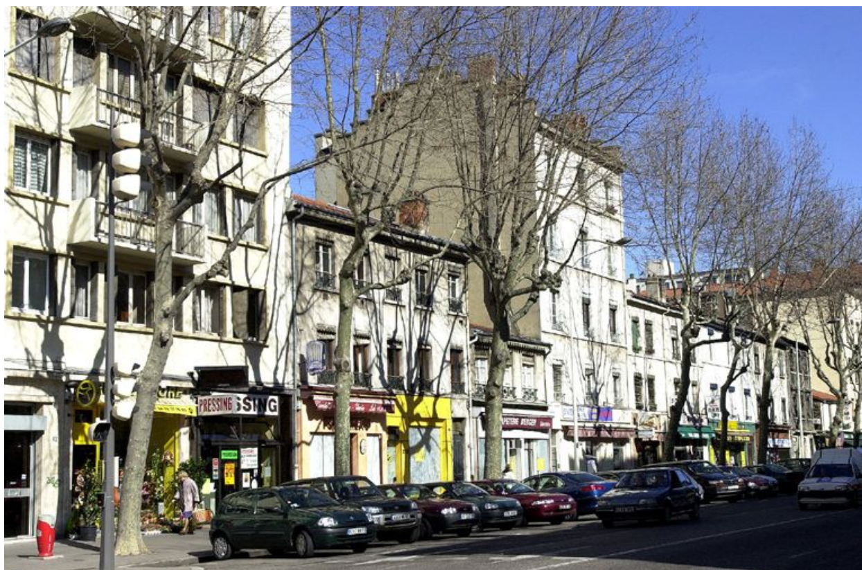
Vue d'ensemble des différences de hauteurs des immeubles longeant le cours à l'ouest, entre la rue Bichat et le cours Suchet
