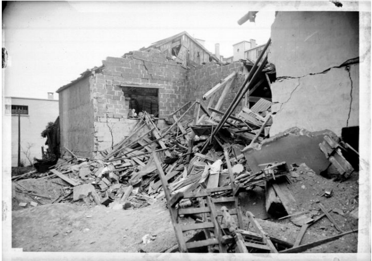
Bombardement de Lyon par l'aviation alliée le 26 mai 1944. Destruction de l'immeuble 79 cours Charlemagne
