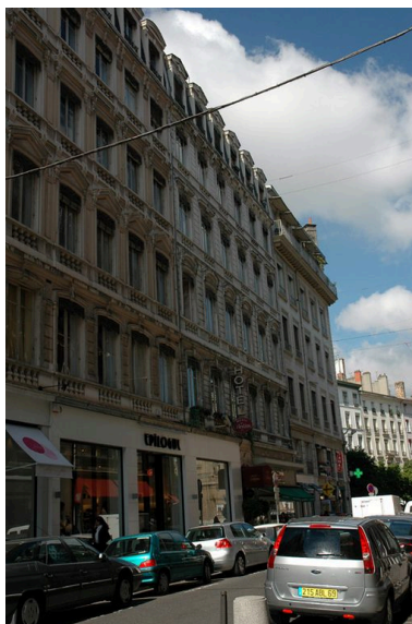
Élévation antérieure Phot. Véronique Belle IVR82_20066902587NUCA
