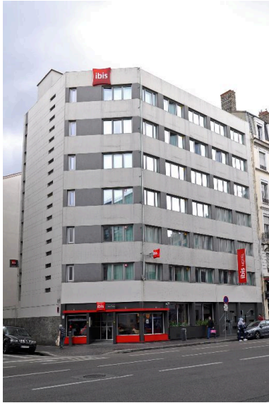
Vue d'ensemble, prise depuis l'ouest Phot. Magali Delavenne IVR84_20176901455NUCA
