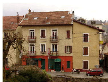
Façade sur rue Phot. François Fouger IVR82_20097300142NUCA
