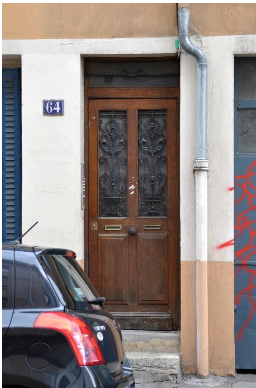
Vue rapprochée de la porte d'entrée
