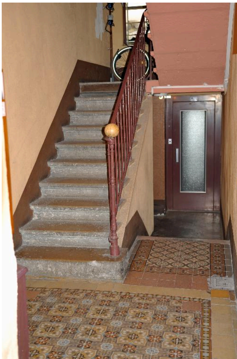
Vue intérieure, le départ de l'escalier et l'ascenseur ajouté en contrebas, pavement remanié
