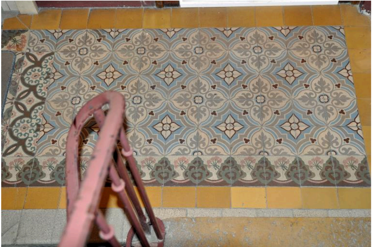
Vue intérieure, pavement en carreaux de ciment polychromes remanié, sur le premier palier
