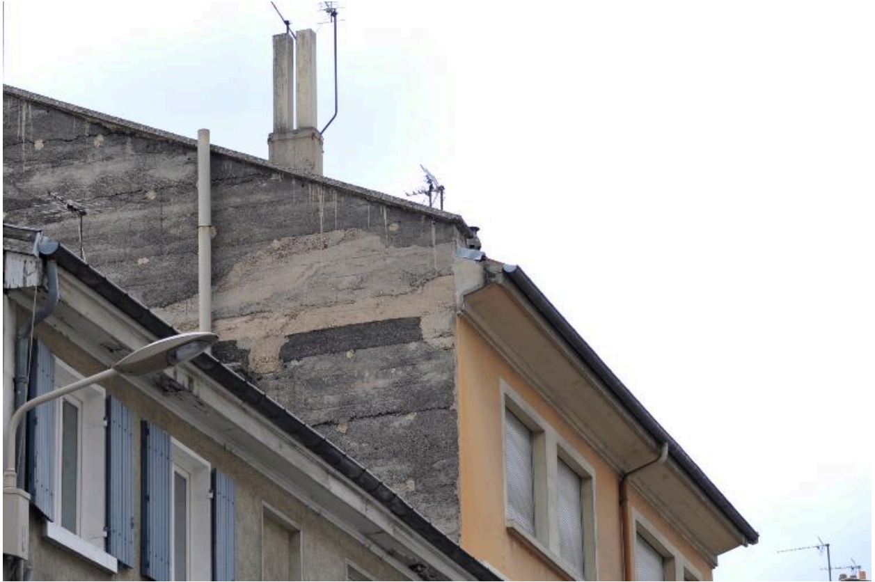
Vue du pignon sud, mâchefer et béton apparents
