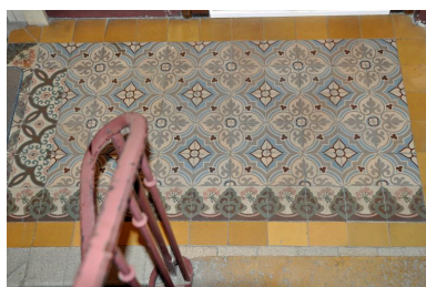
Vue intérieure, pavement en carreaux de ciment polychromes remaniés, sur le premier palier Phot. Magali Delavenne IVR84_20176901431NUCA
