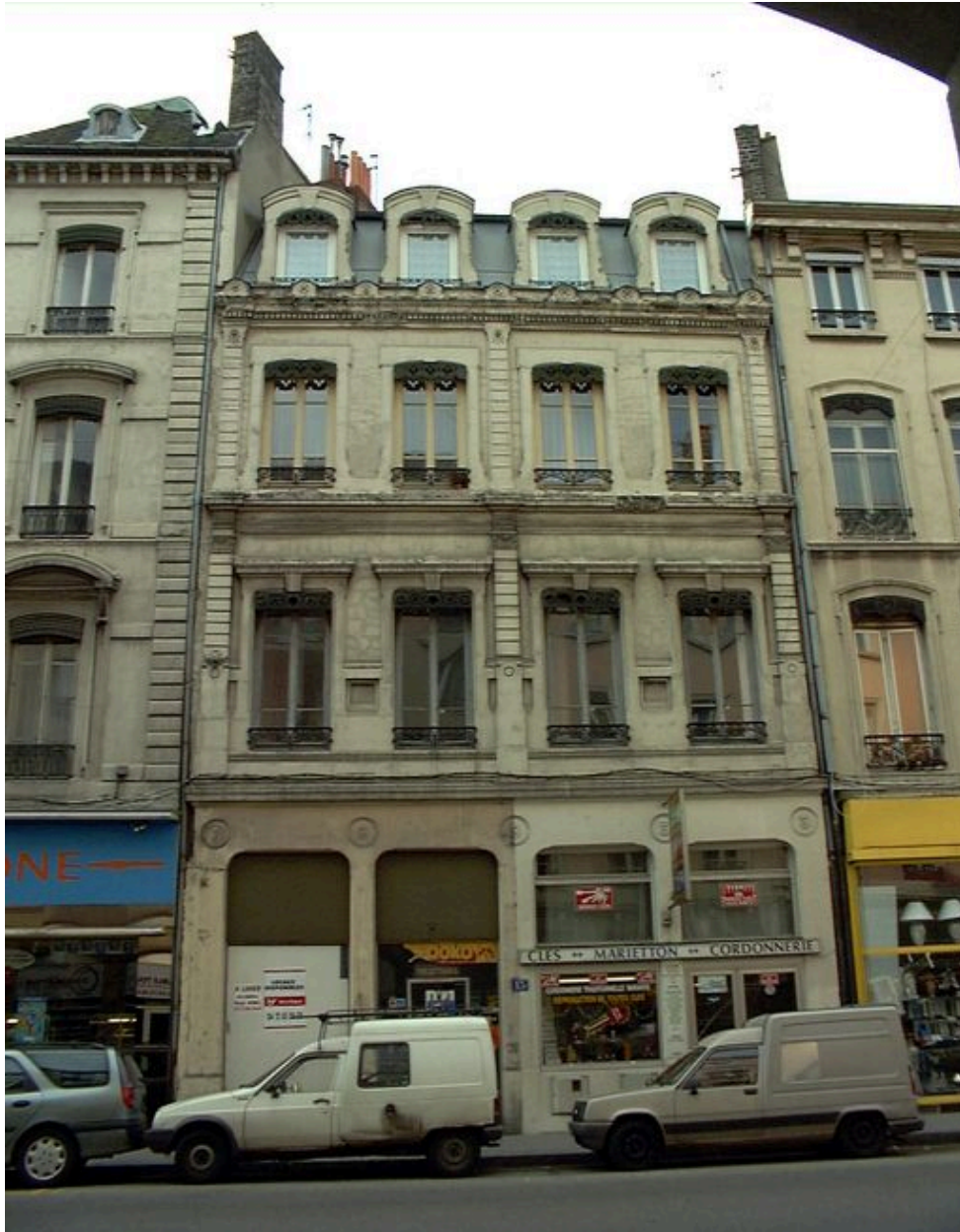
Immeuble, 13, rue Marietton : élévation antérieure
