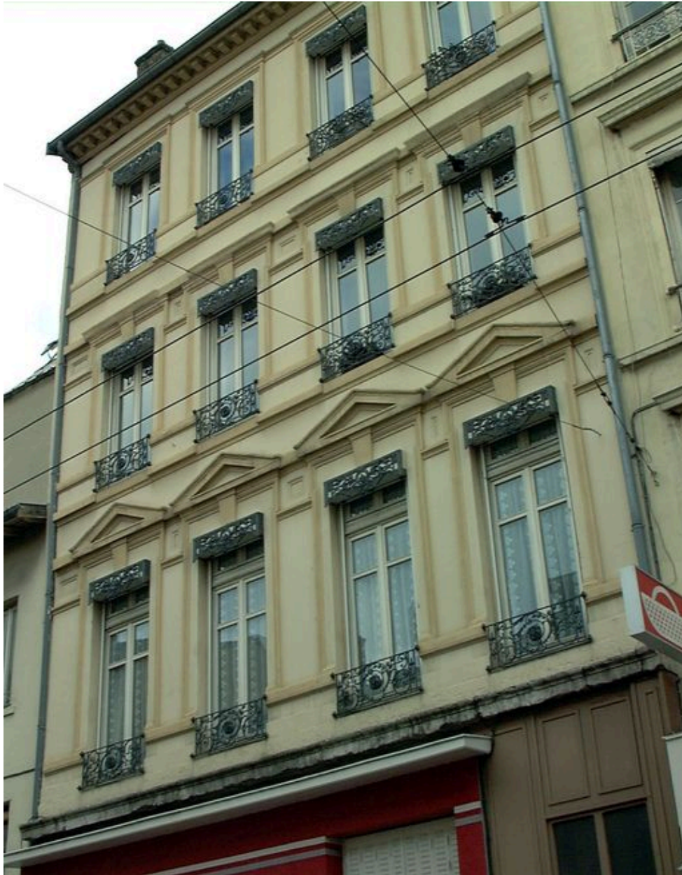
Immeuble, 9, grande rue de Vaise : partie supérieure de l'élévation antérieure
