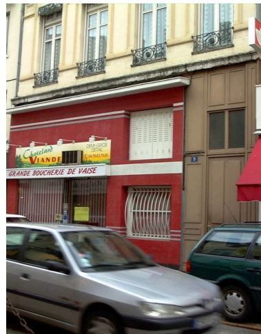
Immeuble, 9, grande rue de Vaise : détail du rez-de-chaussée, entrée de l'immeuble et boutique Phot. Maryannick Chalabi IVR82_20006900365NUCA
