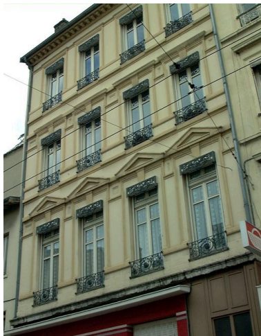
Immeuble, 9, grande rue de Vaise : partie supérieure de l'élévation antérieure Phot. Maryannick Chalabi IVR82_20006900364NUCA
