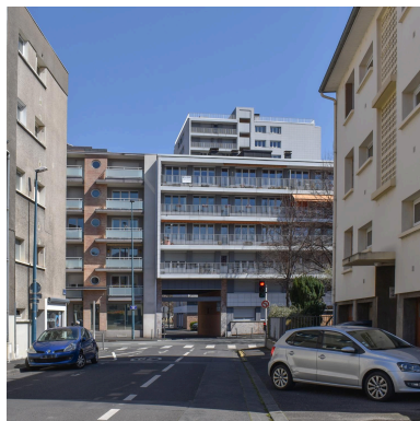
Passage en rez-de-chaussée menant du boulevard Aristide- Briand à la place de Regensburg Phot. Félicie Fougère IVR84_20256302286NUCA
