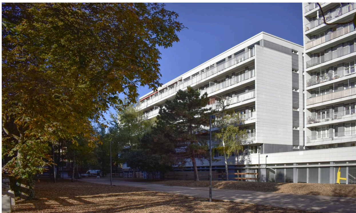
Allée piétonne menant du boulevard Aristide-Briand à la place de Regensburg. Façade au sud-ouest
