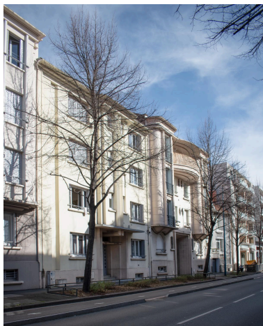
Façades sur le boulevard Aristide-Briand Phot. Félicie Fougère IVR84_20256300791NUCA
