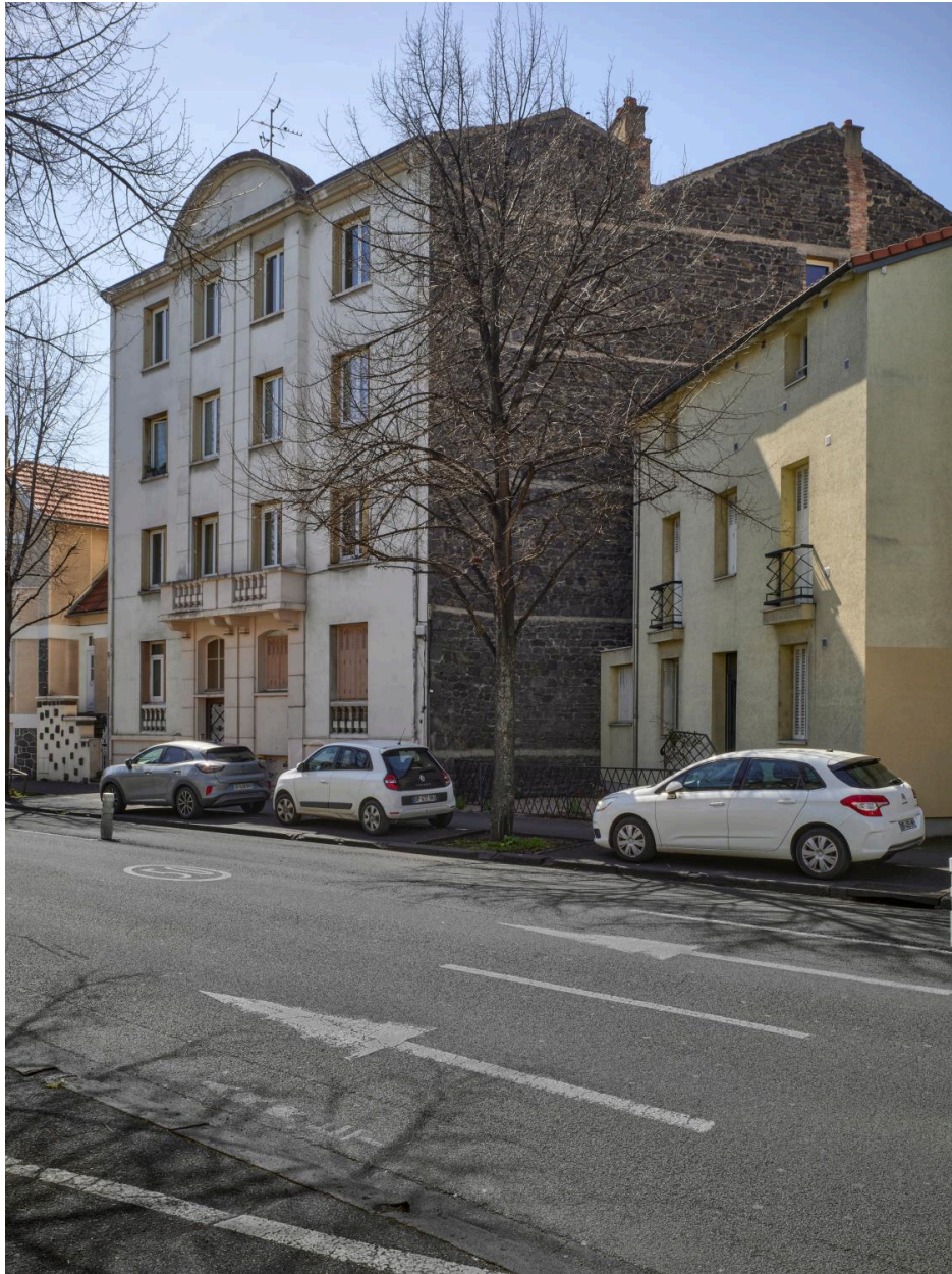
Rupture d'alignement, mur d'héberge et pignon d'alignement
