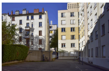
Élévation postérieures Phot. Félicie Fougère IVR84_20256300634NUCA
