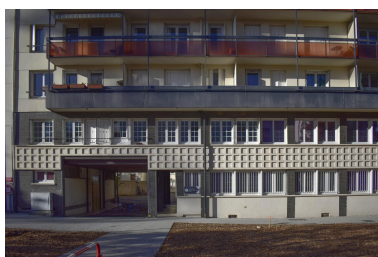
Passage en rez-de-chaussée menant de la place Regensburg au boulevard Aristide-Briand Phot. Félicie Fougère IVR84_20256302284NUCA
