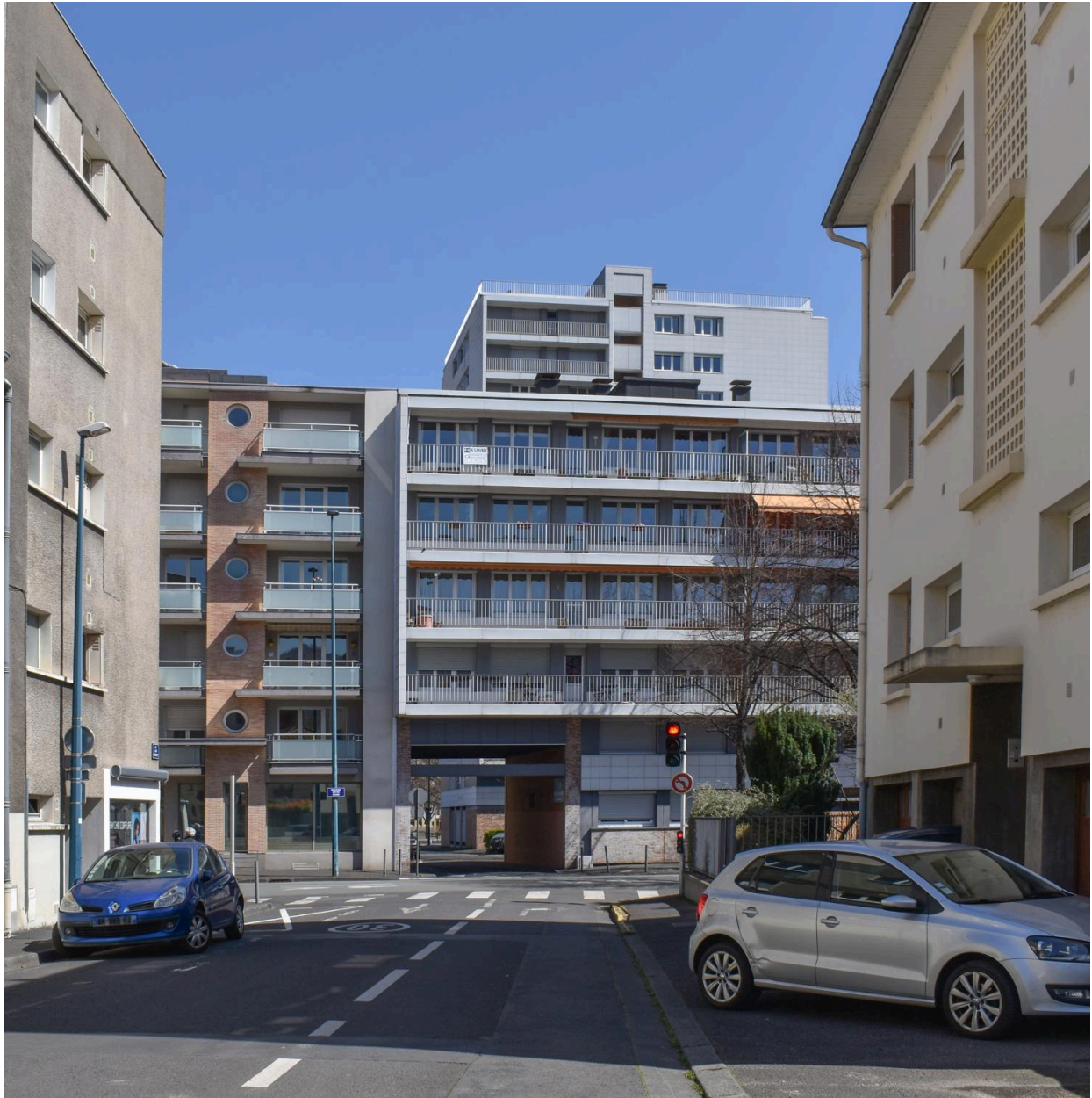
Passage en rez-de-chaussée menant du boulevard Aristide-Briand à la place de Regensburg
