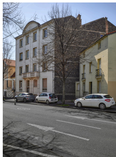
Rupture d'alignement, mur d'héberge et pignon d'alignement Phot. Christian Parisey IVR84_20236300384NUC4A
