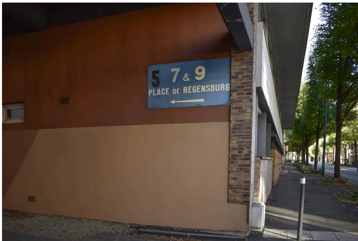
Passage en rez-de-chaussée menant du boulevard Aristide-Briand à la place de Regensburg
