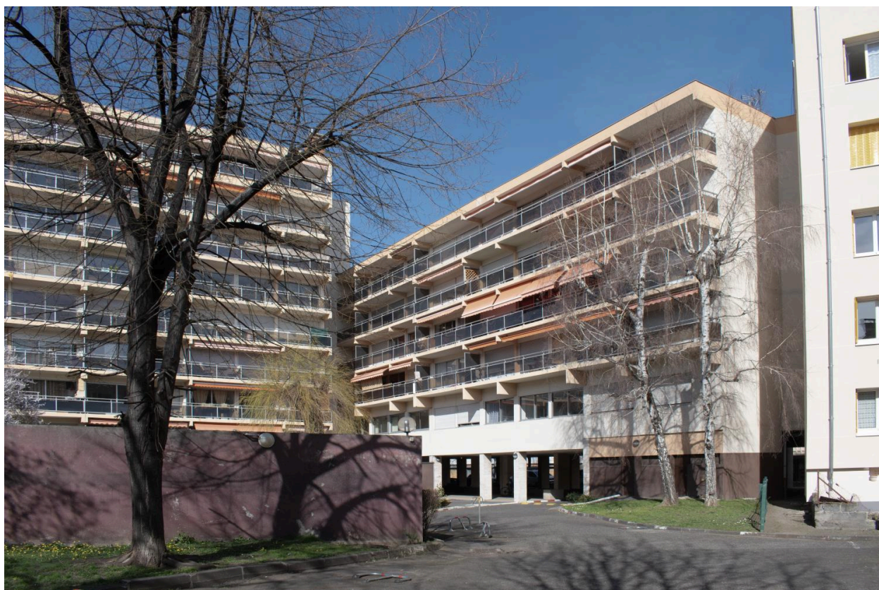
Elévation postérieure et façade sur cour
