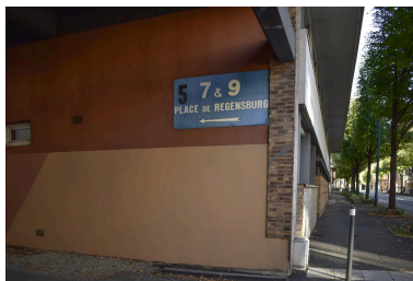
Passage en rez-de-chaussée menant du boulevard Aristide- Briand à la place de Regensburg Phot. Félicie Fougère IVR84_20256302285NUCA
