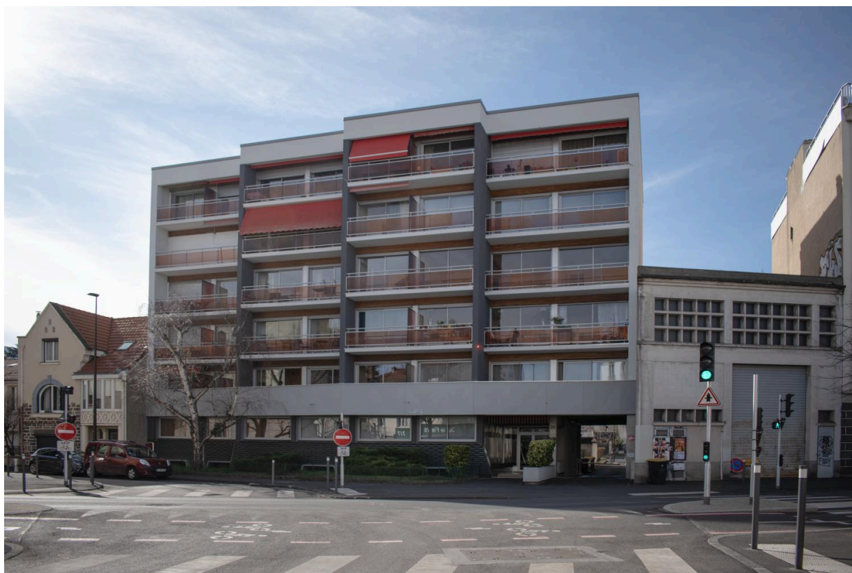
Façade sur le boulevard Aristide-Briand
