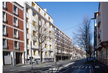
Façades sur le boulevard Aristide-Briand Phot. Félicie Fougère IVR84_20256300595NUCA
