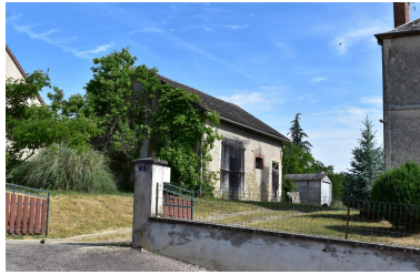
Dépendances du presbytère Phot. Maryse Durin-Tercelin IVR84_20230300518NUC4A
