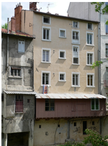
Façade sur Gère Phot. Isabelle Dupuis IVR82_20093800572NUCA
